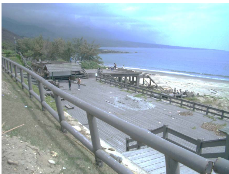
圖 3 杉原海水浴場沙灘與路面的高差，原以木作平台方式搭建至沙灘。
