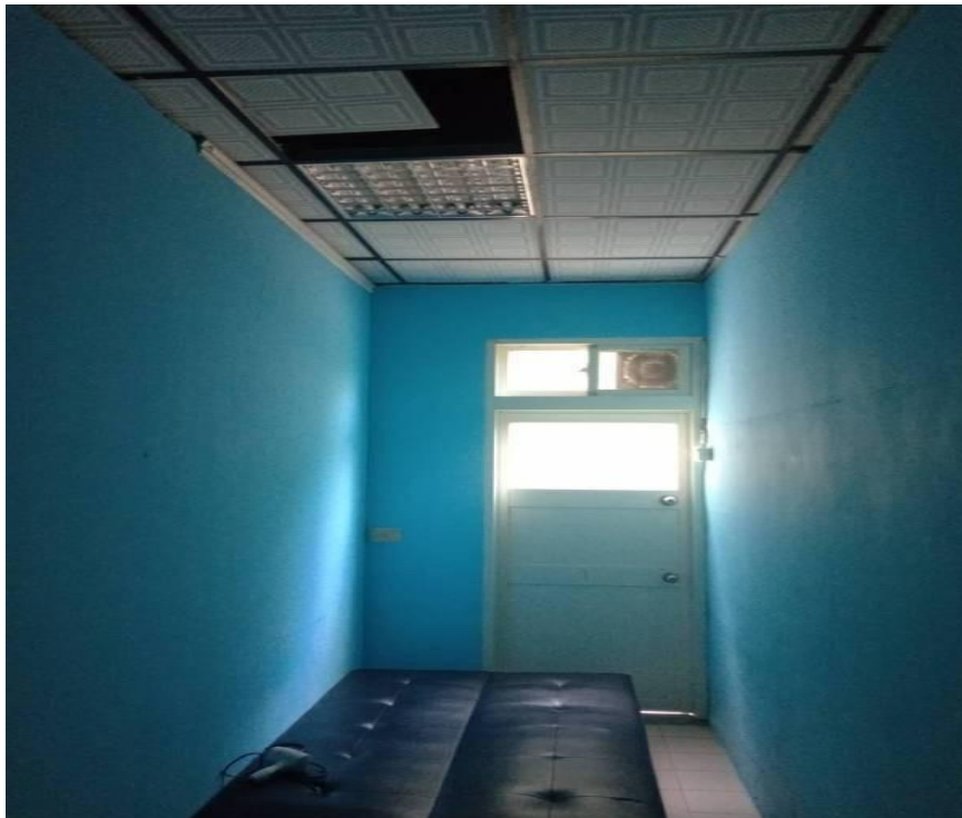
圖 1 德芳教養院隔離室 1
