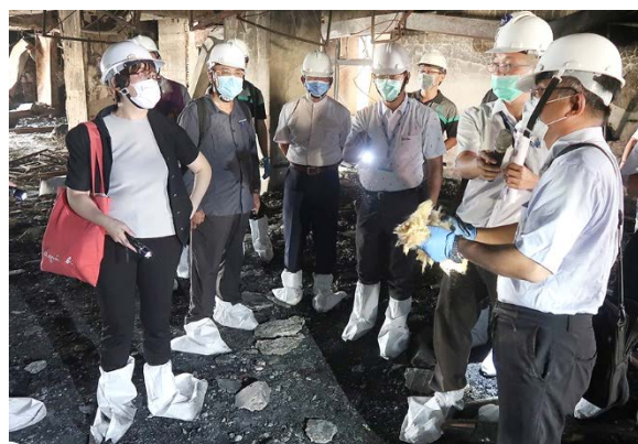
調查委員葉大華(左 1)、浦忠成(左 2)實地履勘喬友大樓 2 樓-起火樓層(間置未使用)及原裝潢使用泡棉 110/10/06
