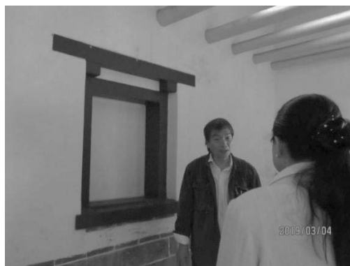
照片 1、古蹟原貌遭變更，屋脊粘黏消失不見（左）、窗戶型式變更且封閉（右）
