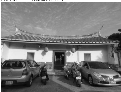
照片 1、古蹟原貌遭變更，屋脊粘黏消失不見（左）、窗戶型式變更且封閉（右）
