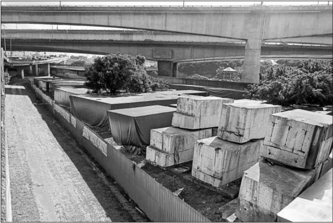
圖 3 中山橋（明治橋）被肢解成 435 塊石塊 13
