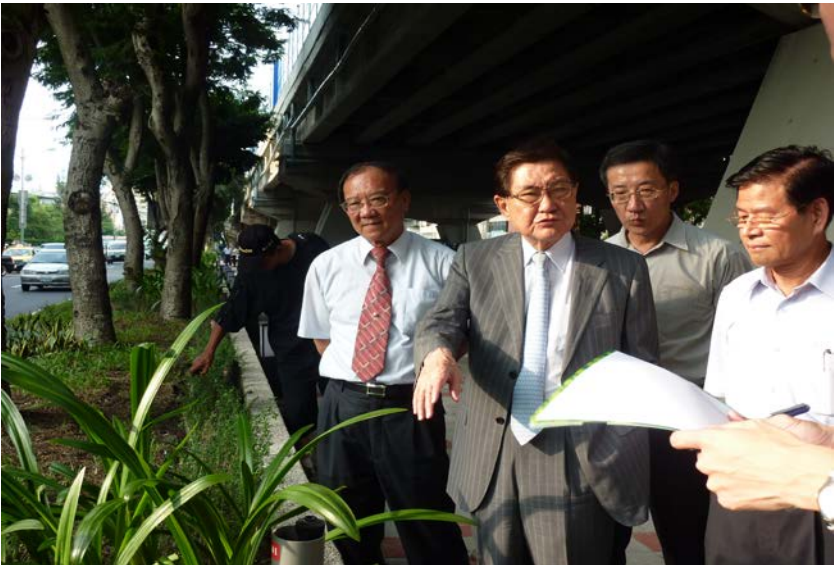
監察委員於 2010 年 9 月 6 日赴新生高架橋履勘
