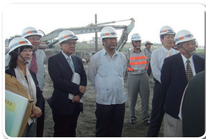
監察委員巡視台1線新埤大橋改建工程
