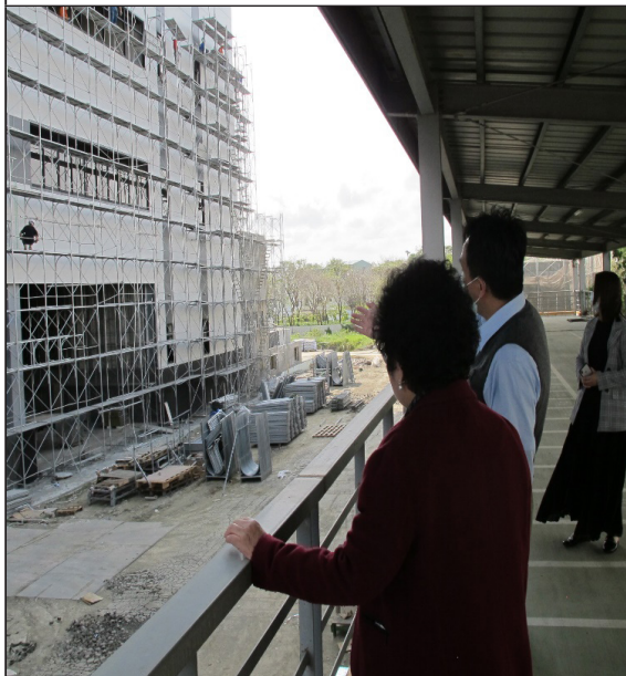
H 公司主管人員說明該公司興建廠房進度。
