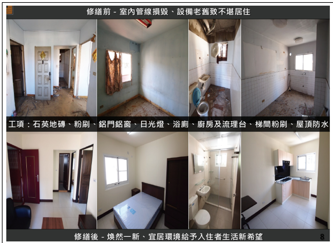
圖13、鳳山共合宅修繕前後比較情形
