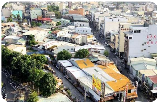
Foto 3 En el Área Xin Cao Ya falta un modelo de gestión para la planificación y construcción
