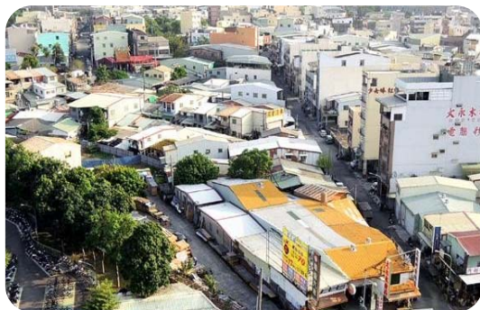
圖 3 新草街建築缺乏都市計畫規範與建築管理
