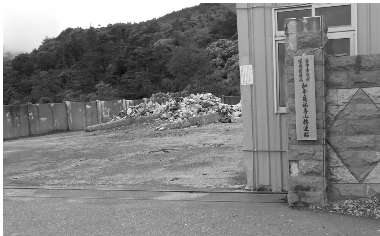
臺中市政府環保局和平區福壽山垃圾轉運站
