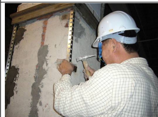
【照片 5-2-37】鐵製護角釘至木磚上 970131
