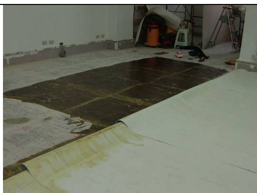
【照片 5-5-6】橡膠地毯鋪設 970325
