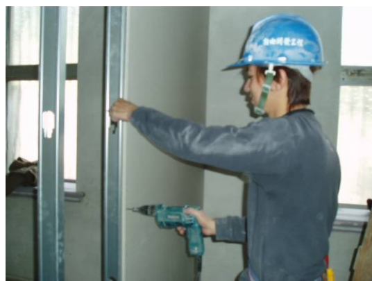
【照片 5-2-61】使用螺絲固定
