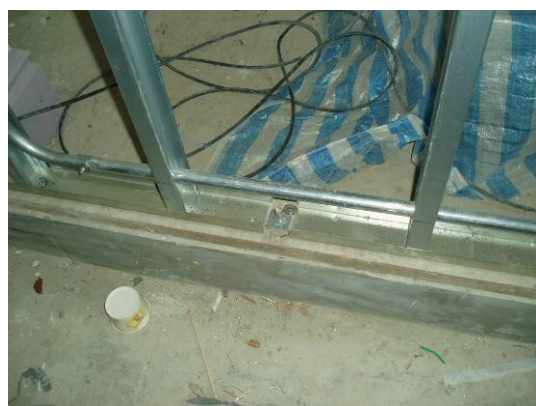
【照片 5-2-59】固定在原有臺基上
