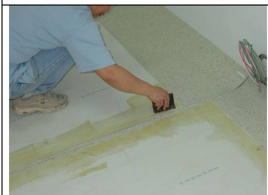
【照片 5-5-7】橡膠地毯鋪設 970325
