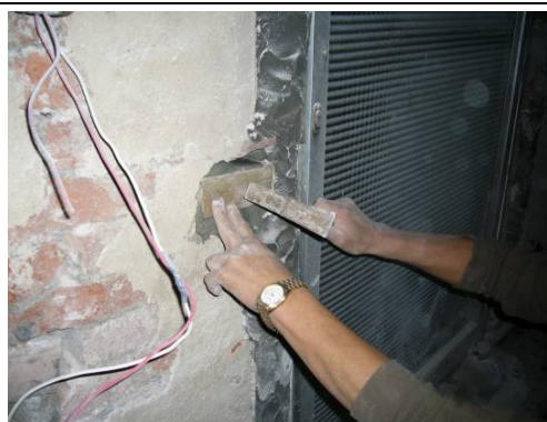
【照片 5-2-32】使用鐵鎚將木磚敲入 970126
