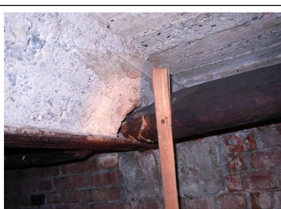
【照片 3-1-2】混凝土樑與樓板轉角處為斜面
