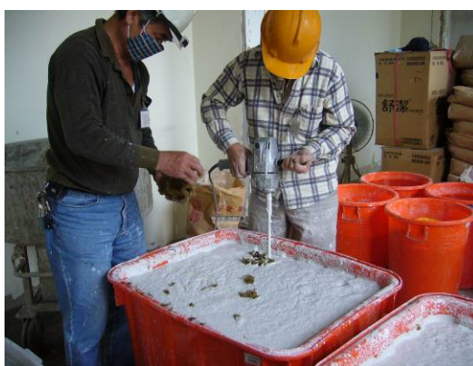
【照片 5-2-22】使用攪拌機攪拌 961209
