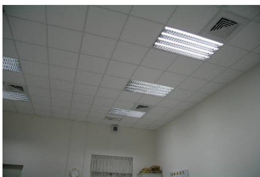
【照片 5-4-12】置入日光燈組即完成 970512
