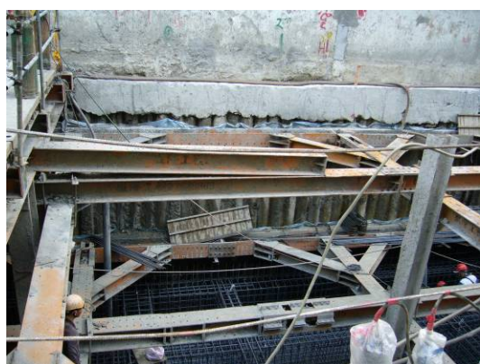
【照片 5-2-9】臺北市民樂街 64 號新建工程 970103
