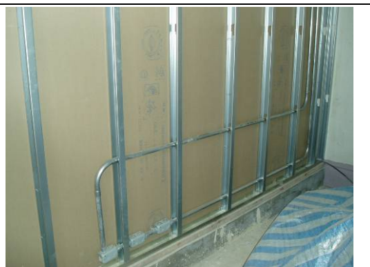
【照片 5-2-63】單側石膏板固定
