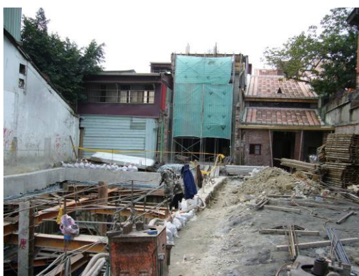
【照片 5-2-10】臺北市民樂街 64 號新建工程 970103
