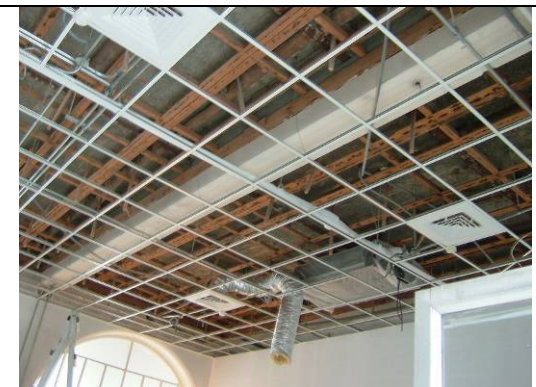
【照片 5-4-6】輕鋼架鋪設 970228
