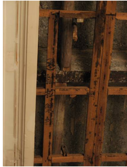
天花構架印有「植松製材」字樣
