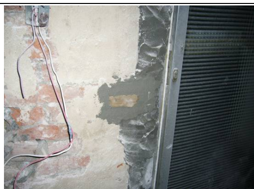
【照片 5-2-33】再使用砂漿填補面層 970126
