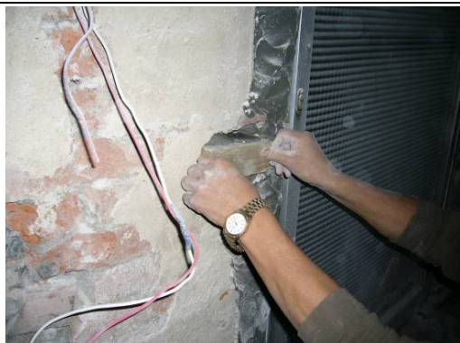
【照片 5-2-31】先將砂漿填入磚孔，再將木磚填入 970126
