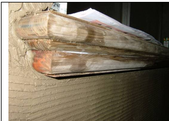
【照片 5-3-13】粗糠土層施工收邊 970130
