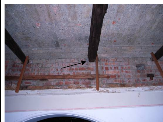
【照片 3-1-12】原木樑與工字形鋼樑平行部分，原木樑頭尾兩端則置於磚牆上部預留的孔洞中。
