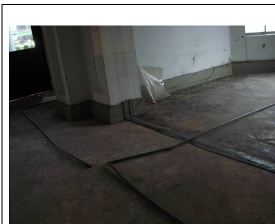
【照片 5-9-1】先在地面上依施工圖試排 1” PVC 管 961126
