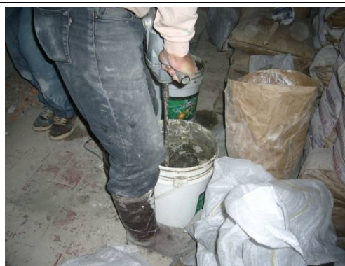
【照片 5-2-30】使用攪拌機攪拌 970126
