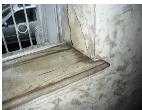
【照片 5-2-38】固定窗台板 970131
