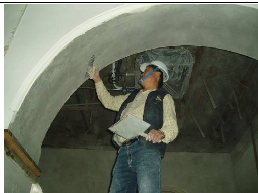
【照片 5-2-53】施作白灰面層修補拱形 970227
