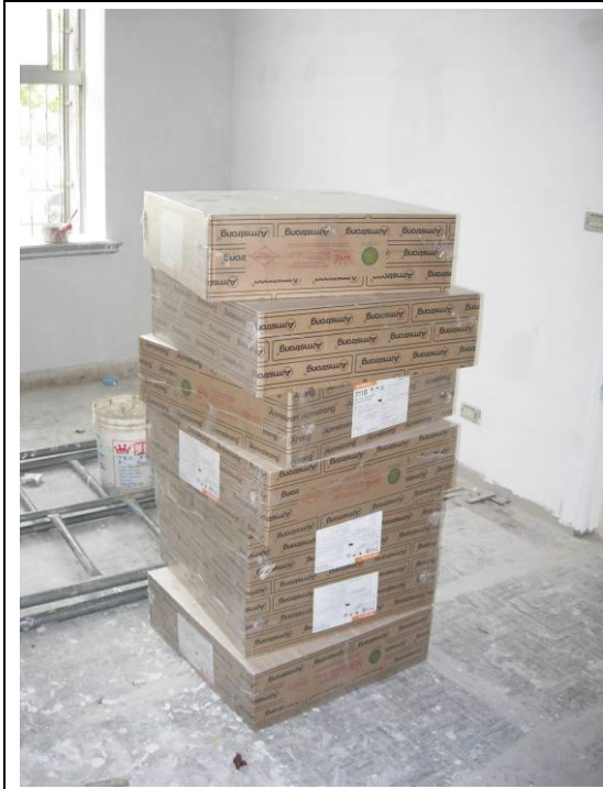
【照片 5-4-3】明架吸音平版天花進場 970316
