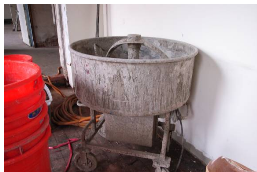
【照片 5-2-49】白灰麻絨與砂的攪拌槽 961207
