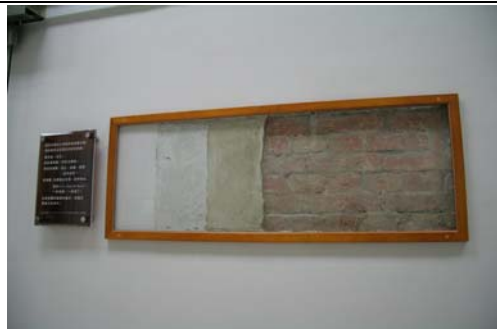
【照片 5-2-56】牆體粉刷層展示窗
