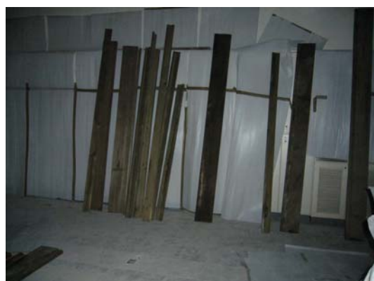
【照片 5-3-3】防腐木料進場 970130
