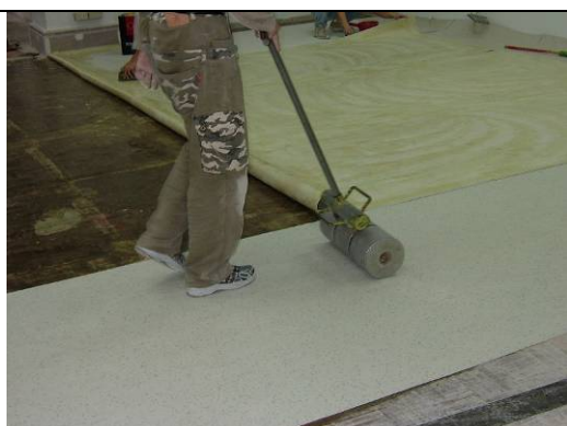
【照片 5-5-8】使用滾輪整平 970325
