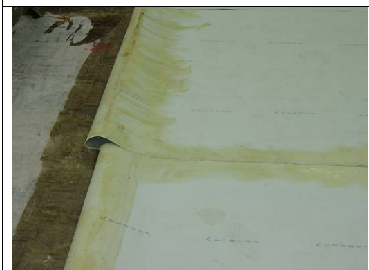
【照片 5-5-5】橡膠地毯鋪設 970325
