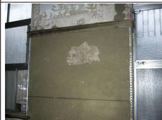
【照片 5-2-39】固定完成 970130
