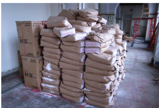
【照片 5-2-18】本次工程所進白灰 961209
