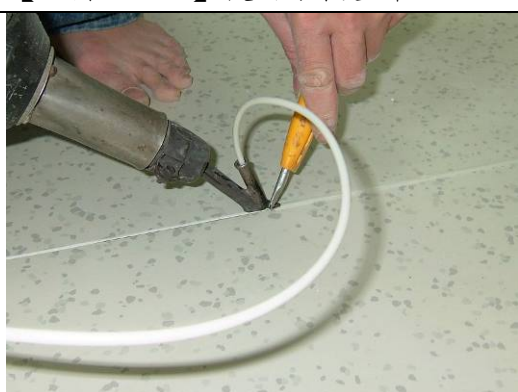
【照片 5-5-10】使用熔接方式將連接處黏接 970325
