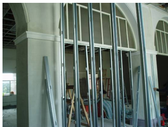
【照片 5-2-57】安裝槽鋼
