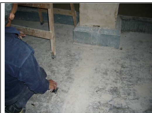
【照片 5-2-35】紅外線水平儀量水平 970130
