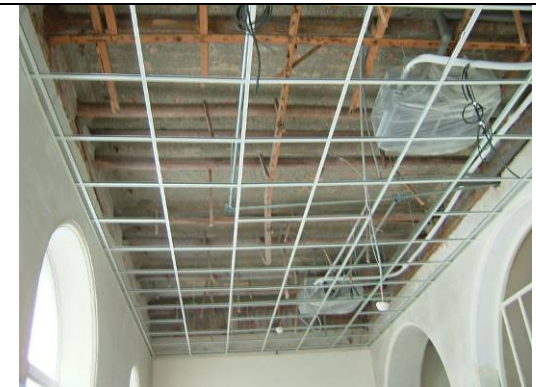
【照片 5-4-6】輕鋼架鋪設 970228
