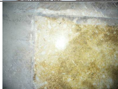
【照片 3-2-18】磨石子地磚 在 104B 室大部分為日治時期之磨石子地坪，有部分區域為後期更換的磨石子地磚。
