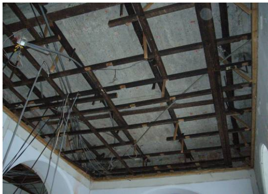
做過防腐處理的天花構架
