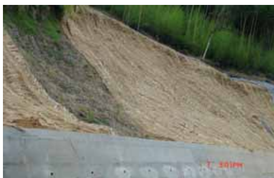
照片 B2-1 道路邊坡鋪草植生工程
