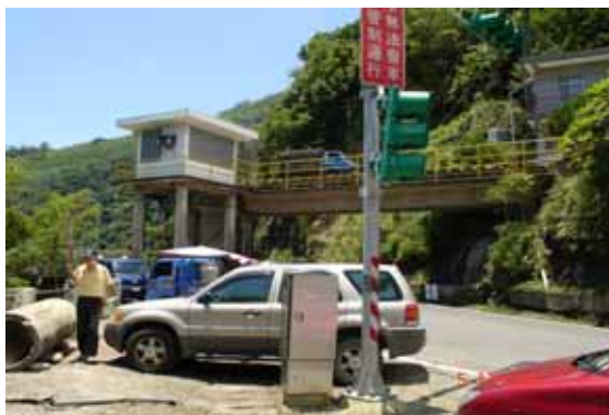
照片 A2-3 壩頂上方附屬設施
