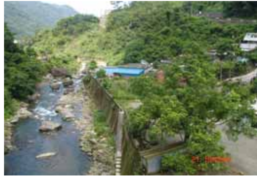
照片 D3 霞雲坪地區河岸邊坡建築，怪手正在清運附近河床崩塌巨石
