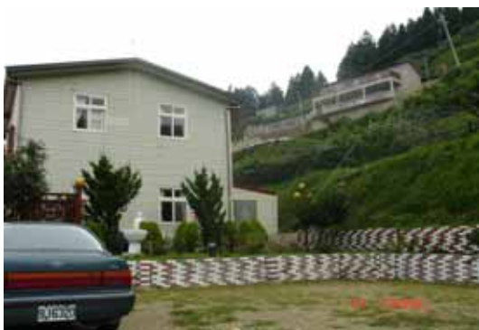
照片 D15 隨處可見原本陡峭之山坡，被開挖整地蓋成歐風民宿，潛藏生命財產之危機
