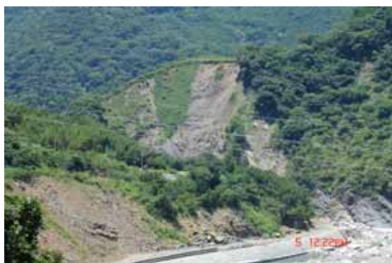
照片 A3-3 上游邊坡嚴重崩塌
