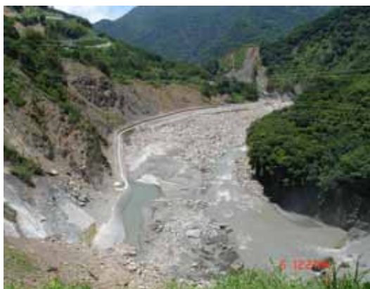
照片 A3-5 上游河床及邊坡
