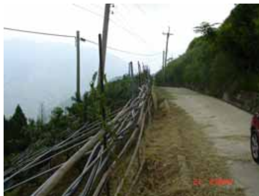
照片 D18 深山民宿及果園之聯外交通，隨意鋪設水泥即成，缺乏擋土牆、駁坎等水土保持設施
