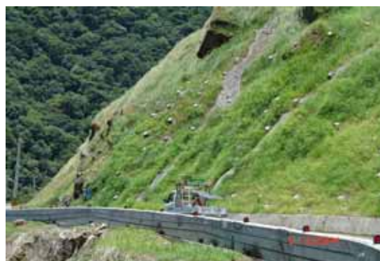
照片 A3-4 上方道路進行崩塌地處理
