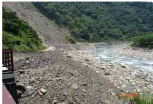
照片 B9-2 坡面破碎鬆散
