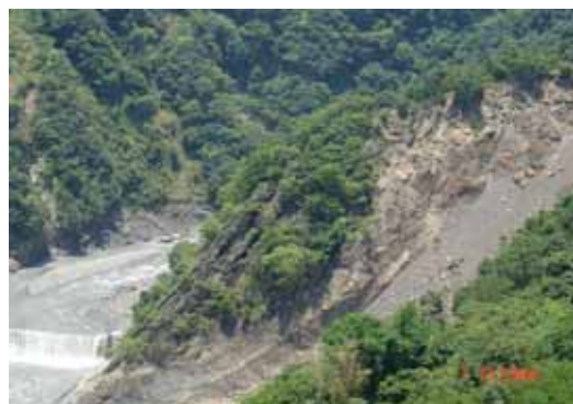
照片 A4-2 下游附近邊坡崩塌
