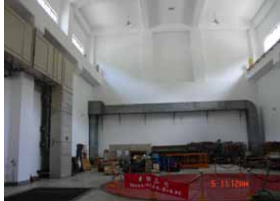
照片 A1-6 義興電廠內部
