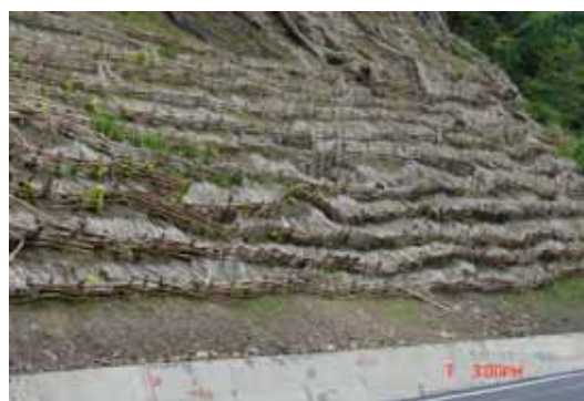
照片 B2-2 道路邊坡打柵編樁植生工程
