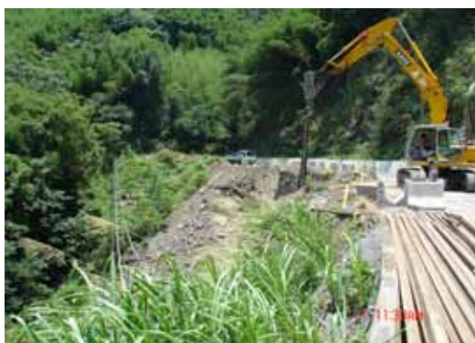
照片 A4-3 附近道路下方邊坡崩塌處理工程
