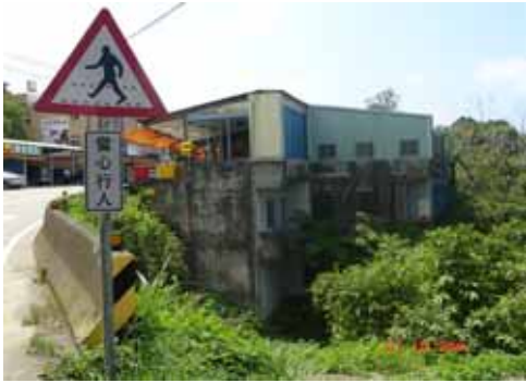
照片 D2 道路邊坡建築
