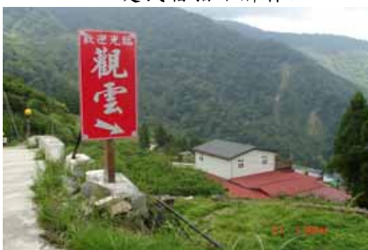
照片 D13 民宿多位於陡坡處，下方即為深谷
