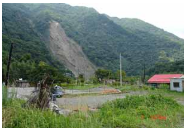
照片 B9-3 崩塌地附近民宅
