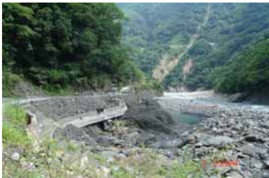
照片 B9-1 玉峰村電線杆號「那夏幹 108 號」附近上、下邊坡崩塌情形
