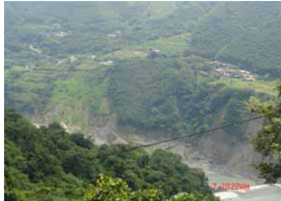
照片 A1-8 義興壩周邊土地利用及 河岸邊坡崩塌情形
