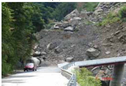
照片 B12 田埔通往秀巒道路沿線崩塌情形
