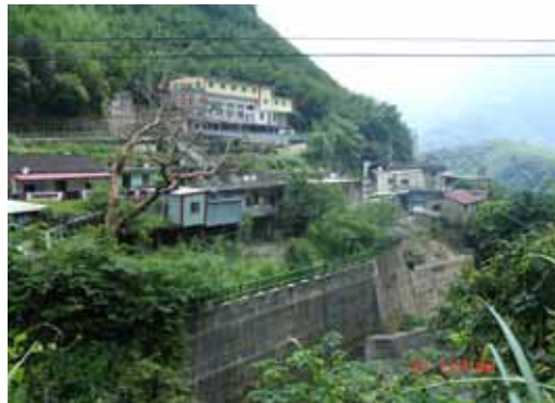
照片 D4 道路邊坡之陡坡建築
