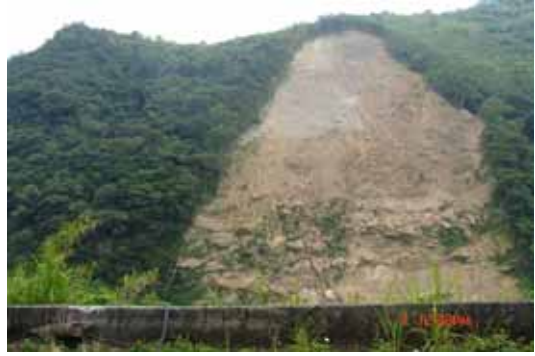
照片 A5-2 壩體上方大面積崩塌裸露情形
