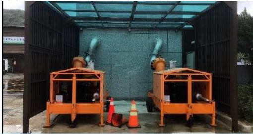
大武崙工業區小型抽排及調整池工程(0.3cmsX3) (十河局代辦)
