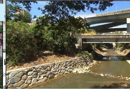
大武崙溪消防局瓶頸改善工程(十河局代辦)
