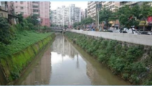
基金一路防洪牆及堤後排水與抽水井設置(基隆市)
