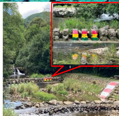
水特局111年5月完成設置虎豹潭水位站及水尺。
