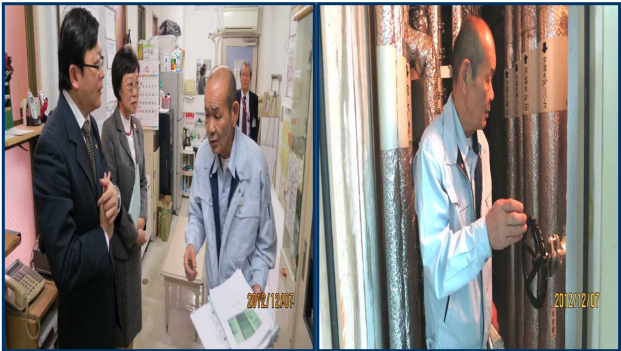
照片 11-5、本院尹委員實地訪查大鵬會千本醫院防災監控中心及消防管道間
