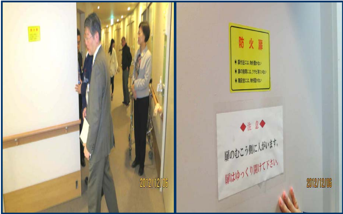
照片 8-7、住友病院實地説明及操作防火區劃及活動防火牆
