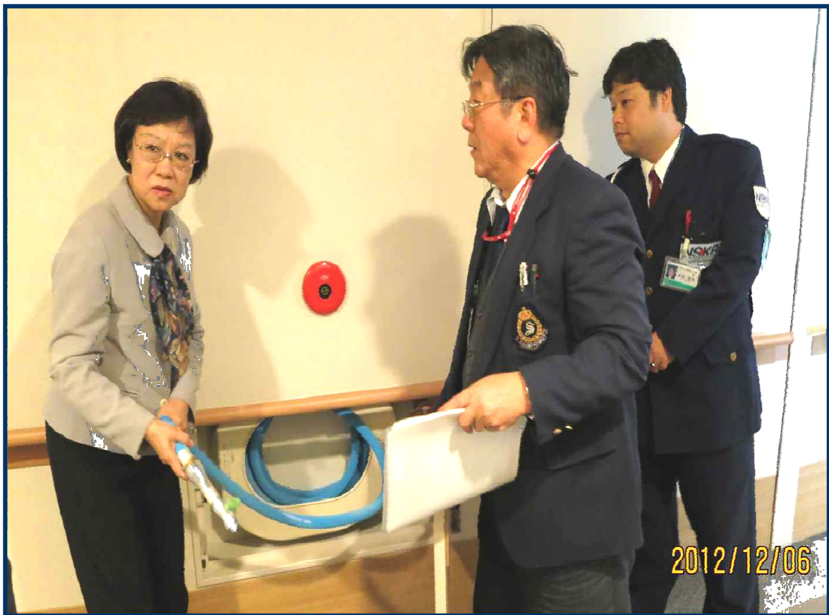
照片 8-8、本院尹委員實地操作消防水帶
