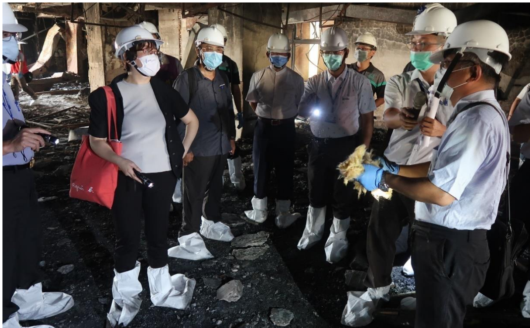
2樓-起火樓層(閒置未使用)及原裝潢使用泡棉
