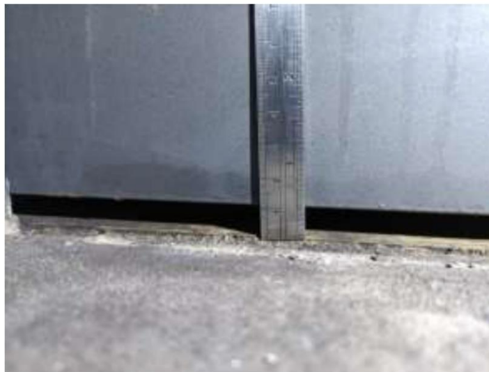
(左) 房間門北段外側與地板約有1.1公分縫隙。 (右) 房間門中段外側與地板約有1公分縫隙。
