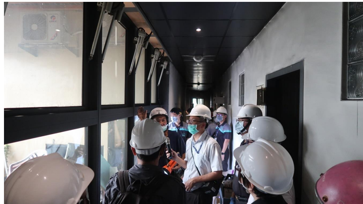
喬友大樓9樓—左側為排煙窗、 右側為殉職消防員所在房間
