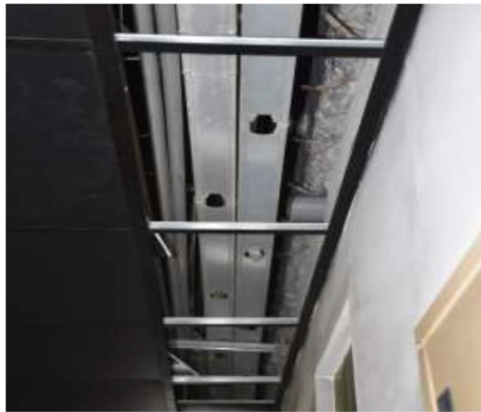
(左) 浴室排風管連接至塑膠管，開口貫穿至走道天花板上方。 (右) 天花板上方東南側配置情形，天花板上方與樓地板、橫樑底部有間隙。
