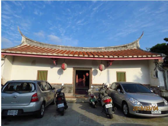
照片 1、古蹟修復後原貌遭變更，屋脊粘黏消失不見(左)、窗戶型式變更且封閉(右)
