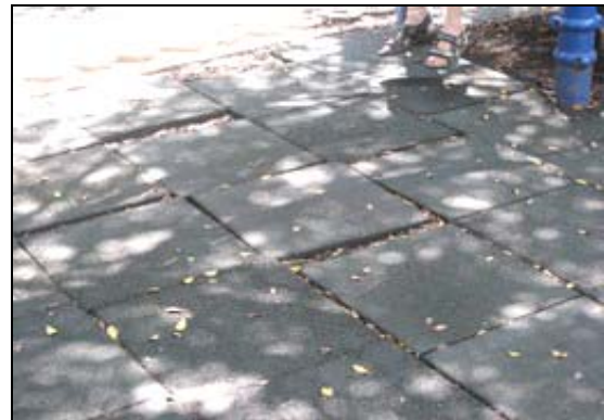
照片 3-1-14 安全地墊不平整，縫隙過大
