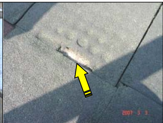
照片 1-7-3 鞦韆下方安全地墊破損
