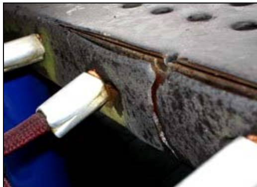
照片3-12-3 綜合遊具平臺鏽蝕
