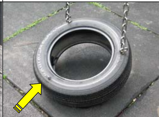
照片 4-1-8 鞦韆座椅固定栓掉落
