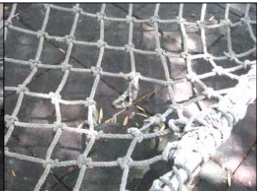
照片 3-1-16 攀爬網網繩斷損
