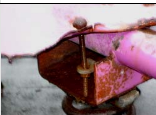
照片 3-10-6 翹翹板基座螺絲鬆脫
