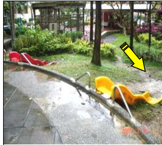
照片 1-8-3 滑梯滑槽底端高差不足且無安全地墊
