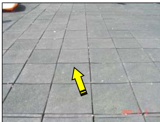
照片 1-10-1 安全地墊欠平整
