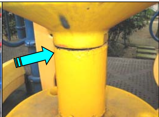
照片 2-6-3 綜合遊具圓錐踏板破損
