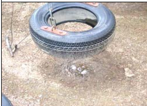
照片 4-2-11 鞦韆輪胎座椅傾斜、積水，地面泥沙硬實
