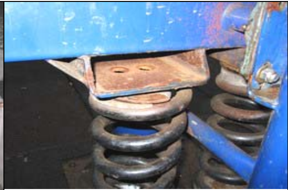
照片 2-7-10 翹翹板基座螺絲脫落，搖晃鬆弛
