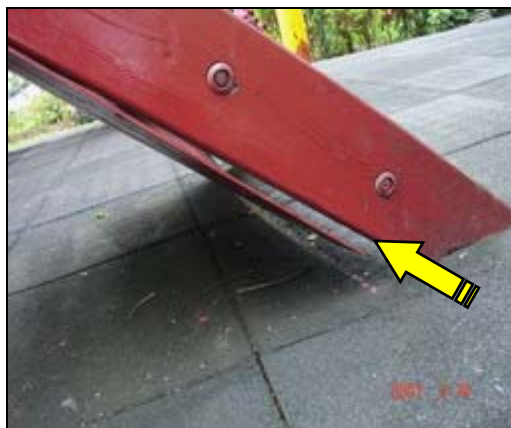
照片 1-9-1 綜合遊具階梯護板脫落
