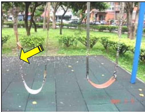
照片 1-6-1 鞦韆扶手處鏈條護套缺損且孔徑過大
