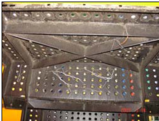
照片 1-9-4 綜合遊具平臺下方鐵絲突出
