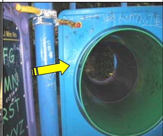
照片 2-15-8 綜合遊具筒狀隧道的接合處破損
