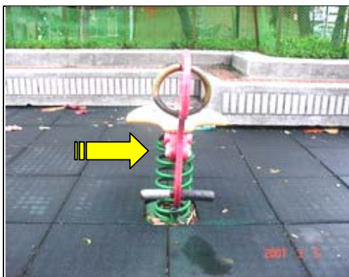
照片 1-5-1 搖搖馬基座鬆動傾斜
