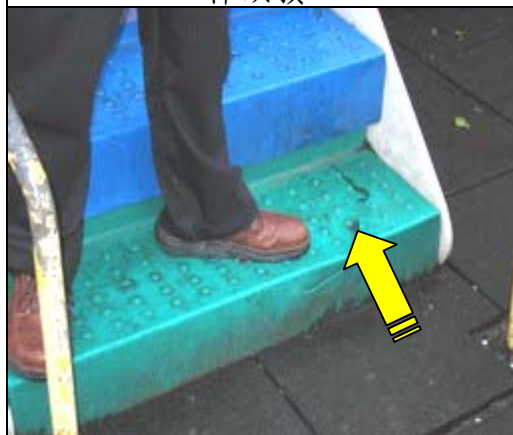
照片 2-15-7 綜合遊具階梯破損
