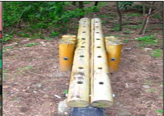
照片 4-2-10 翹翹板板面有縱向裂紋且無扶手
