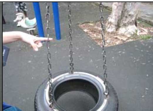
照片 3-5-6 鞦韆扶手處鏈條孔徑過大
