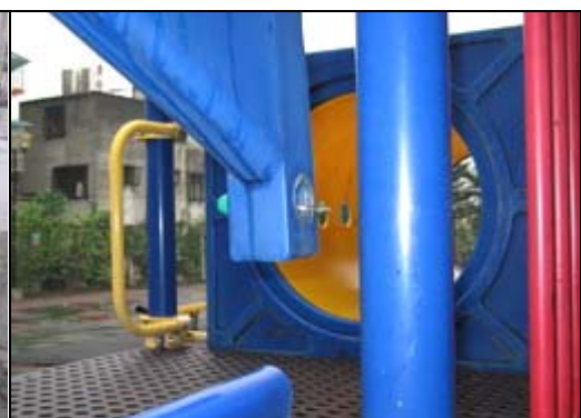
照片 2-7-5 綜合遊具滑梯頂端頭蓋螺絲鬆脫
