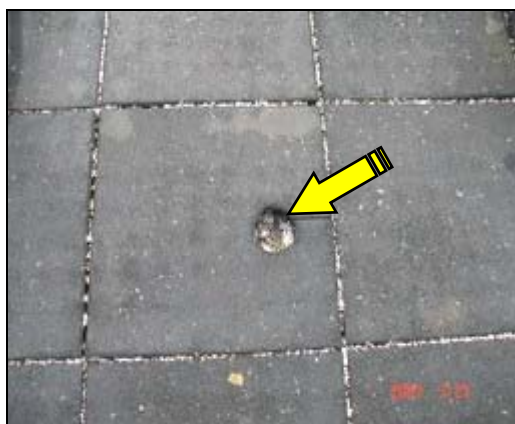
照片 1-11-3 安全地墊有坑洞
