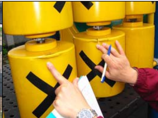
照片 3-8-8 綜合遊具平臺護欄的元件破裂
