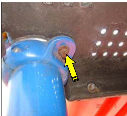
照片 1-7-6 綜合遊具螺絲鏽蝕
