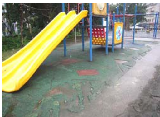
照片 2-7-4 綜合遊具區安全地墊缺損
