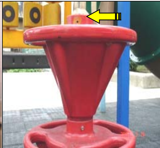
照片 1-8-2 綜合遊具踏階缺螺絲致鬆動
