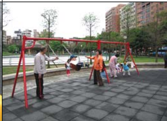
照片 2-3-6 鞦韆鏈條扶手處孔徑過大，且一側安全地墊鋪設範圍不足
