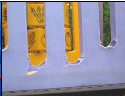
照片 2-3-4 綜合遊具平臺護欄破損
