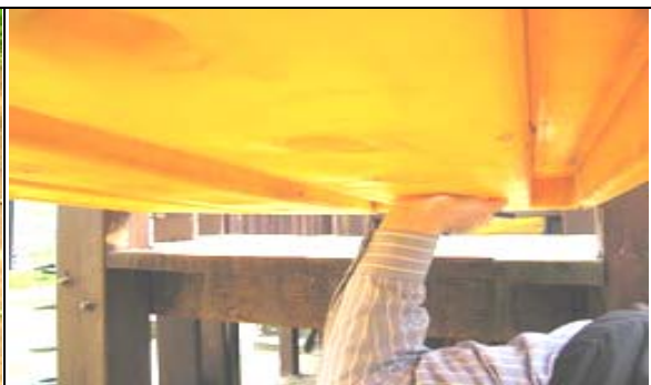
照片 2-13-2 綜合遊具平臺損壞無警示
