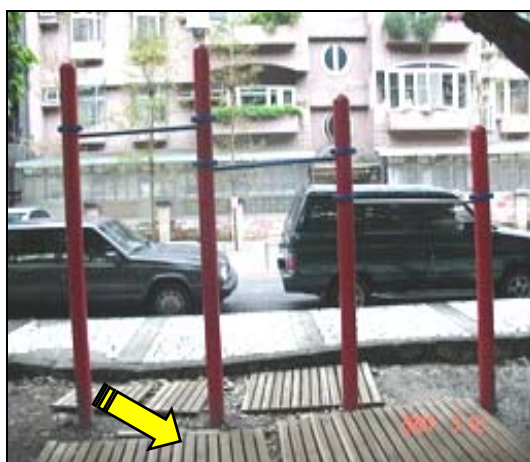
照片1-5-7 單槓下方地面未鋪設安全地墊
