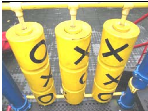
照片 2-6-2 綜合遊具平臺護欄元件破損
