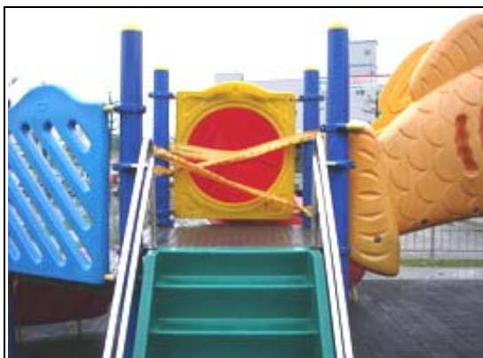
照片 3-12-5 綜合遊具滑梯已停用，但無妥善警示措施
