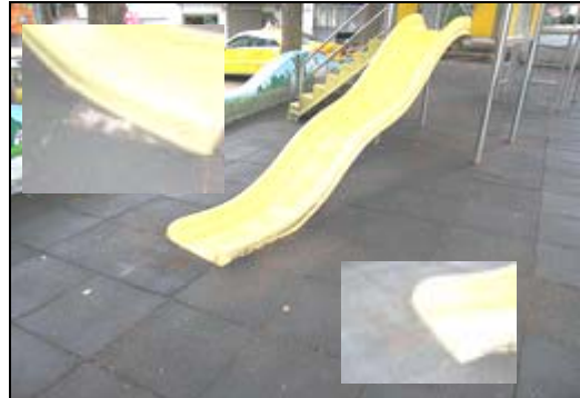
照片 2-6-1 綜合遊具滑梯滑槽底端之安全地墊磨損
