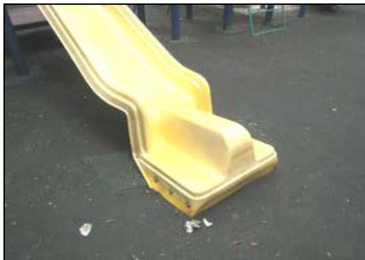
照片 3-5-5 滑梯滑槽底端設計不當
