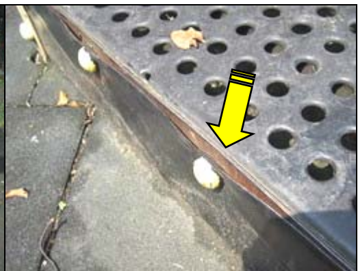
照片 2-2-2 綜合遊具踏階面層剝離
