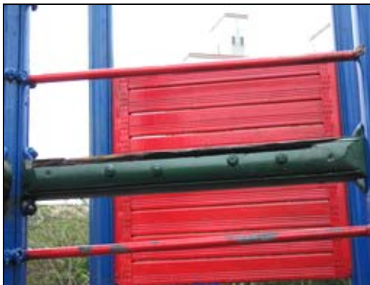
照片 2-3-3 綜合遊具平臺上木製橫桿破損
