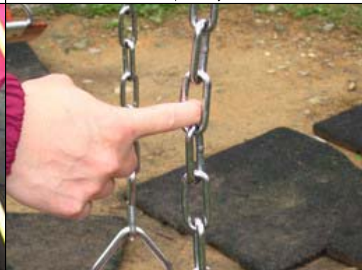
照片 3-8-10 鞦韆扶手處鏈條孔徑過大
