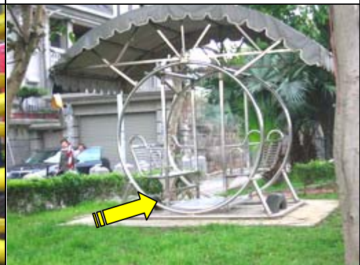
照片 4-2-4 搖椅踏板與地面間距僅約 10 cm，鉤環扣潤滑不足且未鋪設安全地墊
