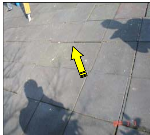
照片 1-7-1 安全地墊鬆動、欠平整
