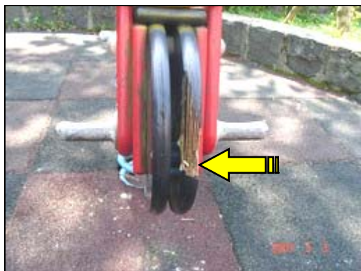
照片 1-10-8 搖搖馬前側木板破損
