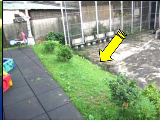
照片 2-7-3 場地旁邊陡坡落差大
