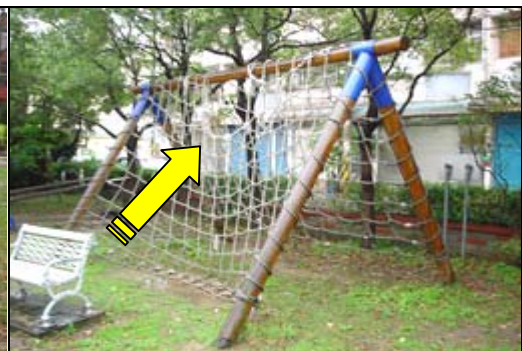
照片 3-11-6 攀爬網網繩斷損
