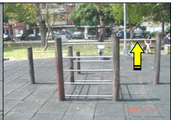
照片 1-10-2 單槓水平桿鬆動未牢固
