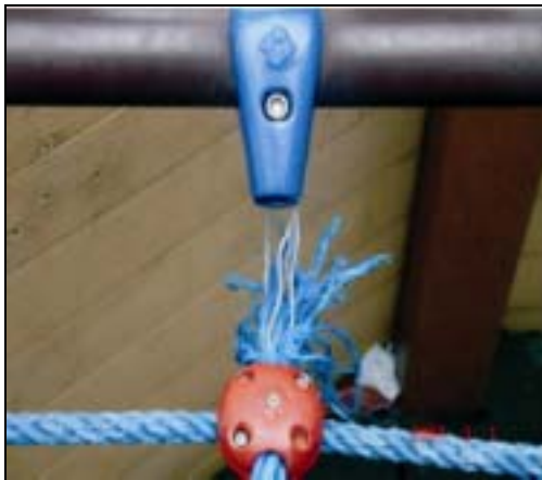
照片 1-3-2 綜合遊具網繩斷裂
