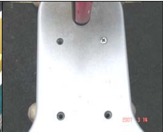
照片 1-10-7 翹翹板螺絲缺落遺失
