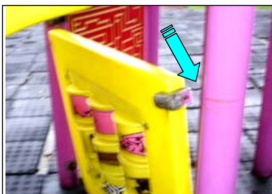
照片 3-10-3 綜合遊具平臺護欄鬆脫
