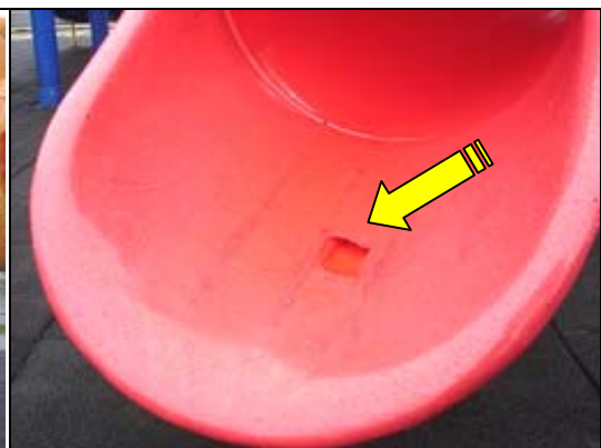
照片 3-12-6 綜合遊具滑梯滑槽底端破損
