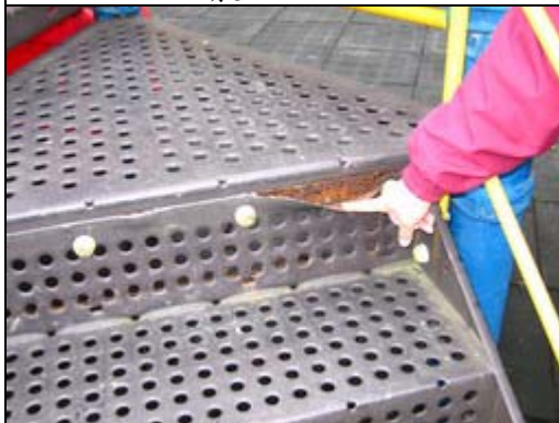
照片 3-8-9 綜合遊具踏階面層剝離，內鏽蝕
