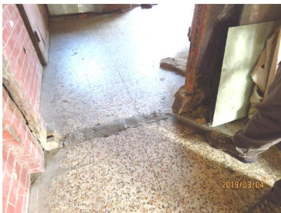
照片 2、門檻被鋸掉（左）、原有木棟架斷裂（右）
