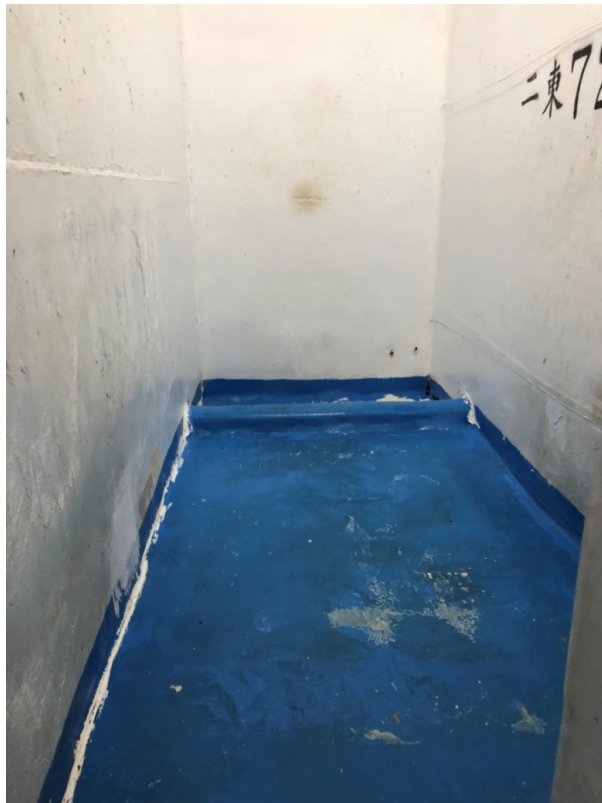
圖 29 綠島監獄獨居舍二東舍 72 號房內部
