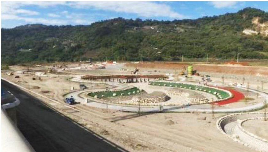
照片 2 【本案基地施工情形】
