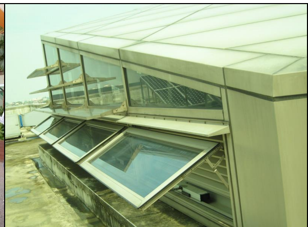
99.06.18 台南台達電子南科廠，頂樓遮陽。
