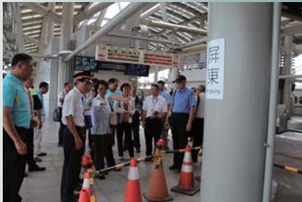
監察委員調查履勘屏東車站月台漏水案
