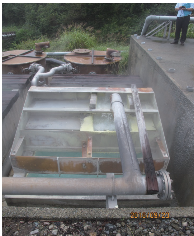
照片 28 箱根町營溫泉沉澱槽
