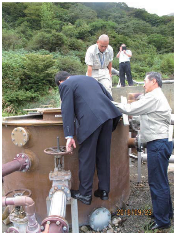
照片 30 委員實際探勘集湯槽情形
