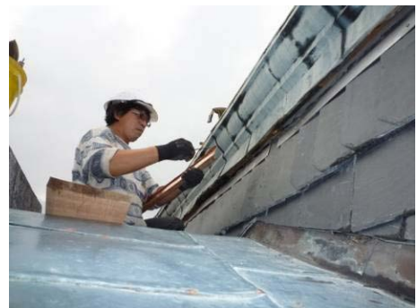
【照片 5-6-170】調整線板倒鈎 (98.10.14)
