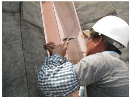
【相片 5-6-105】交接處以吊子相扣並植入斜紋釘固定於屋面板(98.08.27)
