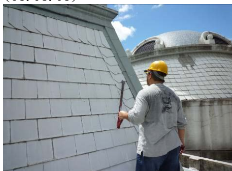
【照片 5-3-3】拆除屋脊瓦(98.08.03)
