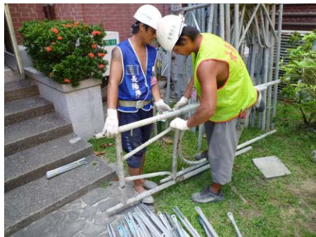
【照片 5-1-7】調整放樣鋼管位置(98.05.30)
