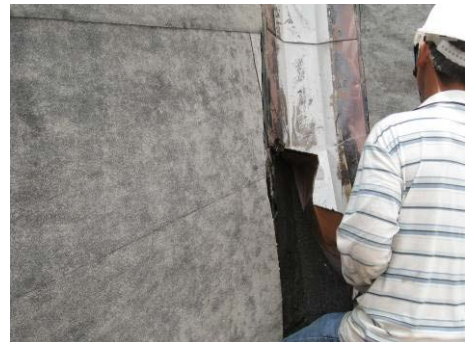
【照片 5-3-20】由下往上拆除銅板 (98.08.27)
