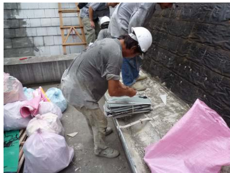
【照片 5-3-13】不鏽鋼板統一彙整 (98.08.03)
