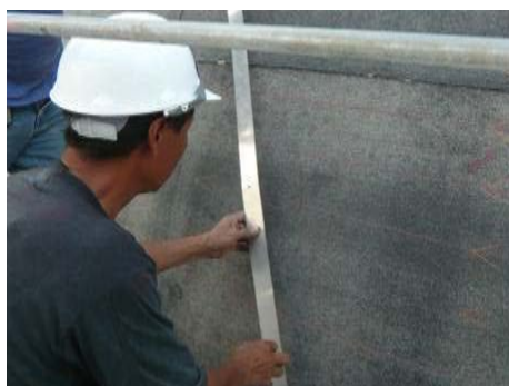
【照片 5-5-172】放樣斜率基準線 (97.11.07)
