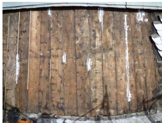
【照片 3-1-72】中央穹頂 8 區屋面板 (98. 11. 05)
