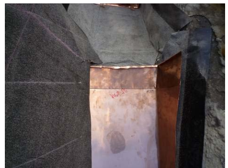
【相片 5-6-348】安裝老虎窗頂水切板 (98.11.27)
