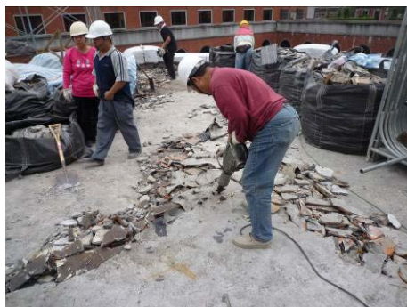
【照片 5-3-53】敲除 M 形樓梯平台 鋪面(98.11.28)
