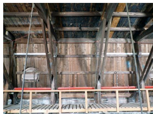
【照片 3-1-54】北翼 11 區屋面板(98.09.17)
