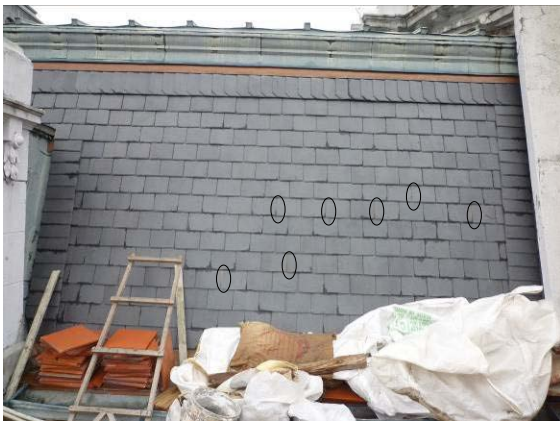
【照片 5-5-114】北翼 6 區抽換石板瓦位置
