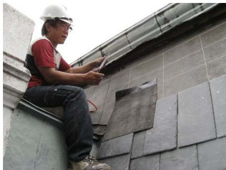
【照片 5-5-50】石板瓦交接處鋪設自黏式防水毯(98.09.30)
