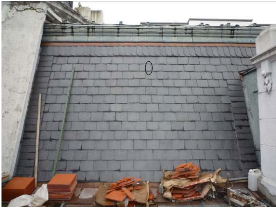
【照片 5-5-126】西翼 10 區抽換石板瓦位置
