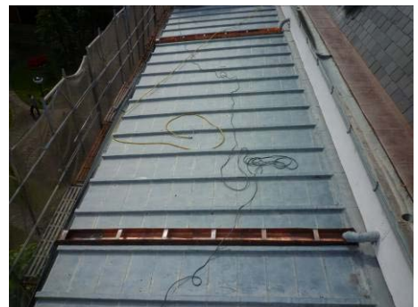
【照片 5-6-234】完成單坡斜屋頂銅製 排水溝安裝(98.12.15)
