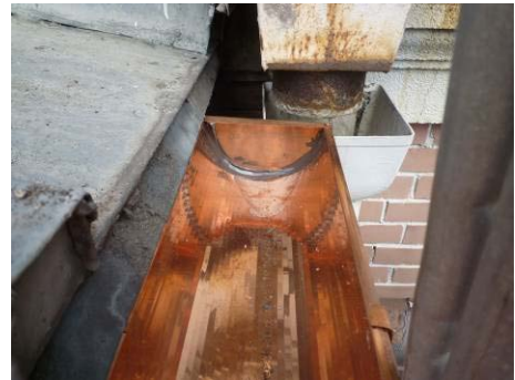
【照片 5-6-132】安裝水遮後以矽利康 填補接縫(98. 12. 22)
