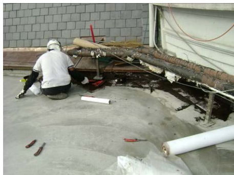
【照片 5-4-49】平台交接處先鋪設 RA 防水(98.12.05)
