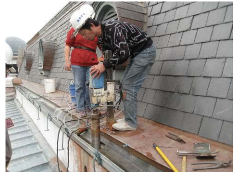
【照片 5-6-264】放樣落水管位置,垂 直沖孔(98.12.25)
