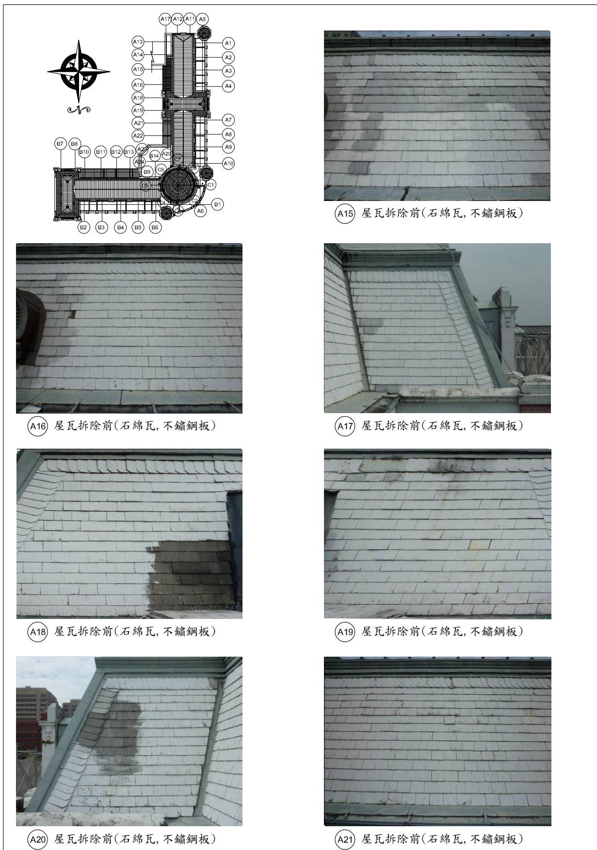
【圖 3-1-12】監察院屋瓦拆除前材料記錄
