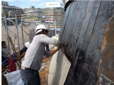
【照片 5-4-35】斜紋釘固定(98. 11. 02)
