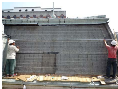
【照片 5-5-21】量測屋面間距定出中心(98.09.21)
