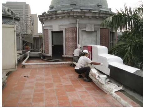
【照片 5-4-81】塗刷底層白色橡膠瀝青(98.12.24)
