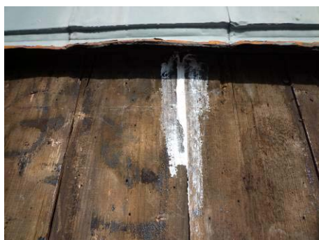
【照片 5-4-29】裂縫填補細部 (98.11.02)
