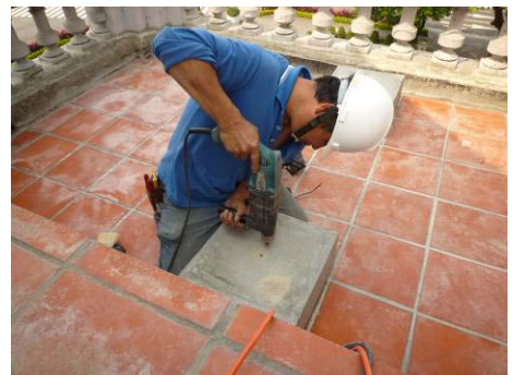
【照片 5-2-20】電鑽鑽孔(99.03.12)
