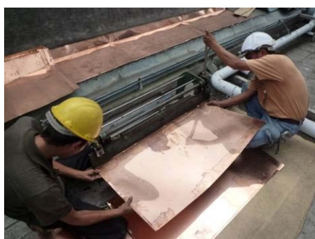
【照片 5-6-25】銅板彎摺成形(98.08.18)
