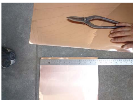
【相片 5-6-331】梯形水切板內端為 29 公分(98. 11. 27)
