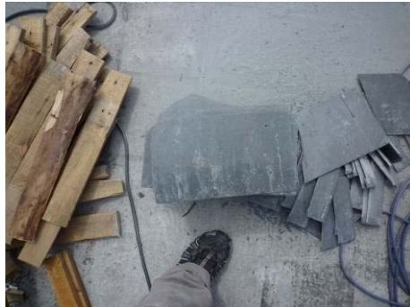
【照片 5-5-64】完成斜脊瓦加工 (98.09.30)
