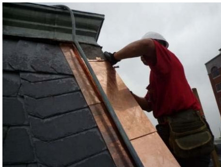
【照片 5-6-203】量測轉折銅板至簷板 尺寸(98.10.22)
