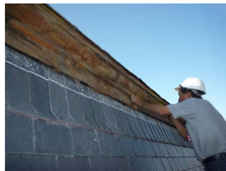
【照片 5-6-150】彈記水平基準線(98.11.25)
