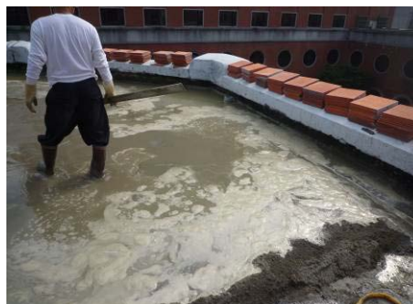
【相片 5-7-44】檢視屋面洩水坡度 (98.12.23)
