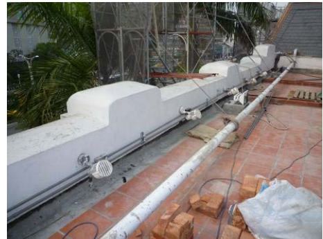
【照片 5-2-24】完成配管線路安裝(99.03.14)
