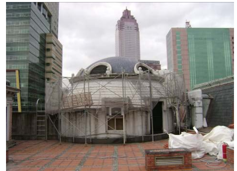
【照片 5-1-20】完成大碉堡鋼管鷹架搭設(98.12.07)
