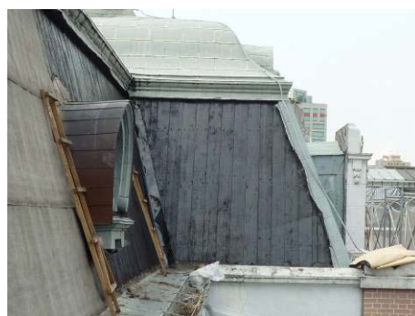
【照片 5-4-10】完成屋面轉折處底油 塗刷(98.08.27)
