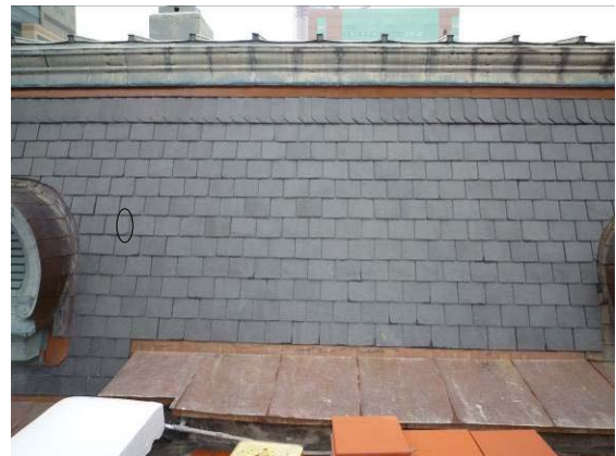
【照片 5-5-141】西翼 23 區抽換石板瓦位置
