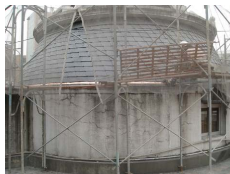
【照片 5-6-384】完成水切板安裝(98.12.26)
