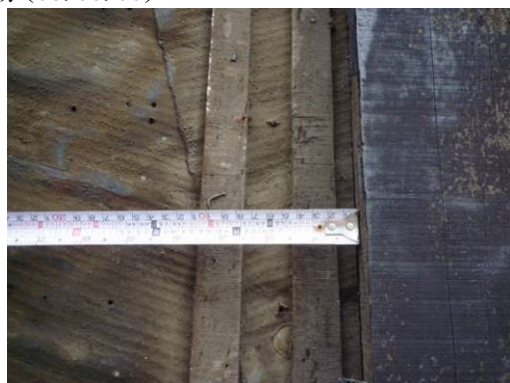
【照片 3-1-91】襯材寬度約 3 公分(98.08.03)
