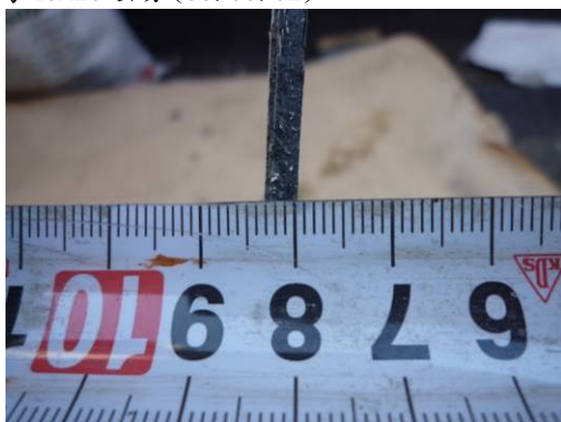
【照片 3-1-83】北翼 8 區之水泥纖維瓦厚度為 0.3 公分(98.09.02)
