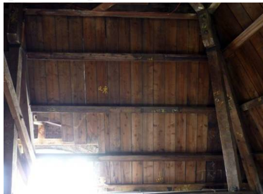
【照片 3-1-64】北翼 16 區屋面板(98.09.17)
