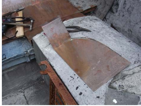
【相片 5-6-77】安裝轉折處水切板(由數塊銅板錫焊施作)(98.10.02)
