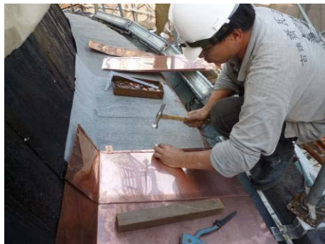
【相片 5-6-345】吊子加釘固定 (98.11.27)
