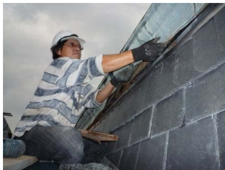
【照片 5-6-169】調整舊有簷板倒鈎 (98.10.14)
