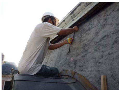
【照片 5-5-78】放樣延續面之水平放樣線(98.09.17)
