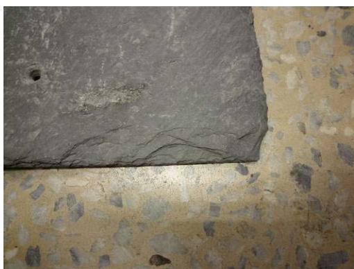
【照片 5-5-6】石板瓦正面四周之自然收邊
