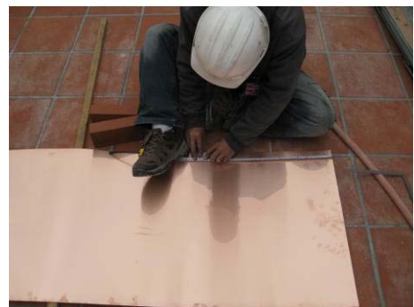
【照片 5-6-244】施作橫向補強構件 (98. 12. 26)
