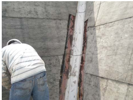
【照片 5-3-19】拆除谷溝兩側油毛 氈(98.08.27)
