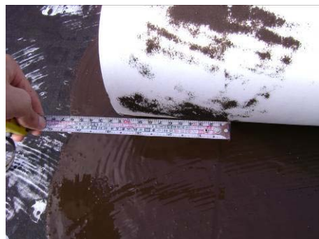
【照片 5-4-52】全面性鋪設:不織布重複搭接尺寸約 11 至 12 公分(98.12.05)
