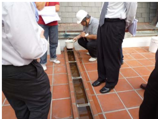
【照片 6-2-6】排水溝試水，檢視洩水情形(99. 03. 30)
