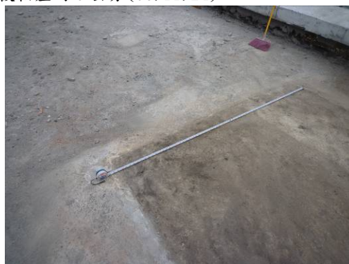
【照片 3-1-170】填補尺寸約為 2 公尺(98.11.30)
