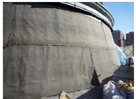
【照片 5-4-40】完成穹頂防水毯鋪設(98. 11. 02)
