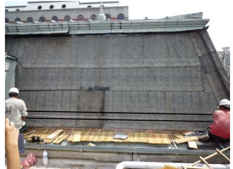
【照片 5-5-15】彈記起手瓦與最底層屋面瓦水平基準線(98.09.21)
