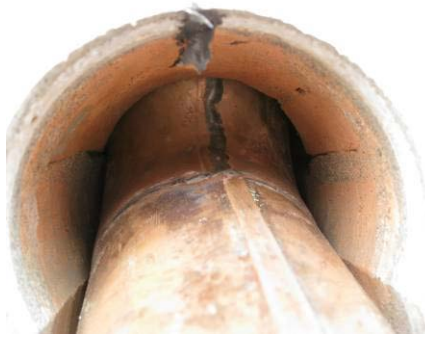
【照片 5-6-285】安裝落水管 (98.12.26)
