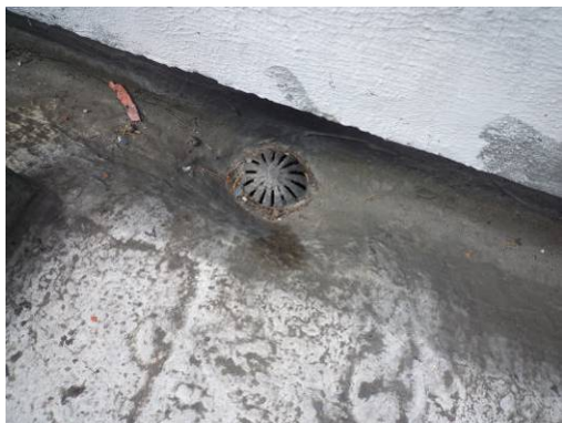
【照片 3-1-195】西翼 3 區平台落水頭拆除前樣貌(98.11.02)
