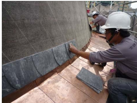
【照片 5-5-184】鋪設屋面瓦 (98.11.29)
