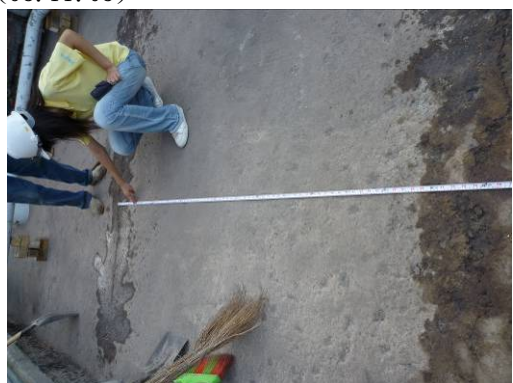
【照片 3-1-157】西翼 1. 2. 3. 4 區平台裂縫間距約 220 至 230 公分 (98. 11. 05)
