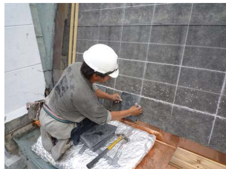
【照片 5-5-31】鋪設起手瓦(98.09.28)
