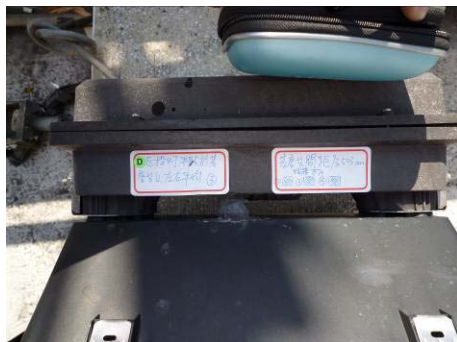
【照片 5-2-5】標記(D區投射燈基座，間距為 503mm，平貼於平台上)(98.08.01)
