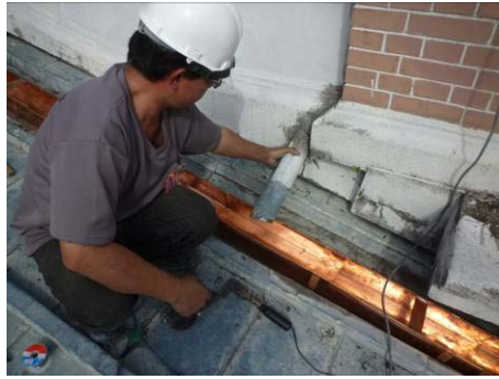
【照片 5-6-293】整修落水管 (98.12.15)
