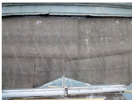
【照片 5-5-176】完成屋面放樣 (98.11.08)
