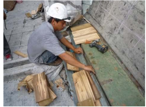
【照片 5-6-38】整理不鏽鋼天溝 (98.09.23)
