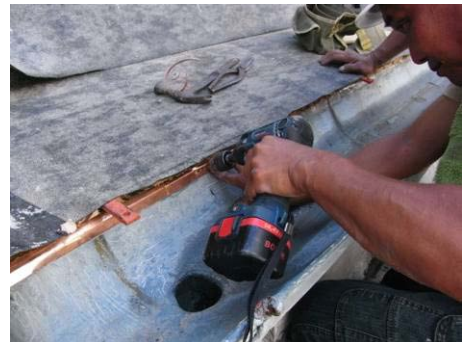
【照片 5-6-52】電鑽鑽孔(98.09.25)
