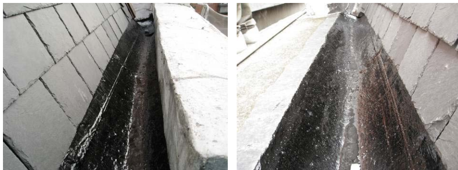
【照片 5-6-145】完成防水膠塗刷 (98.12.24)
