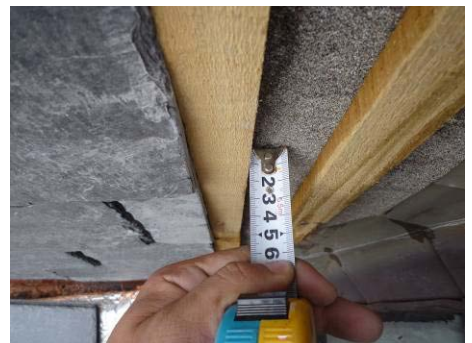
【照片 5-5-43】石板瓦鋪設厚度約 3 公分(98.09.28)
