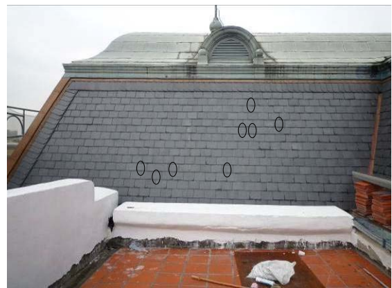
【照片 5-5-117】北翼 1 區抽換石板瓦位置
