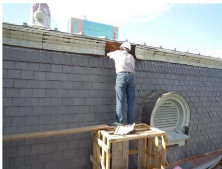
【照片 5-6-149】拆除舊有簷板(98.11.25)
