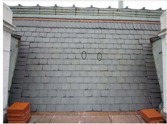
【照片 5-5-127】西翼 9 區抽換石板瓦位置
