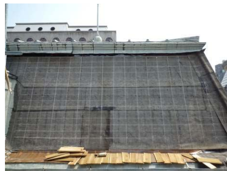
【照片 5-5-27】完成屋面放樣 (98.09.21)
