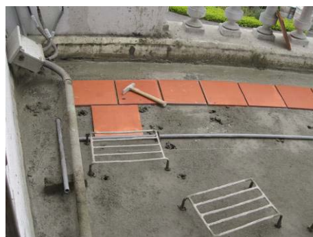
【相片 5-7-58】放樣板磚鋪設位置(98.12.26)
