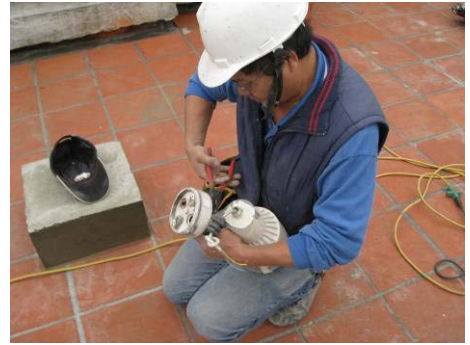
【照片 5-2-14】檢視線路 (98.12.26)
