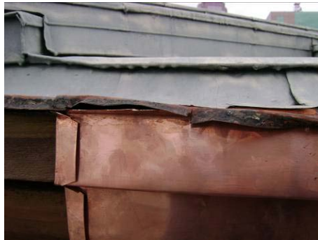
【照片 5-6-159】新舊交接處倒鈎固定 (98.12.03)
