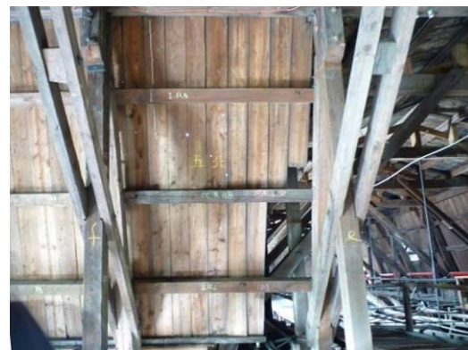
【照片 3-1-24】西翼 6 區屋面板(98.08.20)
