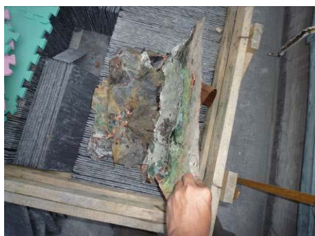
【照片 5-2-33】拆除舊有銅皮(98.09.28)
