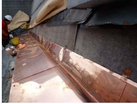
【相片 5-6-69】完成水切板安裝 (98.10.17)
