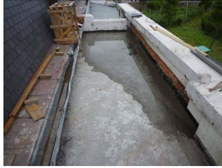
【照片 5-4-65】西翼 13、14 區平台試水(98.11.28)
