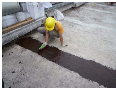
【相片 5-7-26】完成鋪設(98.11.11)
