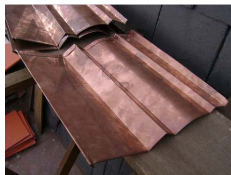
【照片 5-6-156】簷板彎摺成形(98.11.25)
