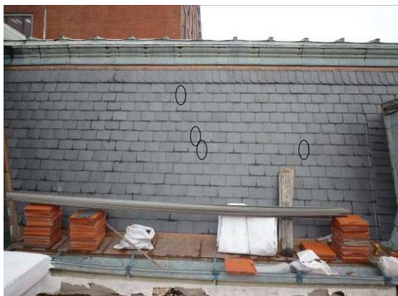
【照片 5-5-116】北翼 2 區抽換石板瓦位置
