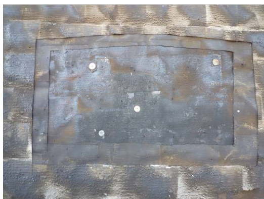
【照片 3-1-145】防水層 4 層：第 2 層油毛氈 (98.11.05)
