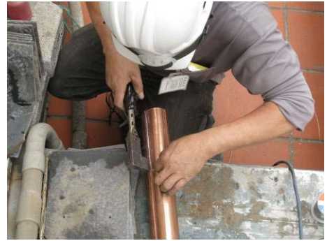
【照片 5-6-270】錫焊補強(98.12.25)
