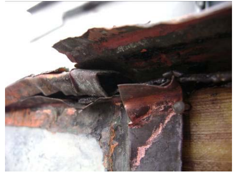
【照片 5-6-158】銅板新舊交接處細部 (98.12.03)
