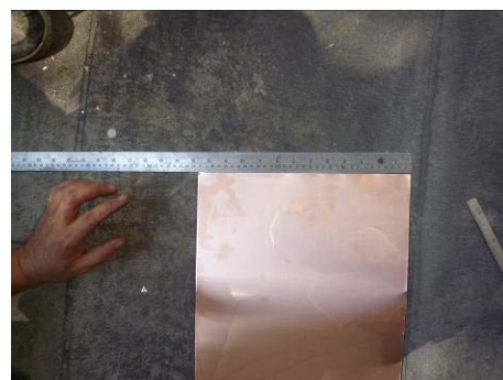
【相片 5-6-330】梯形水切板外端為 32 公分(98. 11. 27)
