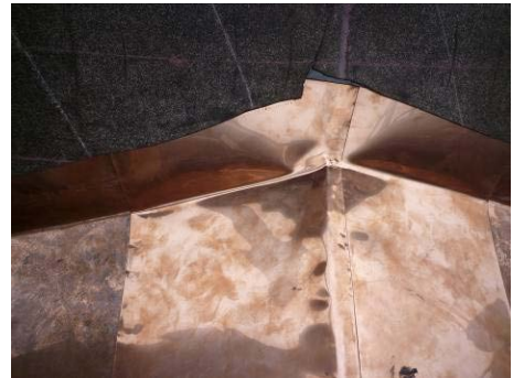
【相片 5-6-352】老虎窗頂水切板施作 後細部(98.11.27)
