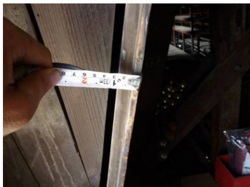
【照片 3-1-13】監察院全區屋面板厚度 2.4 公分(98.09.19)
