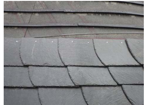
【照片 5-5-209】屋面瓦重疊覆蓋後細 部(98. 12. 17)
