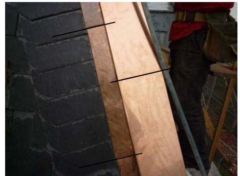
【照片 5-6-202】交丁安裝細部 (98.10.22)
