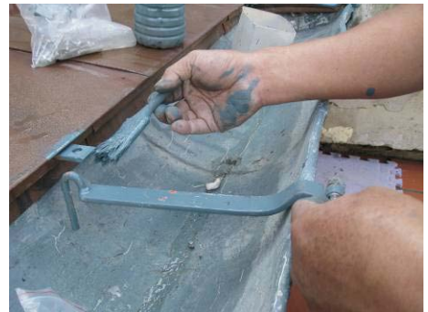
【照片 5-6-316】塗刷面漆(98.12.24)
