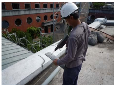
【照片 5-5-148】震動鑽孔機鑽孔 (98.11.27)
