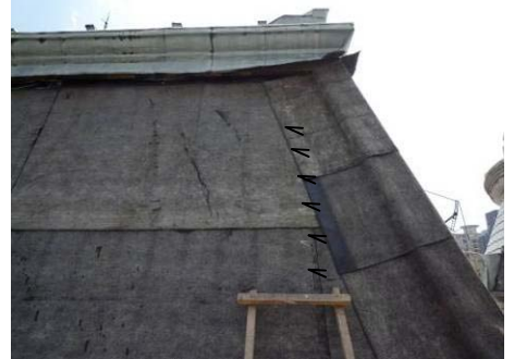
【照片 5-5-17】放樣 1、2、3、4 區上緣延續面之水平放樣線(98.09.21)
