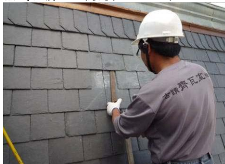
【照片 5-5-146】拔釘器斬斷固定石板瓦之螺絲釘(98.11.27)
