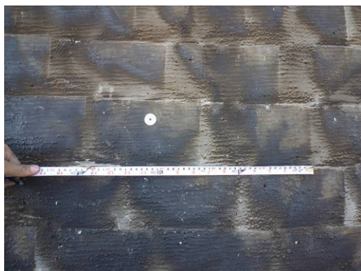
【照片 3-1-143】防水層 4 層：第 4 層油毛氈 (98.11.05)
