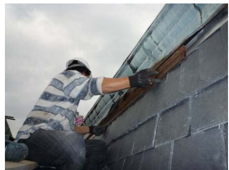
【照片 5-6-172】調整線板位置 (98.10.14)
