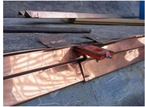
【照片 5-6-62】完成收邊銅板安裝(98.09.25)
