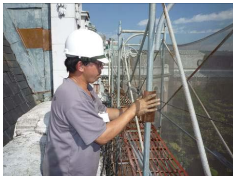
【照片 5-6-297】配合圓管來回壓印成 圓管狀(98.12.15)
