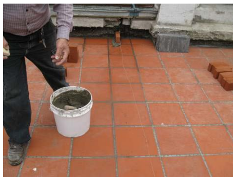
【照片 5-6-235】安裝平台排水溝 (98.12.25)
