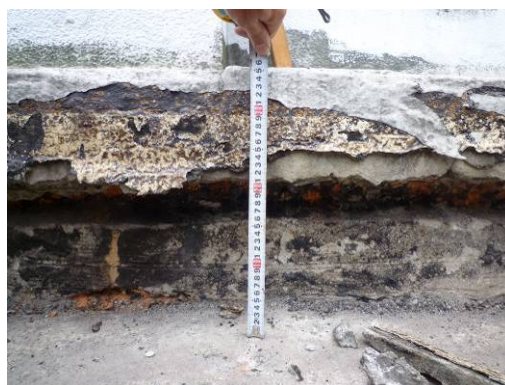
【照片 3-1-184】西翼 1.2.3.4 區平台(第二期興建)老虎窗原本覆蓋的底層基座(98.11.01)
