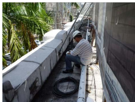
【照片 5-2-8】拆除平台燈具電線(98.08.01)
