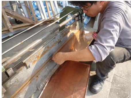
【照片 5-6-217】銅板彎摺定形 (98. 12. 11)
