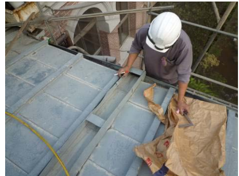
【照片 5-6-208】標記排水溝固定方式(98.12.11)
