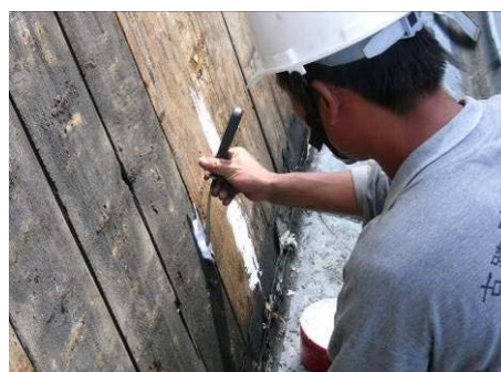
【照片 5-4-6】塗刷修補劑 (98.09.07)
