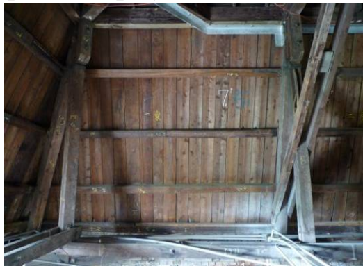
【照片 3-1-63】北翼 15 區屋面板(98.09.17)
