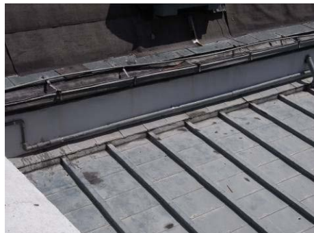
【照片 5-2-30】北翼後側天溝完成給水管遷移情形(98.09.07)
