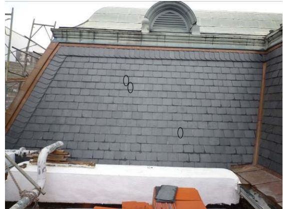
【照片 5-5-129】西翼 5 區抽換石板瓦位置
