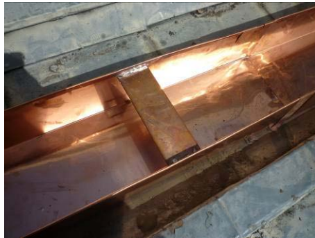
【照片 5-6-231】安裝橫向補強構件 (98.12.15)
