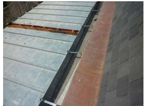
【照片 5-6-314】安裝固定器 (98.12.22)
