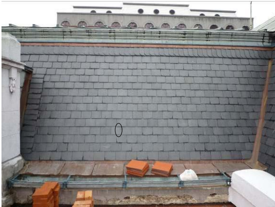
【照片 5-5-128】西翼 7 區抽換石板瓦位置
