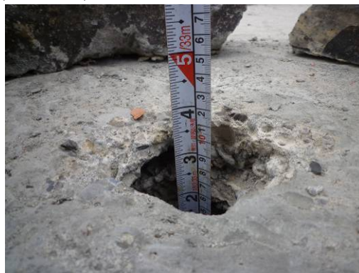
【照片 3-1-178】M 形樓梯平台 RC 樓板厚度由 洞口量測約為 12 公分(98. 12. 01)
