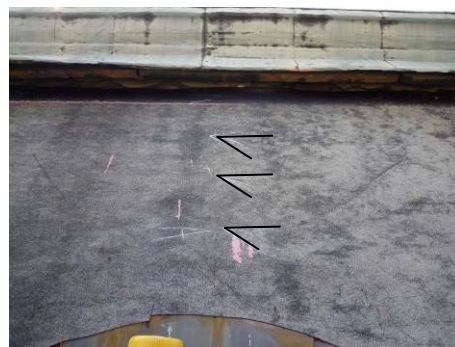
【照片 5-5-79】標記延續面水平放樣線位置(98.09.17)
