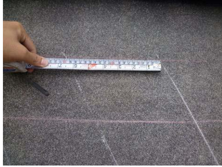
【照片 5-5-178】上緣石板瓦鋪設間距為 19.8 公分(98.11.08)
