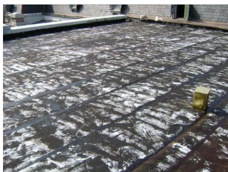
【照片 5-4-53】全面性鋪設:完成不織布鋪設(98.12.06)
