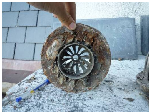
【照片 3-1-202】北翼 5 區平台落水頭固定鑄鐵片(98.11.25)
