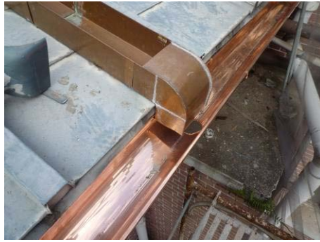
【照片 5-6-137】開設落水口 (98. 12. 22)
