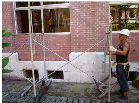
【照片 5-1-9】安裝斜撐支撐(98.05.30)
