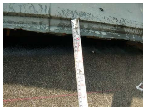
【照片 5-5-165】放樣頂層屋面瓦水平基準線(97.11.07)
