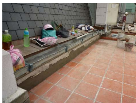
【相片 5-7-76】完成牆體表面修飾 (99.03.11)
