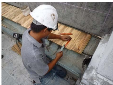
【照片 5-6-43】調整固定器基座位置 (98.09.23)
