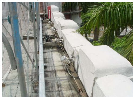
【照片 5-2-3】西翼拆除燈具前 (98.06.08)
