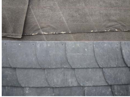
【照片 5-5-190】屋面瓦以螺絲釘固定上下兩孔，保留一孔洞等至屋瓦裁切時才使用( 98. 11. 29)
