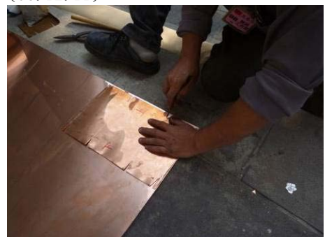
【照片 5-6-212】放樣構件轉折位置(98.12.11)
