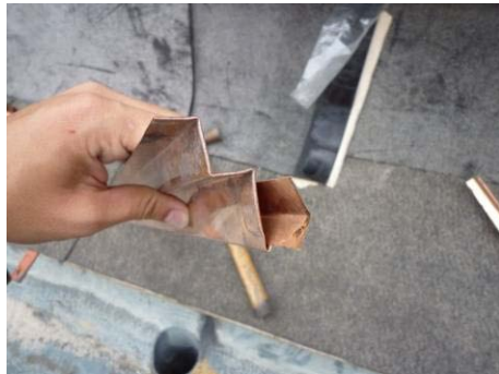
【照片 5-6-63】收邊銅板與倒鈎接合細部(98.09.25)
