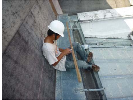
【照片 5-5-10】標記水平放樣線尺寸(98.09.12)
