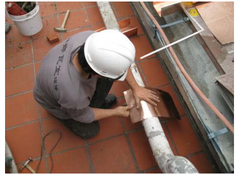
【照片 5-6-272】配合水管彎摺成弧面(98.12.25)
