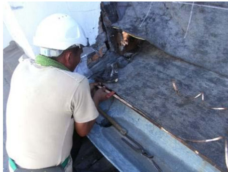
【照片 5-6-55】收邊銅板安裝(98.09.25)
