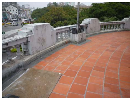
【相片 5-7-62】完成板磚鋪設 (99. 03. 03)
