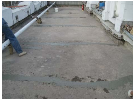
【相片 5-7-9】完成西翼平台裂縫修補 (98.11.11)
