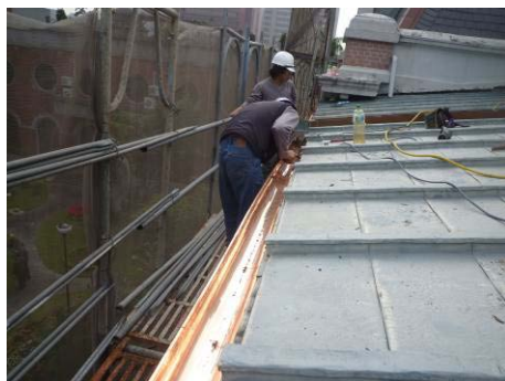
【照片 5-6-135】天溝接合處以錫焊固 定(98. 12. 22)
