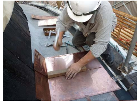
【相片 5-6-344】倒鈎處以拍打木敲打 緊密(98.11.27)
