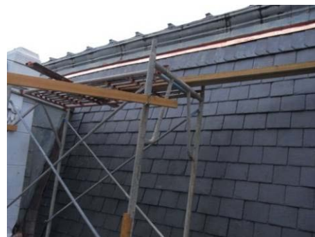
【照片 5-6-176】完成線板安裝(98.10.14)
