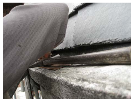
【照片 5-6-378】安裝掛瓦條(98.12.26)
