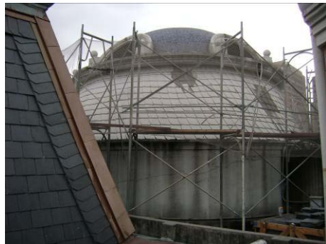
【照片 5-1-19】完成大碉堡鋼管鷹架搭設(98.12.07)
