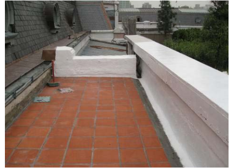
【照片 5-4-84】完成西翼平台女兒牆 RA 防水塗刷(98.12.24)
