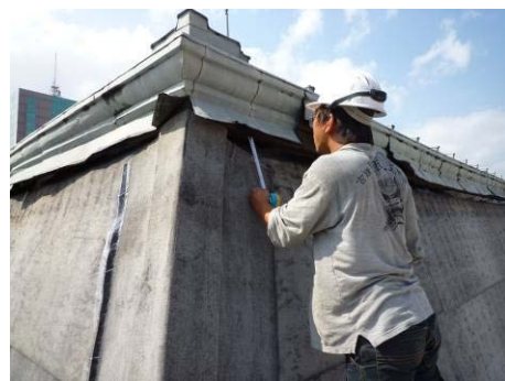
【照片 5-5-77】放樣頂層屋面瓦水 平基準線(98.09.17)
