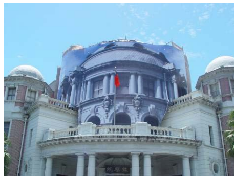
【照片 5-1-25】完成中央穹頂藝術帆布掛設(98.06.18)
