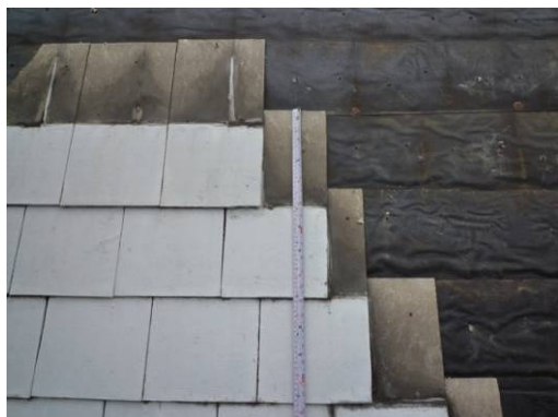
【照片 3-1-87】西翼 1 區屋面瓦交丁鋪設 (98.08.03)
