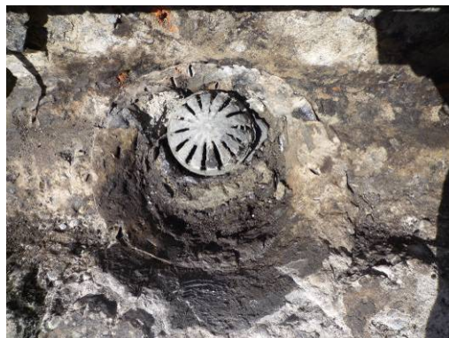
【照片 3-1-196】西翼 3 區平台落水頭與落水管之接合形式(98.11.02)
