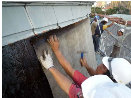
【照片 5-4-37】斜紋釘固定(98. 11. 02)
