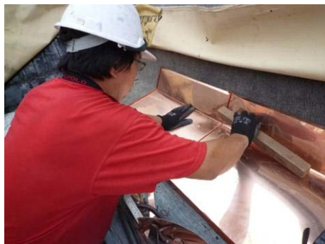
【相片 5-6-65】倒鈎接合處以拍打木整平敲實(98.10.17)
