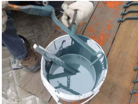
【照片 5-6-311】塗刷面漆(青葉調合 漆 41 號藍灰) (98.12.20)
