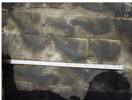
【照片 3-1-134】防水層 2 層:第 2 層油毛氈(98.11.05)
