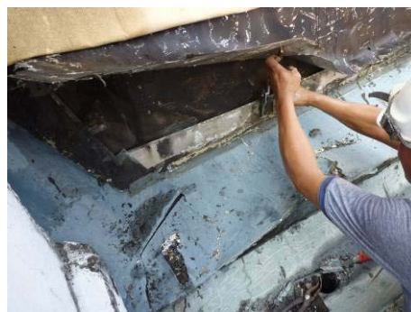
【照片 5-3-28】拔除吊子 (98.08.14)
