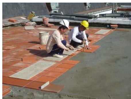
【相片 5-7-48】拉線鋪設板磚(98.12.23)
