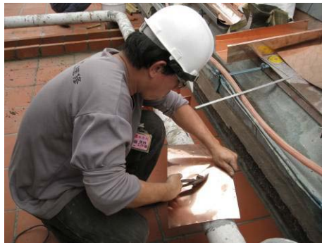
【照片 5-6-273】裁切落水管孔徑(98.12.25)
