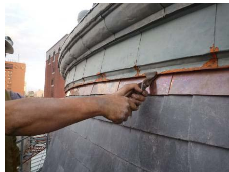
【照片 5-6-366】處理新舊接合界面 (98.12.08)
