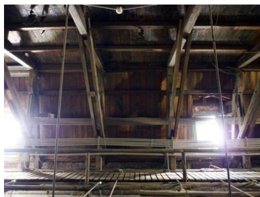
【照片 3-1-46】北翼 3 區屋面板(98.09.17)
