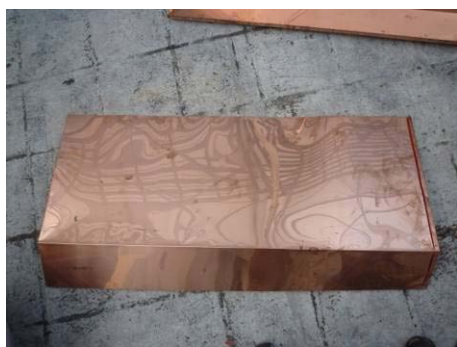
【照片 5-6-27】兩側水切板(倒鈎一側向上一側向下)(98.08.18)
