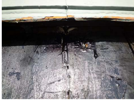
【照片 5-4-33】裂縫修補區域塗抹底油後情形(98. 11. 02)
