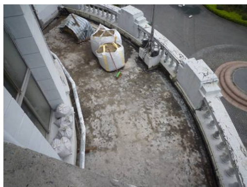
【照片 3-1-179】中央穹頂前側平台的同心圓裂縫(98.12.20)
