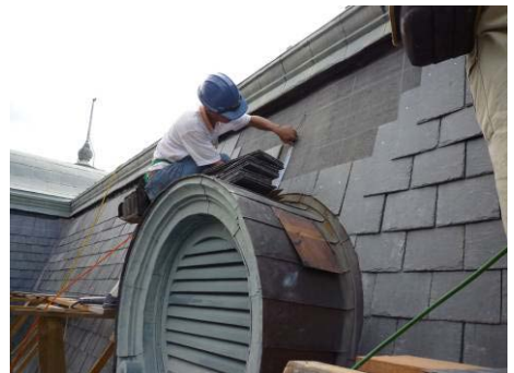
【照片 5-5-105】量測牛眼窗弧率 (98.10.09)
