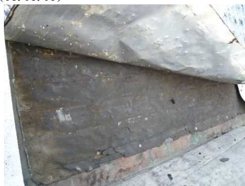
【照片 3-1-121】防水層 4 層：第 3 層鋁板及第 2 層油毛氈(98.08.04)
