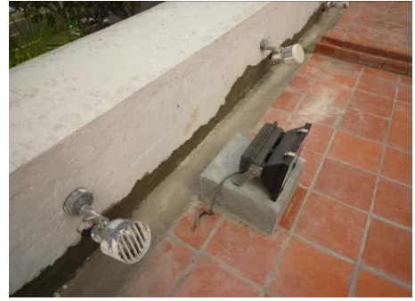
【照片 5-2-22】完成照明燈安裝(99.03.12)
