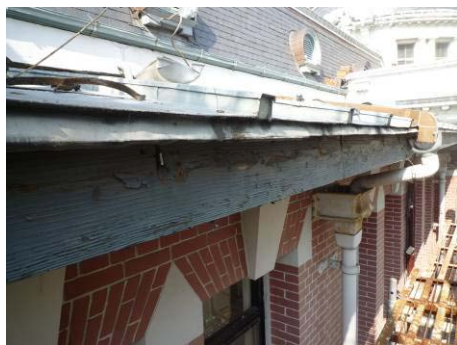
【照片 5-6-127】放樣兩翼天溝洩水坡 度(98.12.22)
