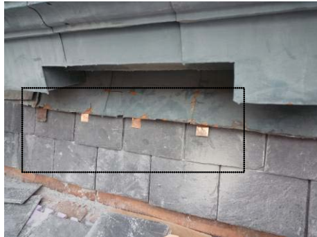
【照片 5-5-100】屋面瓦靠近牛眼窗底部 施作銅吊子固定舊有銅板 (98.10.09)
