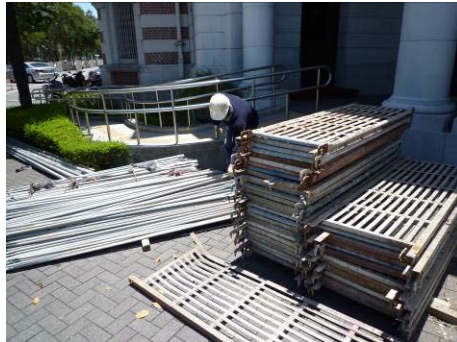
【照片 5-1-5】材料進場(98.05.30)
