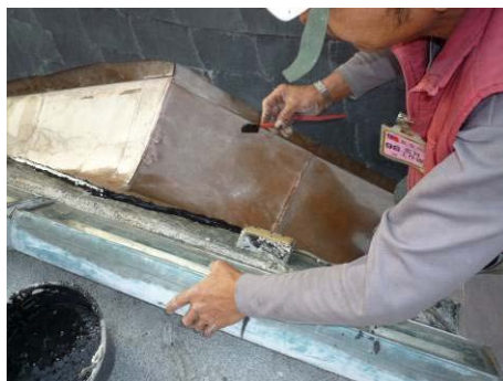
【相片 5-6-355】老虎窗與水切板接合 處塗抹封口膠 (98.12.08)
