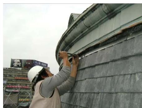
【相片 5-6-364】調整上緣簷板倒鉤 (98.12.04)
