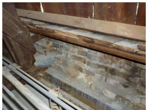
【照片 3-1-7】水切板底層木板(98.09.19)
