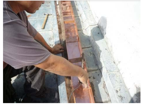
【照片 5-6-230】橫向補強構件以錫焊 固定(98.12.15)
