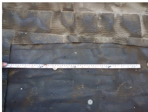
【照片 3-1-144】防水層 4 層：第 3 層油毛氈 (98.11.05)
