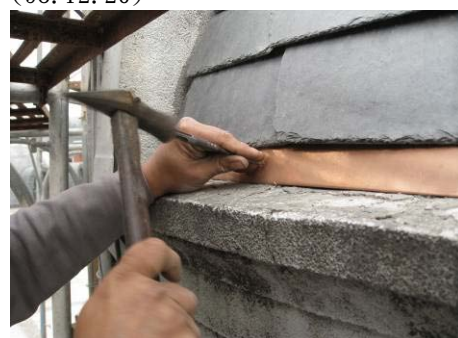
【照片 5-6-380】水切板交接處以鑽頭打孔(98.12.26)
