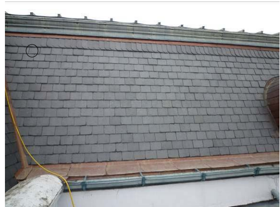
【照片 5-5-139】西翼 21 區抽換石板瓦位置
