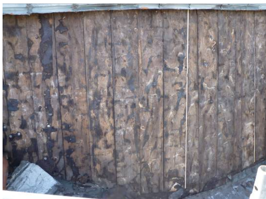
【照片 3-1-69】中央穹頂 5 區屋面板 (98. 11. 05)
