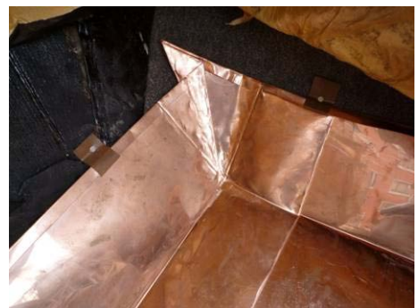
【相片 5-6-76】完成轉折處水切板安裝 (98.10.17)
