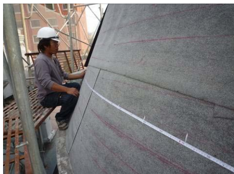
【照片 5-5-202】量測上下圓周,放樣屋面瓦鋪設間距(98.12.10)
