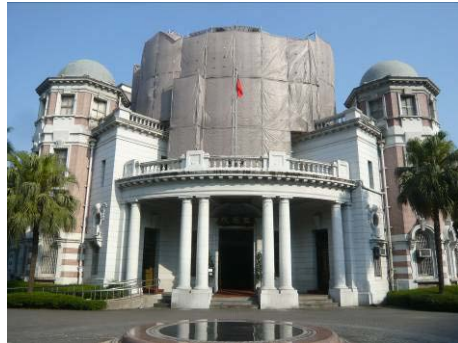
【照片 5-1-15】完成中央穹頂鋼管鷹架搭設(98.05.30)
