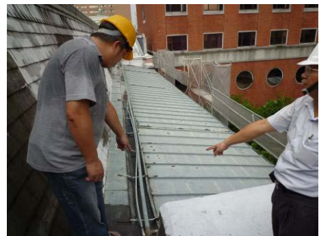
【照片 5-2-28】北翼後側天溝遷移給水管前(給水管置於天溝內)(98.08.19)
