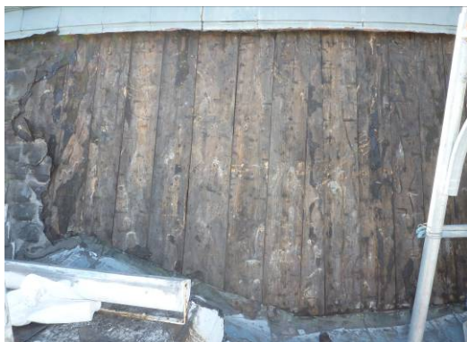
【照片 3-1-67】中央穹頂 3 區屋面板 (98. 11. 05)
