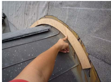
【照片 5-5-94】放樣牛眼窗銅板外露面積(98.10.09)
