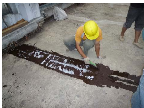
【相片 5-7-25】縫隙表面鋪設 RA 防水 (98.11.11)
