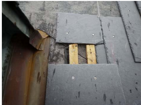
【照片 5-5-48】收邊石板瓦與襯材接合細部(98.09.28)
