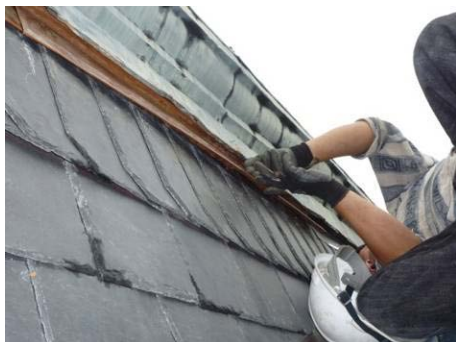
【照片 5-6-173】檢視線板是否固定於不鏽鋼板上(98.10.14)
