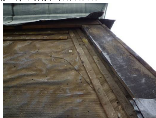
【照片 3-1-90】西翼 1 區斜脊瓦底層木作襯材(98.08.03)
