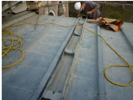
【照片 5-6-207】量測排水溝尺寸(98.12.11)
