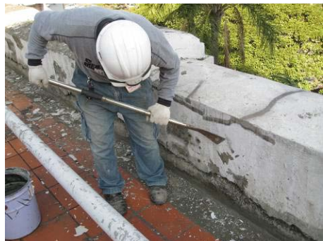
【照片 5-4-77】刮除女兒牆表面浮凸之舊防水層(98.12.24)
