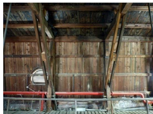
【照片 3-1-56】北翼 13 區屋面板(98.09.17)
