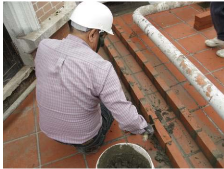
【照片 5-6-239】修補磚砌縫隙及清理 表面(98. 12. 25)
