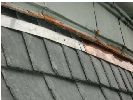
【照片 5-6-365】線板倒鈎與不鏽鋼板相扣 (98.12.06)
