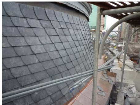
【照片 5-5-196】完成屋面瓦鋪設(98. 11. 30)
