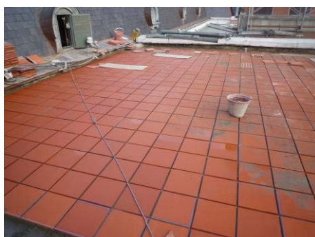
【相片 5-7-51】完成板磚鋪設(98.12.24)
