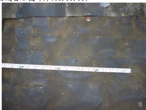
【照片 3-1-138】防水層 3 層:第 2 層油毛氈(98.11.05)
