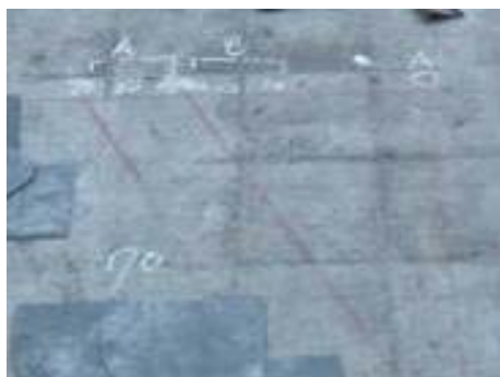
【照片 5-5-162】地面假鋪設,由垂直基準線往左定出 50、60、70 公分斜率 (98.11.07)
