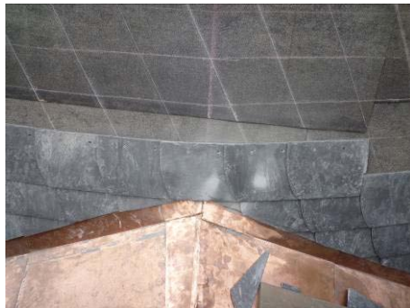
【照片 5-5-194】鋪設屋面瓦(98. 11. 29)
