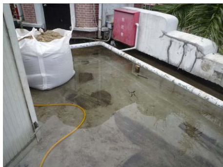
【照片 5-4-63】西翼 1、2、3、4 區平台試水(98. 11. 30)
