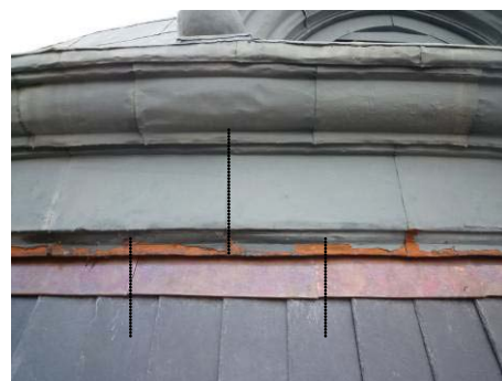
【照片 5-6-368】線板與簷板以交丁方式安裝 (98.12.08)
