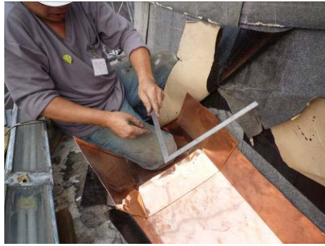
【相片 5-6-349】量測接合尺寸與角度 (98.11.27)
