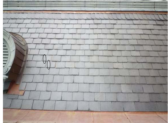
【照片 5-5-123】北翼 10 區抽換石板瓦位置
