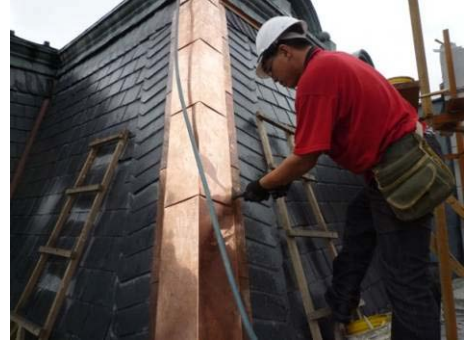
【照片 5-6-206】轉折銅板與線板以平鉗夾緊固定(98.10.22)
