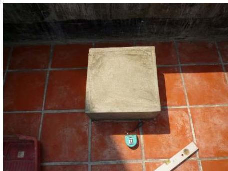
【照片 5-2-19】放樣燈具基座位置(99.03.12)
