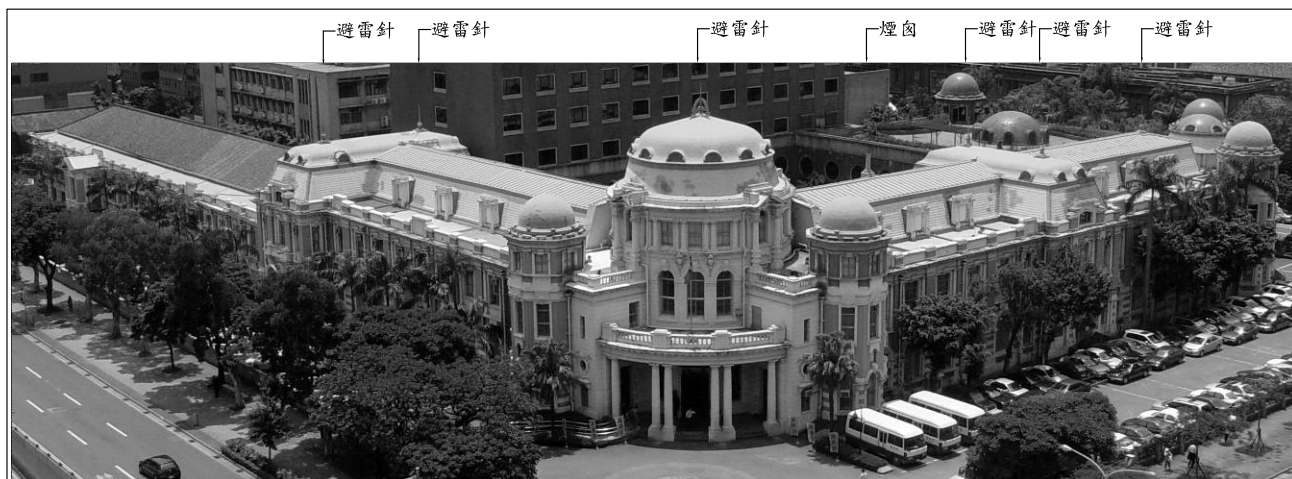
【照片 3-2-39】 監察院屋頂避雷針及煙囪相對位置
