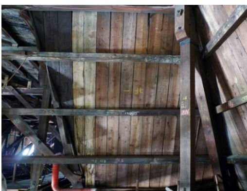
【照片 3-1-38】西翼 20 區屋面板(98.08.20)
