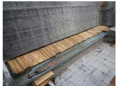
【照片 5-6-40】完成杉木板安裝 (98.09.23)
