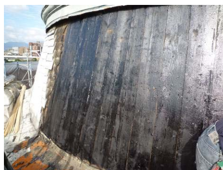
【照片 5-4-32】完成底油塗刷 (98.11.02)
