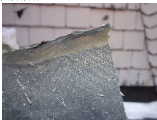
【照片 3-1-82】北翼 8 區之水泥纖維瓦表面紋路(98.09.02)
