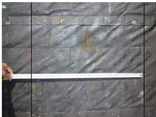
【照片 3-1-126】防水層 2 層:第 2 層油毛氈放樣線 60 公分(98.08.25)
