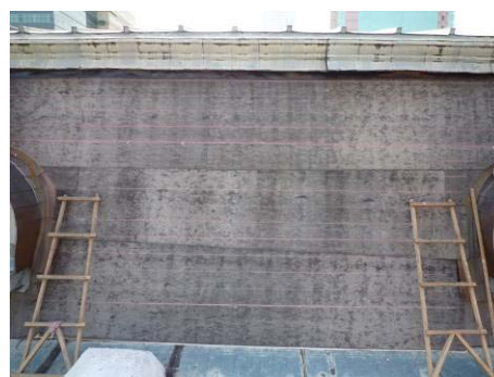
【照片 5-5-85】完成水平放樣線彈記(98.09.17)
