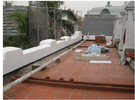
【照片 5-6-240】完成磚砌保護基座 (98. 12. 25)
