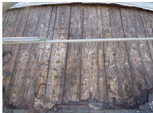
【照片 3-1-68】中央穹頂 4 區屋面板 (98. 11. 05)
