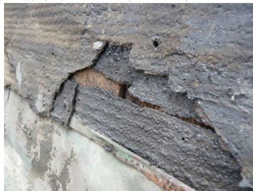
【照片 3-1-125】防水層 4 層：第 2 層油毛氈與第 1 層油毛氈(98.08.19)
