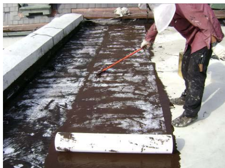
【照片 5-4-51】全面性鋪設:鋪設不織布(98.12.05)
