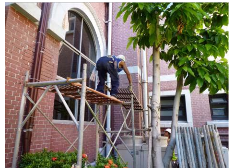
【照片 5-1-10】鋪設鋼板(98.05.30)
