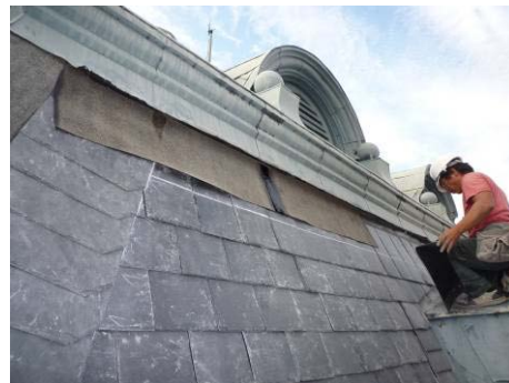
【照片 5-5-71】鋪設防水毯(98.09.30)
