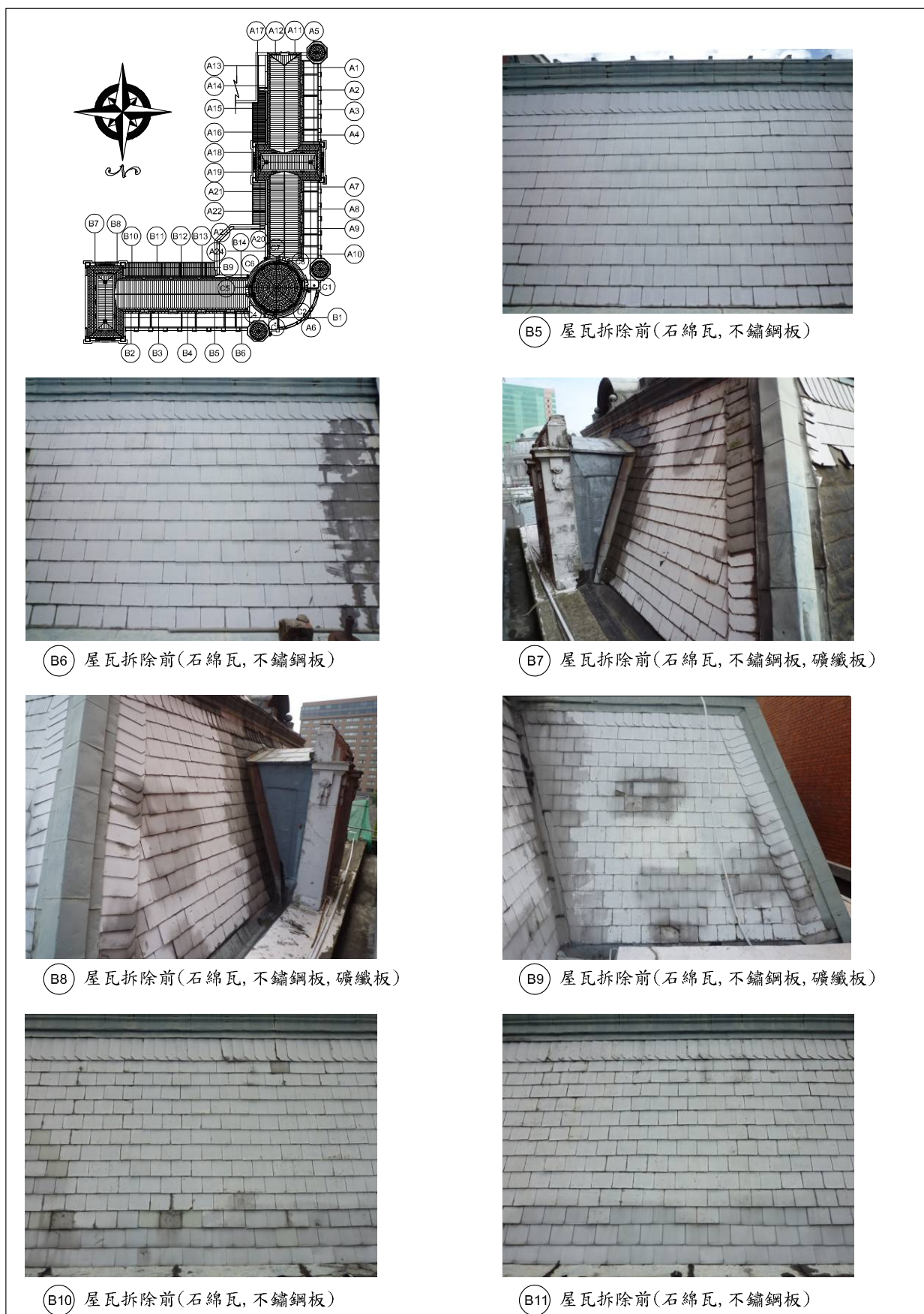
【圖 3-1-14】監察院屋瓦拆除前材料記錄
