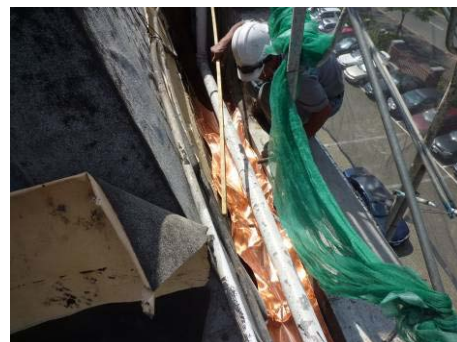
【照片 5-6-116】銅板以鈹金槌配合拍打木輕敲調整形狀 (98.10.25)
