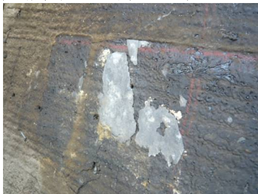
【照片 3-1-124】防水層 4 層：第 2 層油毛氈表面殘留之石板碎片(98.08.19)
