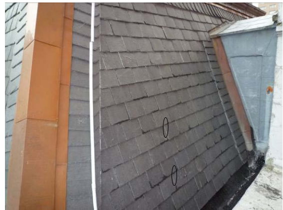
【照片 5-5-125】北翼 8 區抽換石板瓦位置
