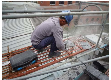
【照片 5-5-187】裁切屋面瓦倒角 (98.11.29)
