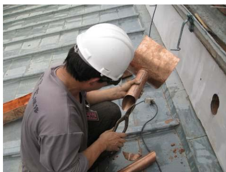
【照片 5-6-283】裁切重新以倒角圓管接合(98. 12. 26)
