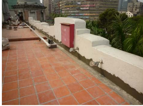
【相片 5-7-77】完成牆體表面修飾(99.03.11)
