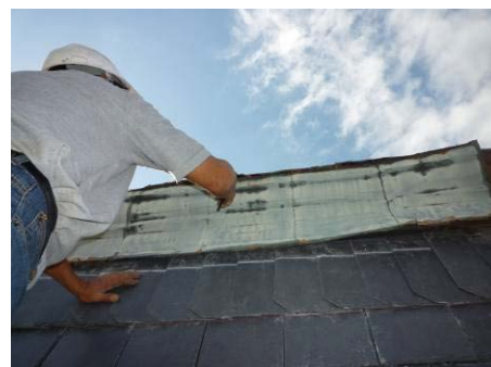
【照片 5-6-148】調整銅板倒鈎 (98.11.25)
