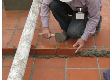
【照片 5-6-238】依放樣線鋪設紅磚 (98. 12. 25)
