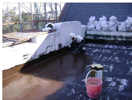
【照片 5-4-54】全面性鋪設:塗刷面層橡膠瀝青(98.12.06)
