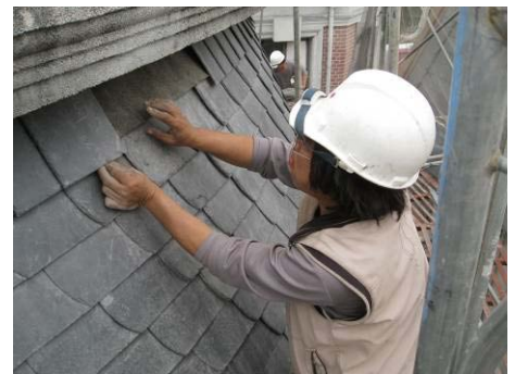
【照片 5-5-211】鋪設自黏式防水毯 (98. 12. 17)
