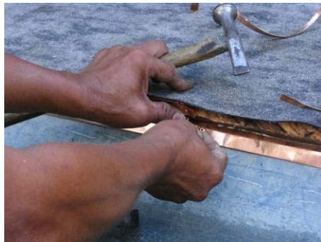
【照片 5-6-57】收邊銅板以倒鈎與天溝相扣固定(98.09.25)
