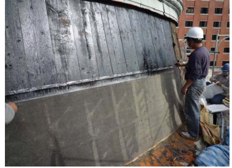
【照片 5-4-34】鋪設下層防水毯(98. 11. 02)
