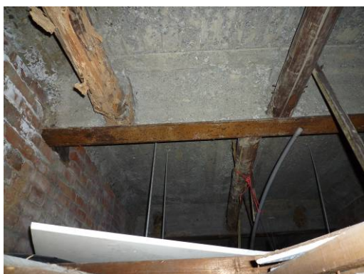
【照片 3-1-151】西翼 13.14 區平台之工字形鋼樑與木桁(98.10.10)
