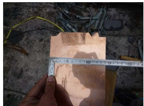
【照片 5-6-164】銅板彎摺之收邊切口 (98.10.14)
