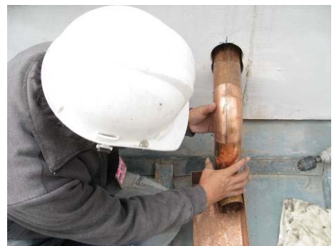
【照片 5-6-292】完成天溝落水管安裝 (98.12.26)
