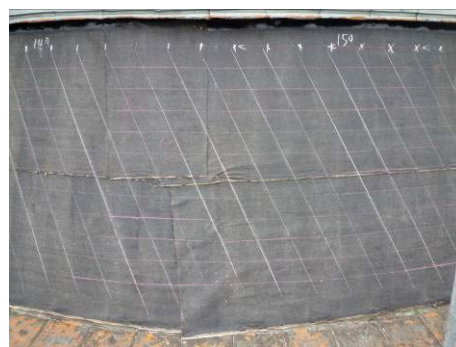
【照片 5-5-177】完成屋面放樣 (98.11.08)
