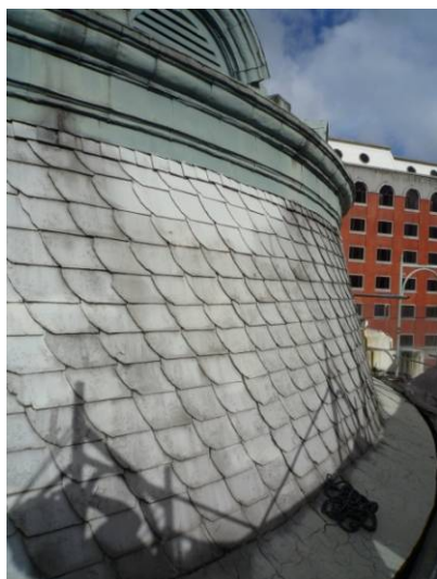
【照片 3-1-99】中央穹頂 1 區屋瓦拆除前為 14 層(98.07.13)
