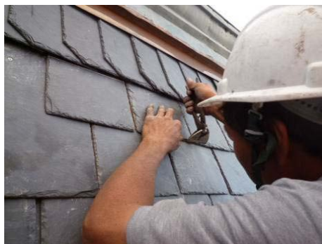
【照片 5-5-160】銅板反摺固定石板瓦 (98. 11. 25)
