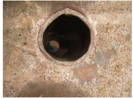
【照片 5-6-278】落水管與天溝初步接合完成(98. 12. 25)
