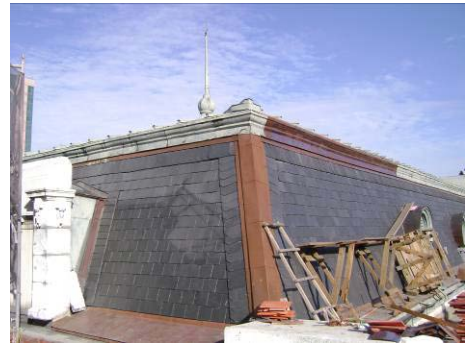
【照片 5-6-160】完成上緣簷板安裝 (98.12.03)
