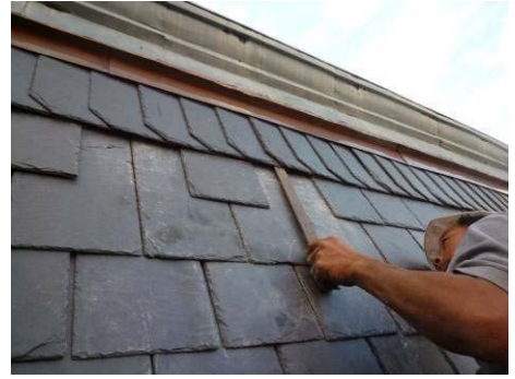
【照片 5-5-155】拔釘器斬斷固定石板瓦之螺絲釘(98. 11. 25)
