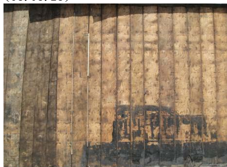
【照片 5-4-7】屋面板塗刷底油前情況 (98.08.25)
