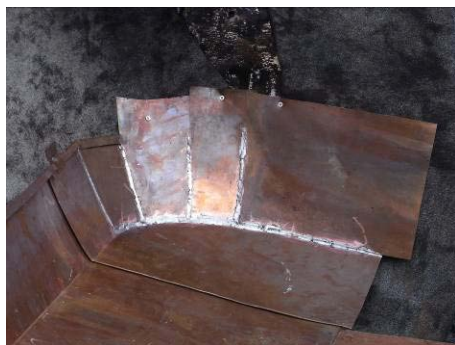
【相片 5-6-83】完成轉折處水切板安裝(98.10.02)
