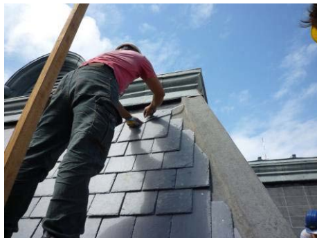
【照片 5-5-58】放樣斜脊瓦位置 (98.09.30)
