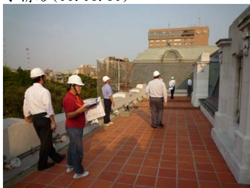
【照片 6-2-8】檢視石板瓦施作情形(99. 03. 30)
