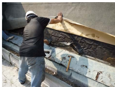
【照片 5-3-26】反折固定已施作的 自黏式防水毯(98.08.14)
