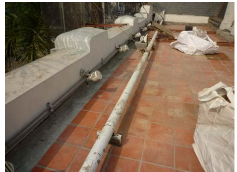
【照片 5-2-44】完成消防管線安裝 (99.03.12)
