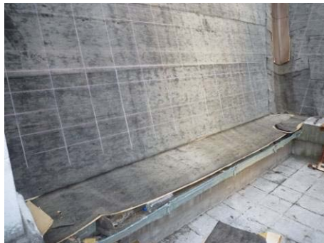
【照片 5-6-49】完成防水毯鋪設(98.09.23)
