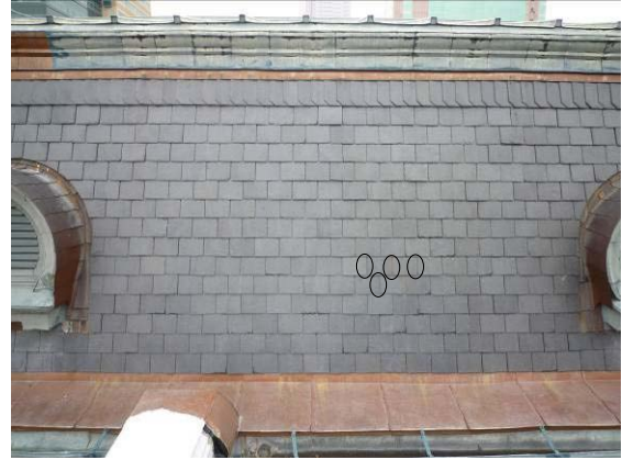
【照片 5-5-135】西翼 14 區抽換石板瓦位置
