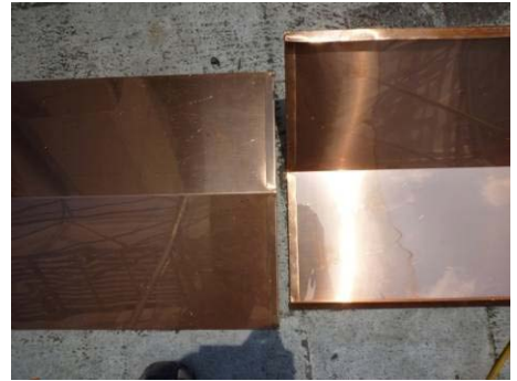
【相片 5-6-96】谷溝正反倒鈎細部(98.08.26)
