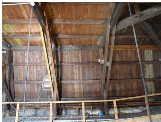
【照片 3-1-31】西翼 13 區屋面板(98.08.20)
