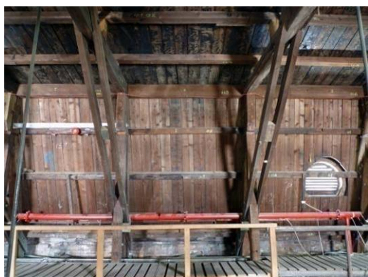
【照片 3-1-55】北翼 12 區屋面板(98.09.17)
