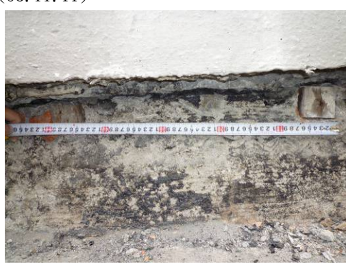
【照片 3-1-188】西翼 1 區平台(第二期興建)天溝磚砌基座之木磚間距 45 公分(98.11.02)
