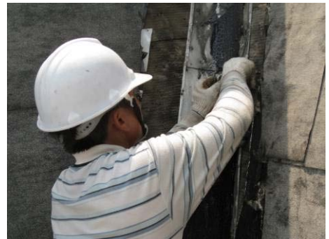
【照片 5-3-22】拔除不鏽鋼釘 (98.08.27)
