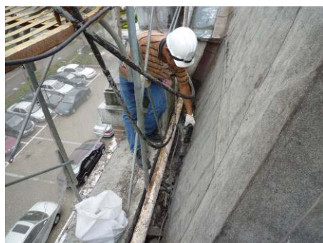
【照片 5-2-34】敲除天溝之舊有防水層(98.09.28)
