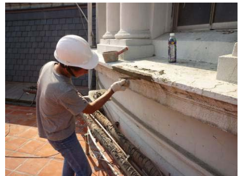
【相片 5-7-92】填補水泥砂漿(99.03.12)
