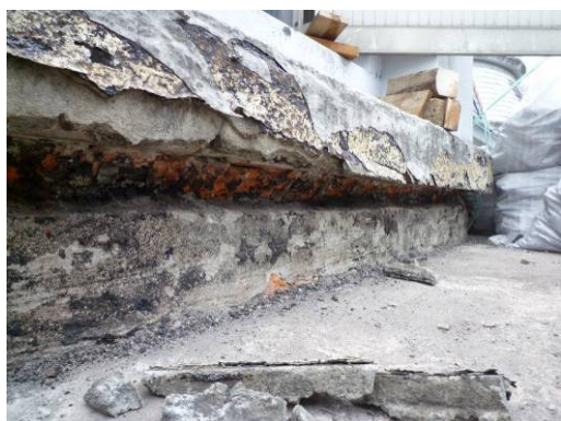
【照片 3-1-183】西翼 1.2.3.4 區平台(第二期興建)老虎窗原本覆蓋的底層基座(98.11.01)
