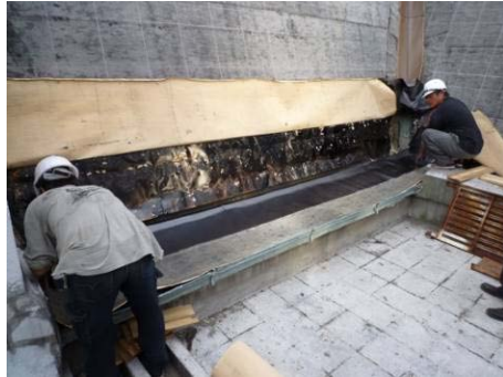
【照片 5-6-47】鋪設防水毯(98.09.23)
