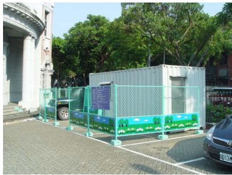
【照片 5-1-3】工程告示牌貼設於工務所外側圍籬 (98.05.30)
