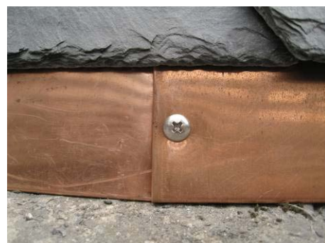
【照片 5-6-382】螺絲釘固定後細部(98.12.26)
