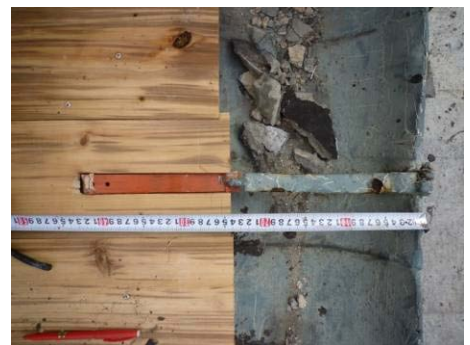
【照片 5-6-44】安裝固定器基座完成 (98.09.23)
