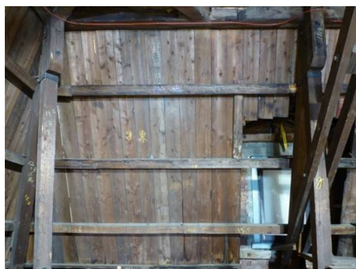
【照片 3-1-50】北翼 7 區屋面板(98.09.17)
