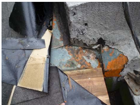
【相片 5-6-325】老虎窗頂杉木板鋪設情形(98. 11. 24)
