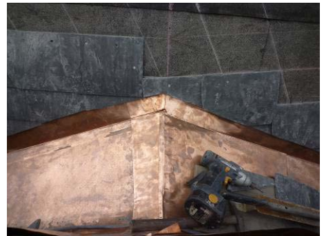
【照片 5-5-193】鋪設屋面瓦(98. 11. 29)
