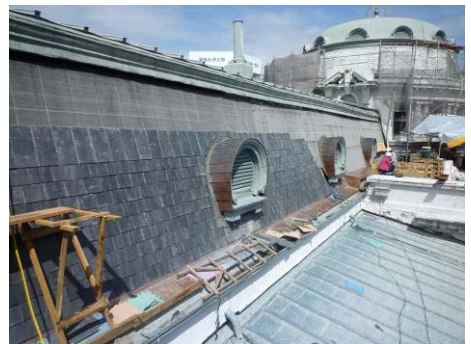
【照片 5-5-103】鋪設屋面瓦 (98.10.09)
