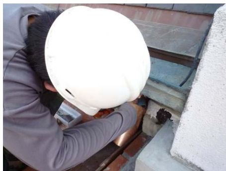
【照片 5-6-251】電鑽鑽孔，拉釘固定 (99. 03. 06)
