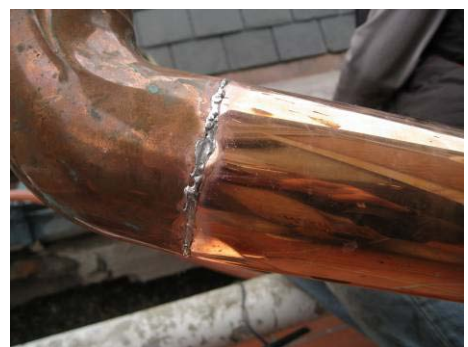
【照片 5-6-284】接合處以錫焊固定(98. 12. 26)
