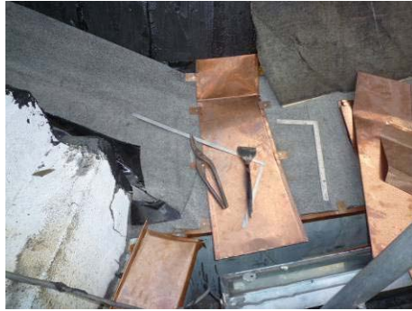
【相片 5-6-341】安裝水切板 (98.11.27)
