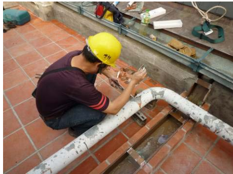
【照片 5-2-41】放樣基座位置，電鑽 鑽孔(99.03.05)
