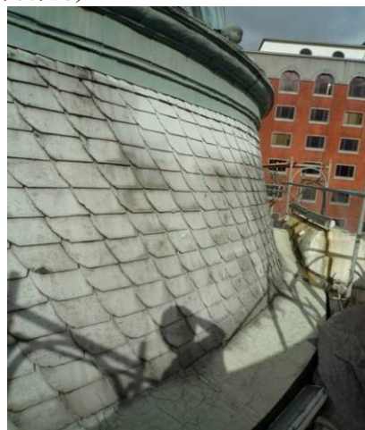
【照片 3-1-106】中央穹頂 8 區屋瓦拆除前為 14 層(98.07.13)
