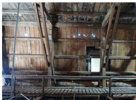
【照片 3-1-25】西翼 7 區屋面板(98.08.20)
