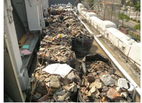
【照片 5-3-48】完成西翼平台鋪面 敲除(98.11.08)
