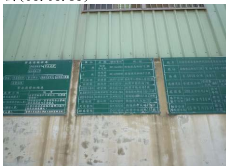
【相片 5-3-69】廢棄物工廠相關告示牌(98.08.15)
