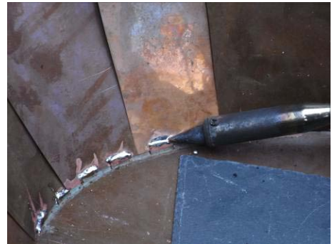
【相片 5-6-80】錫焊填縫固定(98.10.02)
