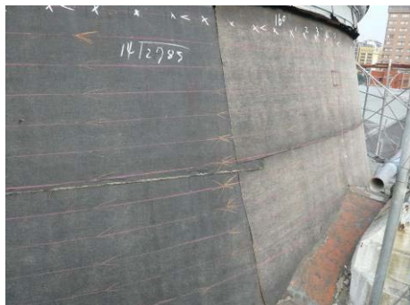
【照片 5-5-168】完成水平放樣線彈記 (98.11.08)
