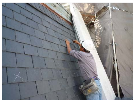
【照片 5-5-144】檢視各區含有金屬結晶或破損之石板瓦(98.11.27)
