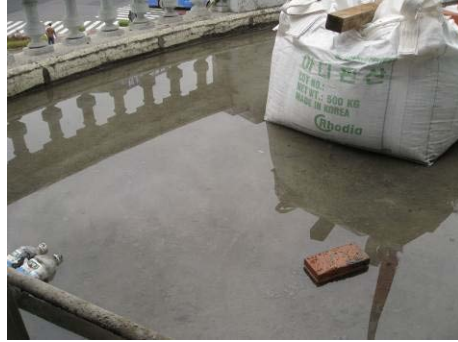
【照片 5-4-73】中央穹頂前側扇形平台試水(98.12.21)
