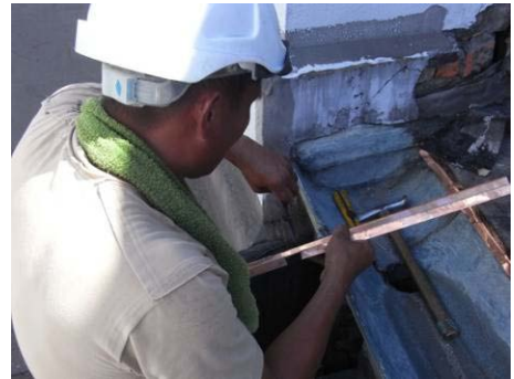
【照片 5-6-56】裁切固定器基座位置(98.09.25)
