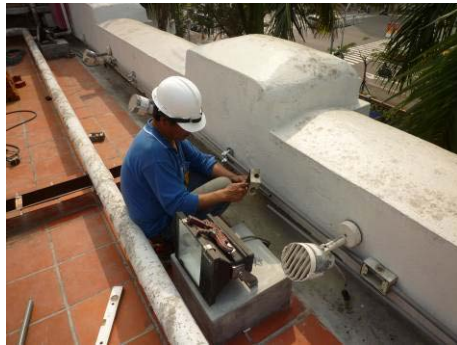
【照片 5-2-23】安裝配管線路(99.03.12)
