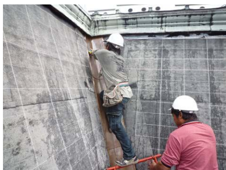
【照片 5-5-36】彈記谷溝外露尺寸(98.09.28)
