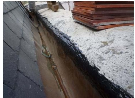
【照片 5-6-126】銅板與牆面接合處塗 刷封口膠(98.12.23)
