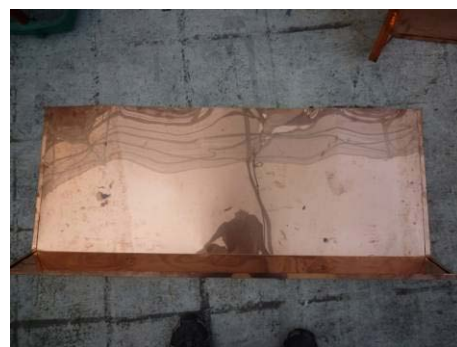
【照片 5-6-28】水切板中央基準塊(兩側倒鈎皆向上)(98.08.18)
