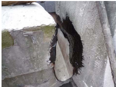
【照片 5-6-125】銅板與牆面接合處塗 刷封口膠(98.12.23)
