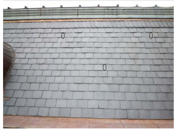
【照片 5-5-119】北翼 12 區抽換石板瓦位置
