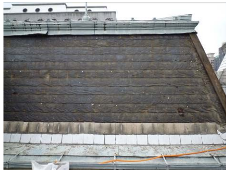
【照片 5-3-11】完成屋瓦拆除 (98.08.03)
