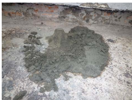
【相片 5-7-29】放樣水泥砂漿高度 (98.11.24)
