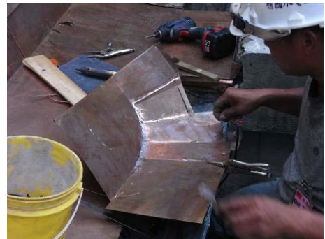
【相片 5-6-82】錫焊填縫固定(98.10.02)
