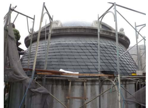
【照片 5-5-213】完成大礮堡石板瓦鋪 設(98. 12. 20)
