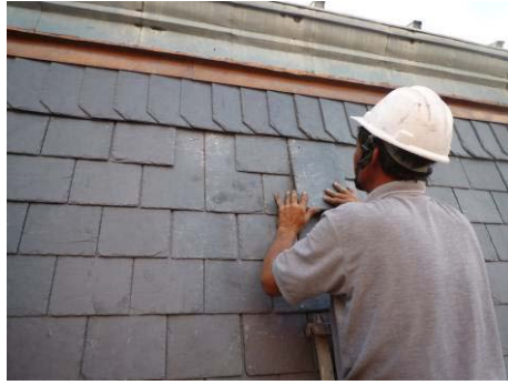
【照片 5-5-154】清理破損之石板瓦 (98. 11. 25)
