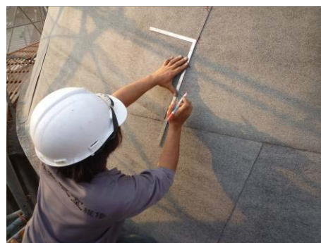
【照片 5-5-199】量測總長放樣水平放樣線(98.12.10)
