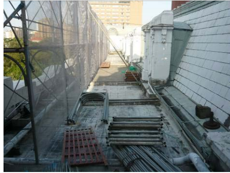
【照片 5-1-13】完成北翼鋼管鷹架搭設 (98.05.30)
