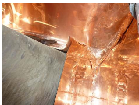
【照片 5-6-119】設置接合倒鈎 (98.10.25)
