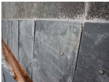
【照片 5-5-32】完成起手瓦鋪設(98.09.28)
