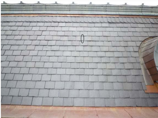
【照片 5-5-122】北翼 11 區抽換石板瓦位置
