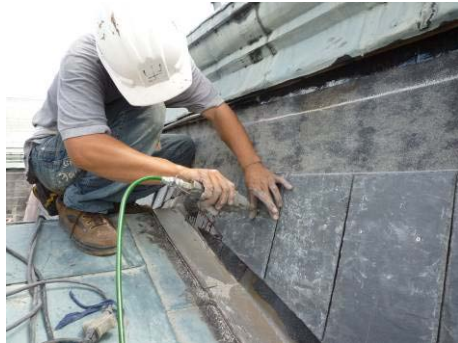
【照片 5-5-56】固定石板瓦(98.09.30)
