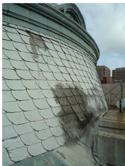
【照片 3-1-101】中央穹頂 3 區屋瓦拆除前為 14 層(98.07.13)
