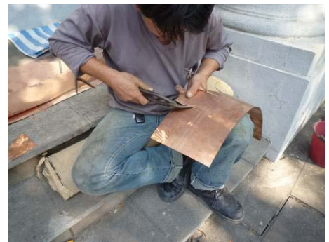
【照片 5-6-224】排水溝轉折處施作(98. 12. 11)
