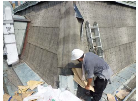
【照片 5-4-22】斜脊鋪設自黏式防水毯 (98.08.25)
