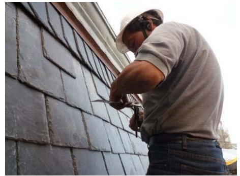
【照片 5-5-157】裁切銅板並彎摺施作 1.5 公分倒鉤(98. 11. 25)
