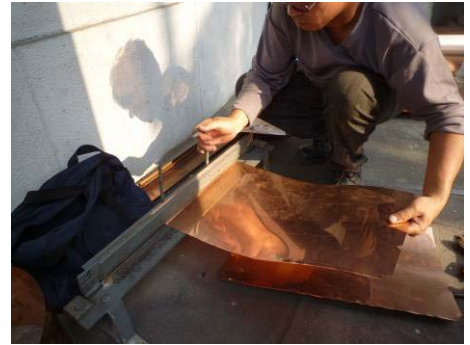
【照片 5-6-216】彎摺兩端倒鈎 (98. 12. 11)
