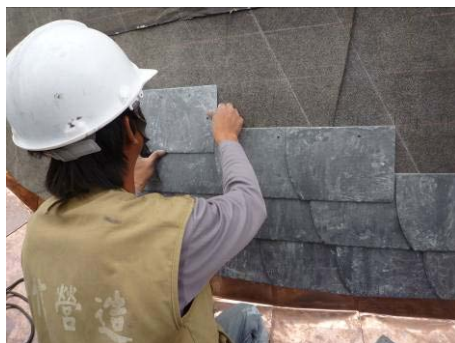
【照片 5-5-188】依放樣線鋪設石板瓦 (98.11.29)
