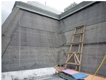
【相片 5-6-97】屋面轉折處，谷溝施作前樣貌(98.10.07)
