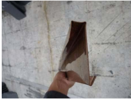
【照片 5-165】銅板彎摺成形 (98.10.14)
