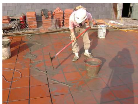
【相片 5-7-52】填補縫隙(98.12.24)
