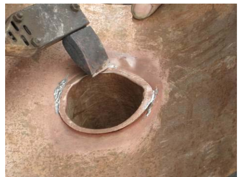
【照片 5-6-280】接合處以錫焊固定(98. 12. 25)
