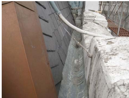
【照片 5-6-141】清掃天溝表面積水及灰塵(98. 12. 24)
