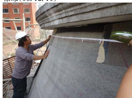
【照片 5-5-201】量測上下圓周,放樣屋面瓦鋪設間距(98.12.10)
