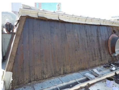
【照片 5-4-9】完成屋面底油塗刷 (98.08.25)
