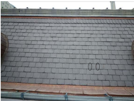
【照片 5-5-140】西翼 22 區抽換石板瓦位置
