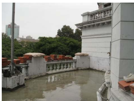
【相片 5-7-57】水泥粉平均拋灑至砂漿表面濕潤但不積水(98.12.26)
