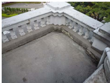
【照片 5-3-58】完成中央穹頂右側平台鋪面敲除(98. 12. 20)
