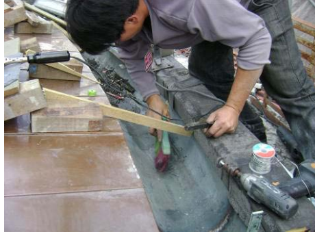
【照片 5-6-369】檢視天溝搭接處是否有裂縫(98.12.07)
