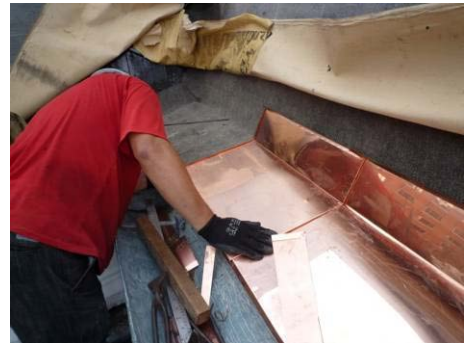
【照片 5-6-64】安裝水切板(98.09.25)
