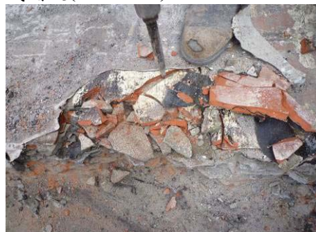
【照片 5-3-36】第1層防水塗料、第2層板磚及第3層水泥砂漿(98.10.31)
