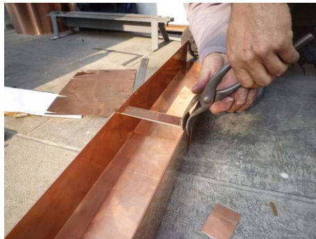
【照片 5-6-223】橫向構件假固定，輕壓檢視兩側銅板是否容易變形(98. 12. 11)
