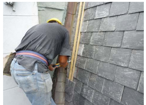
【照片 5-5-45】襯材外側塗抹矽利康 補強(98.09.28)
