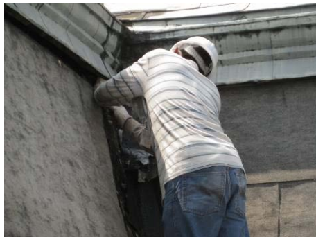
【照片 5-3-21】拆除銅板下層油毛 氈(98.08.27)
