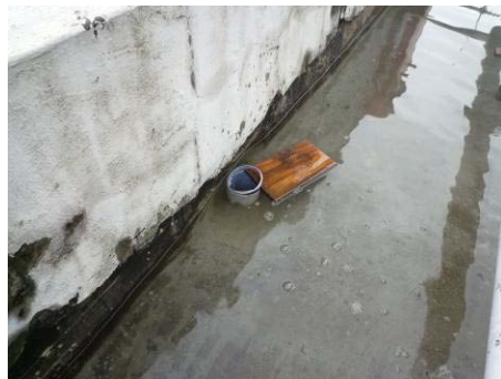
【照片 5-4-69】塑膠落水管(98.12.17)
