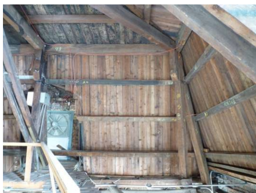
【照片 3-1-29】西翼 11 區屋面板(98.08.20)
