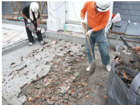
【照片 5-3-51】敲除北翼平台鋪面 (98.11.21)
