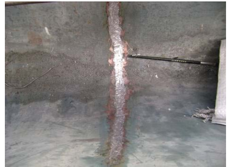
【照片 5-6-374】完成天溝裂縫整修(98.12.07)
