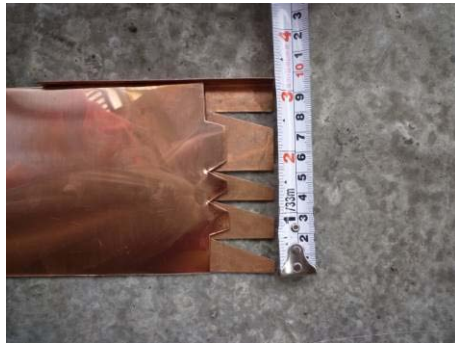
【照片 5-6-31】收邊切口細部 (98.10.09)
