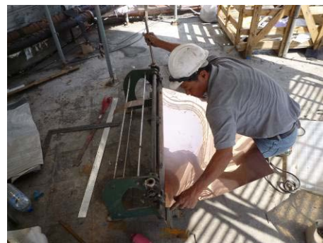
【照片 5-6-112】裁切銅板並初步彎摺成形 (98.10.25)
