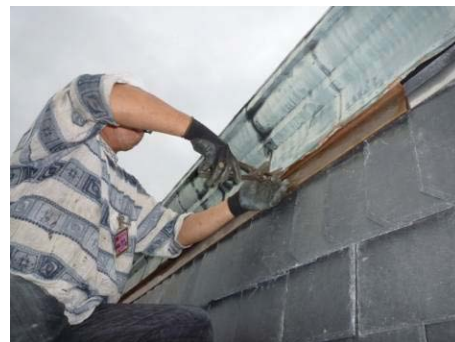
【照片 5-6-174】新舊交接處處理(98.10.14)
