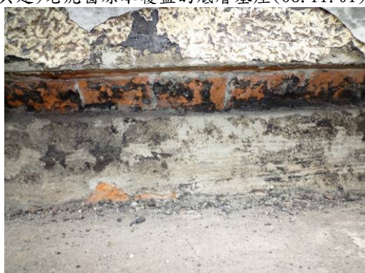
【照片 3-1-185】西翼 1.2.3.4 區平台(第二期興建)老虎窗原本覆蓋的底層基座(98.11.01)
