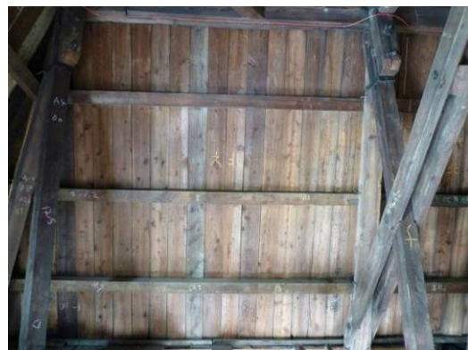
【照片 3-1-23】西翼 6 區屋面板(98.08.20)
