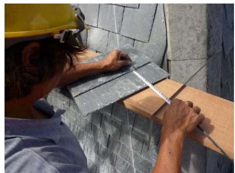
【照片 5-5-61】量測斜脊瓦搭接外露面積(98.09.30)
