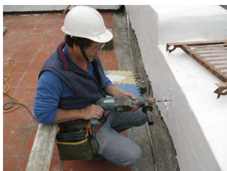
【照片 5-2-11】檢視照明設備位置(98.12.26)
