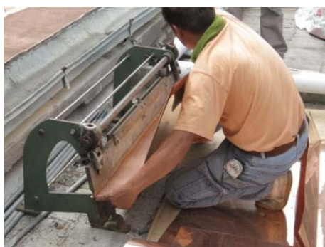
【照片 5-6-19】彎摺銅板兩側相扣倒鉤 (98.08.18)
