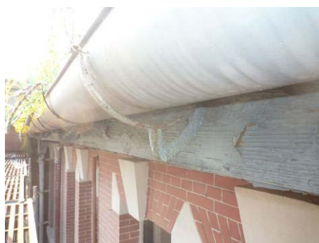
【相片 5-3-60】單坡斜屋頂天溝形式(98. 12. 22)
