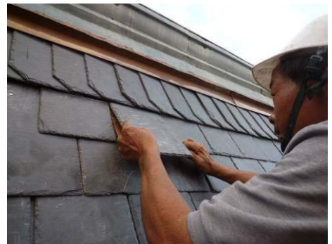
【照片 5-5-159】安裝石板瓦 (98. 11. 25)
