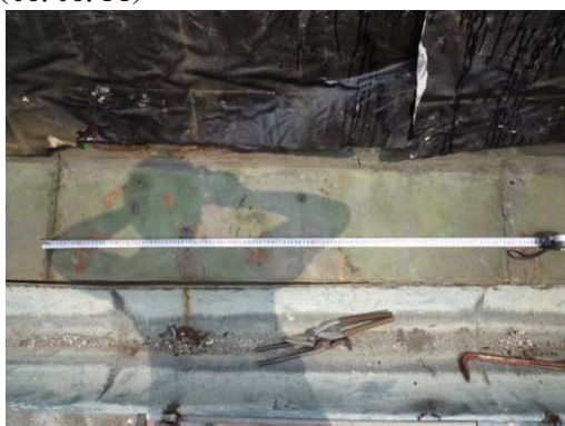
【照片 3-1-110】第 1 層原始銅製水切板每段長約 60 公分(98.08.14)
