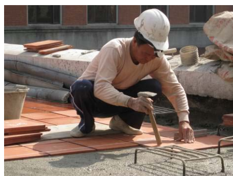
【相片 5-7-50】輕敲板磚至與水泥砂漿密合(98.12.24)
