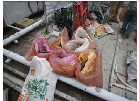
【照片 5-3-14】石棉瓦裝袋 (98.08.03)
