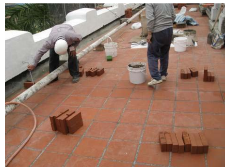
【照片 5-6-236】拉線放樣排水溝位置 (98.12.25)
