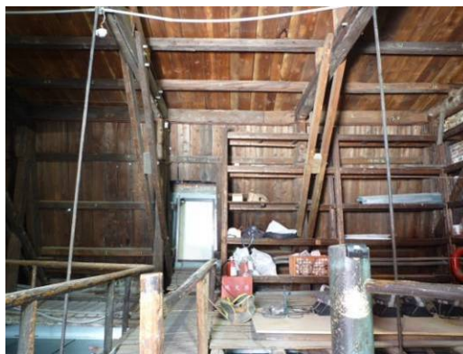
【照片 3-1-28】西翼 10 區屋面板(98.08.20)
