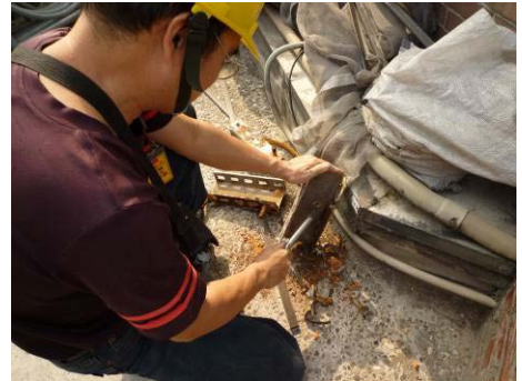
【照片 5-2-40】整理原有構件，檢視 堪用情形(99.03.05)
