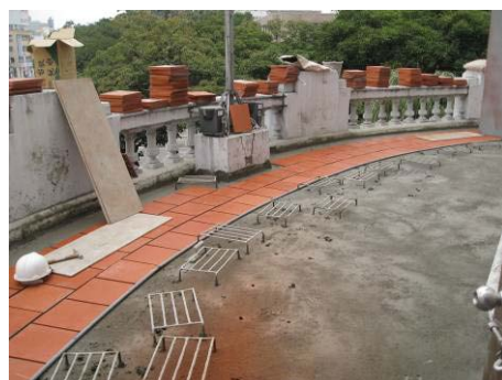
【相片 5-7-60】依弧度鋪設板磚(98.12.26)
