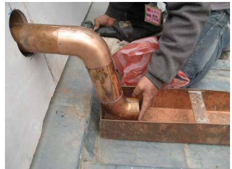
【照片 5-6-290】調整落水管位置 (98.12.26)
