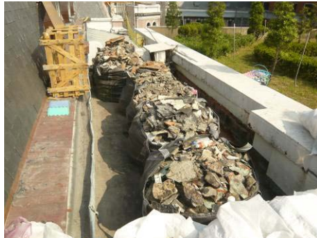
【照片 5-3-49】完成西翼平台鋪面 敲除(98.11.08)
