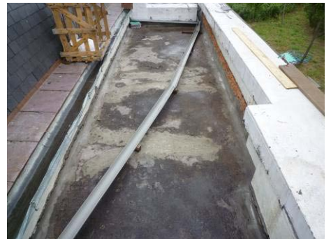
【相片 5-7-10】完成西翼平台裂縫修補 (98.11.11)
