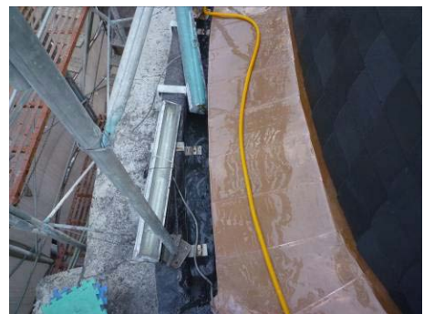
【照片 5-6-376】靜置 1 天，檢查是否有漏水跡象(98.12.11)
