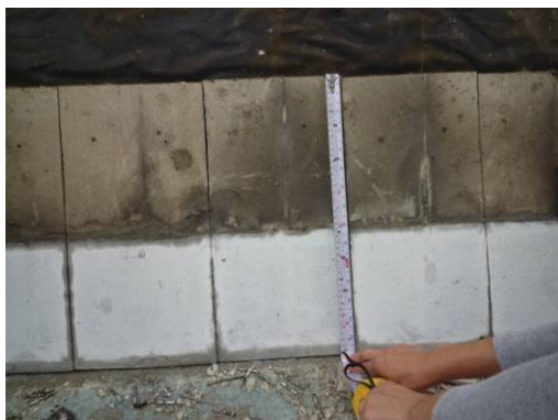
【照片 3-1-79】西翼 1 區之石綿瓦(98.08.03)
