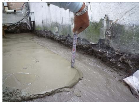
【相片 5-7-36】量測水泥砂漿高度，外側約 3 公分(98.11.24)
