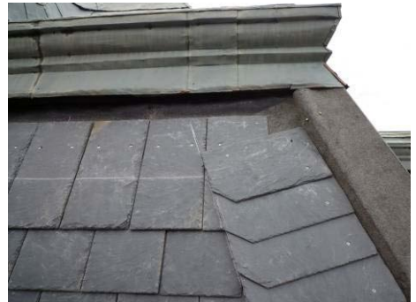
【照片 5-5-67】完成斜脊瓦鋪設 (98.09.30)
