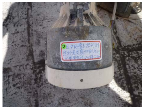
【照片 5-2-6】標記(D區女兒牆上投射燈對照老虎窗雙側柱心，燈座固定於女兒牆下 18 公分)(98.08.01)
