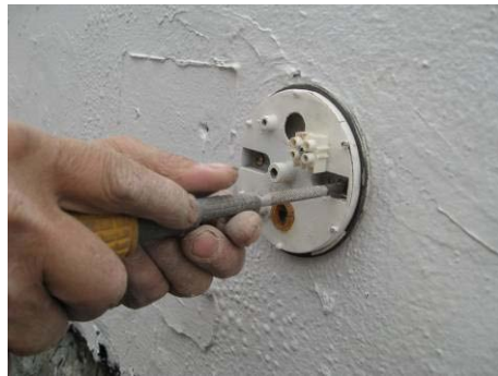
【照片 5-2-15】安裝基座(98.12.26)
