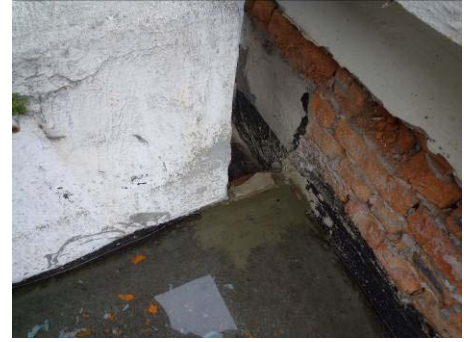
【照片 5-4-66】西翼 13、14 區平台試水(98.11.28)
