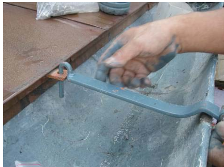
【照片 5-6-315】檢視天溝固定器接合 狀況(98.12.24)
