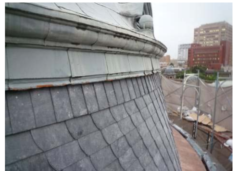
【照片 5-5-197】完成屋脊瓦鋪設(98. 11. 30)
