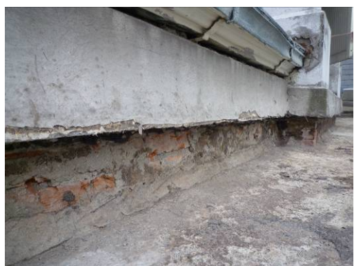
【照片 3-1-187】西翼 7.8.9.10 區平台(第一期興建)天溝磚砌基座(98.11.11)
