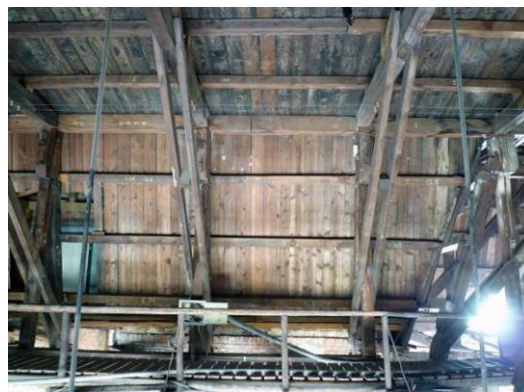
【照片 3-1-20】西翼 4 區屋面板(98.08.20)
