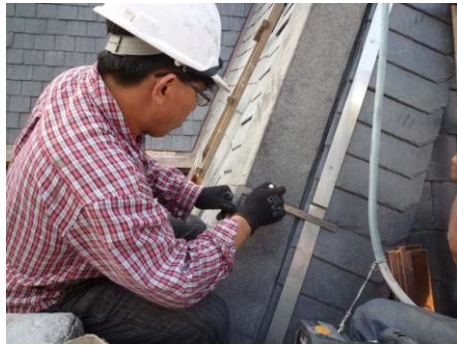
【照片 5-6-191】放樣轉折銅板與線板位置(98.10.22)
