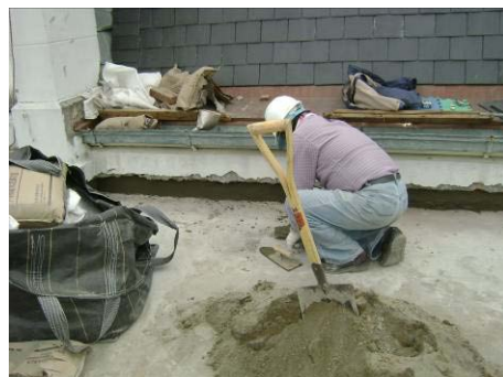
【相片 5-7-16】修補結構交接處裂縫(98.12.06)
