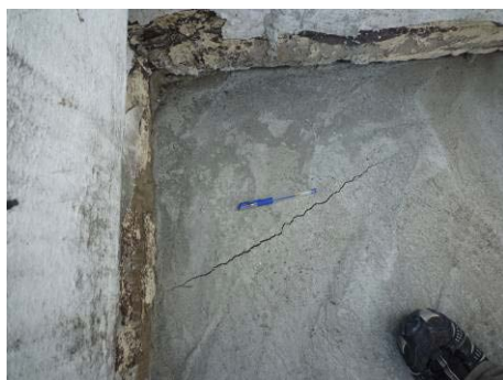
【照片 5-4-41】檢視現場打底完成之水泥砂漿是否產生裂縫(98.11.25)
