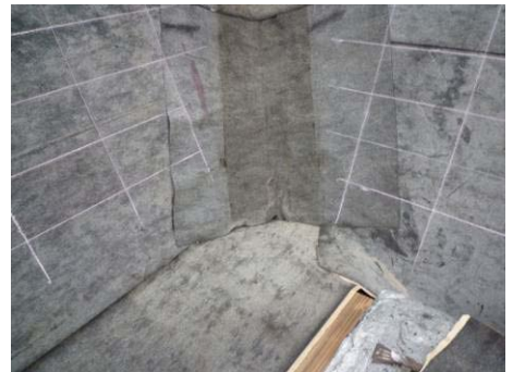
【照片 5-6-50】防水毯覆蓋於最下層(98.09.23)
