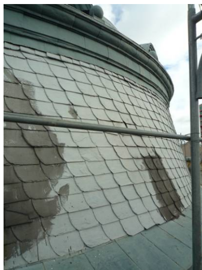
【照片 3-1-100】中央穹頂 2 區屋瓦拆除前為 14 層(98.07.13)
