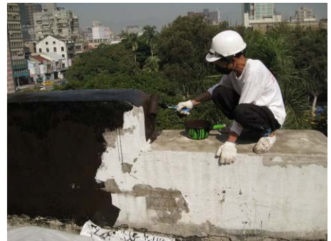
【照片 5-4-78】塗刷底層黑色橡膠瀝青(98.12.24)
