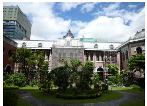
【照片 5-1-12】完成內側鋼管鷹架搭設(98.05.30)
