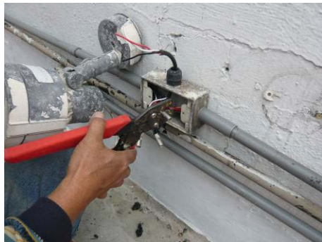
【照片 5-2-25】安裝電線(99.03.14)
