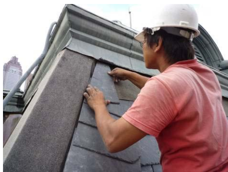
【照片 5-5-72】鋪設屋脊瓦(98.09.30)
