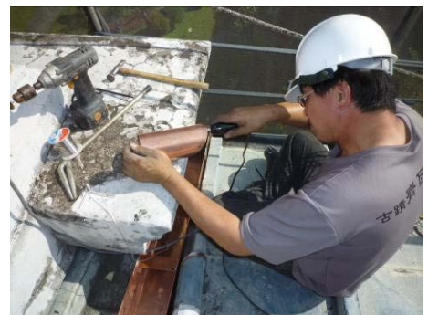
【照片 5-6-300】倒鈎接合處以錫焊固 定補強(98.12.15)
