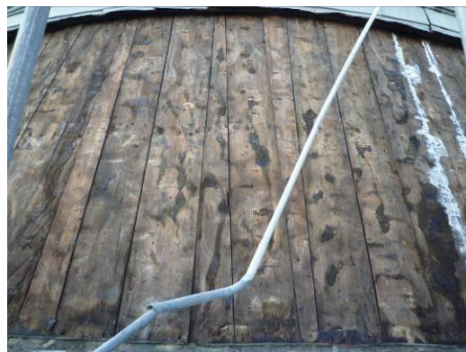
【照片 3-1-70】中央穹頂 6 區屋面板 (98. 11. 05)
