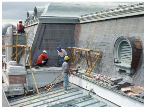
【照片 5-5-104】搭設臨時工作架 (98.10.09)
