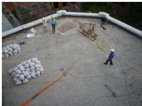
【照片 5-3-55】完成 M 形樓梯平台鋪面敲除(98. 11. 21)
