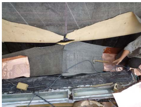
【相片 5-6-347】安裝老虎窗頂水切板 (98.11.27)
