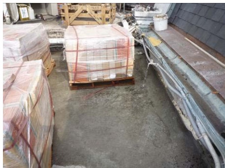
【照片 5-4-57】西翼 7、8、9、10 區平台試水(98. 11. 30)
