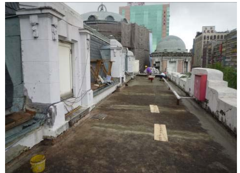
【相片 5-7-12】完成北翼平台裂縫修補 (98.11.24)
