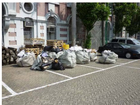
【相片 5-3-67】廢棄物統一吊至地面(98.08.15)
