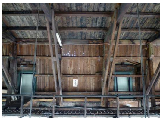
【照片 3-1-18】西翼 2 區屋面板(98.08.20)
