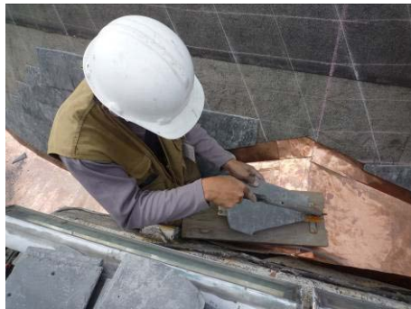
【照片 5-5-192】裁切石板瓦設置毛邊(98. 11. 29)
