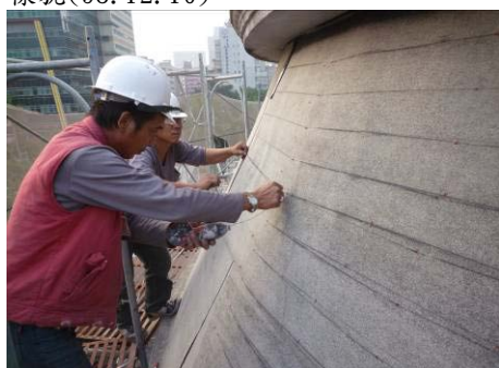
【照片 5-5-200】分段彈記水平放樣線(98.12.10)
