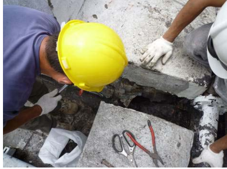
【照片 5-2-37】天溝塗抹防水膠 (98.09.28)
