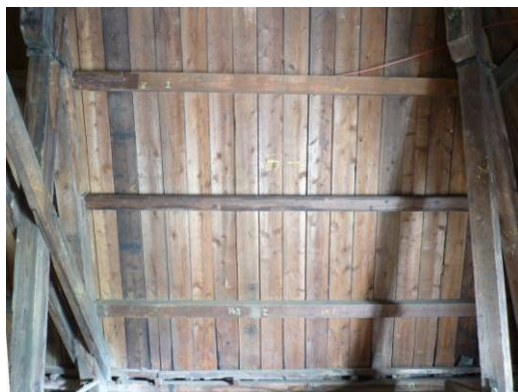
【照片 3-1-43】北翼 1 區屋面板(98.09.17)
