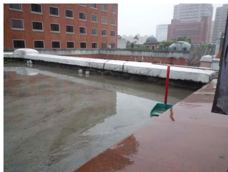
【照片 5-4-71】M 形樓梯平台試水(98.12.15)
