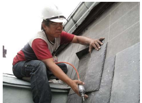
【照片 5-5-51】覆蓋屋面瓦(98.09.30)
