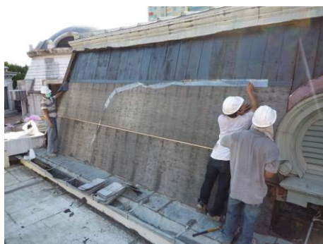
【照片 5-4-15】鋪設第 2 層防水毯 (98.08.25)
