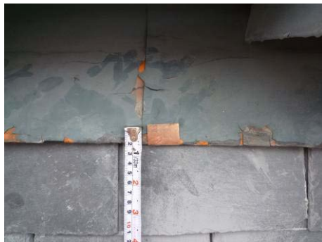
【照片 5-5-102】吊子固定後細部 (98.10.09)
