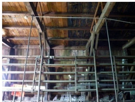
【照片 3-1-48】北翼 5 區屋面板(98.09.17)
