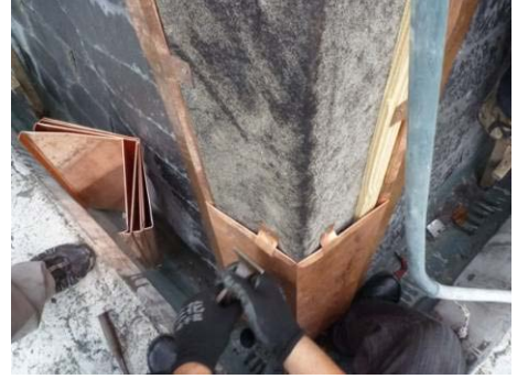
【照片 5-6-198】安裝轉折銅板，於倒 鉤處以吊子植入斜紋釘固定 (98.10.22)
