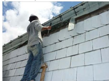
【照片 5-3-6】拆除銅線板(98.08.03)
