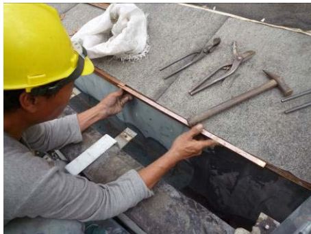
【相片 5-6-337】收邊銅板下緣鉤住舊水切板倒鉤(98. 11. 24)
