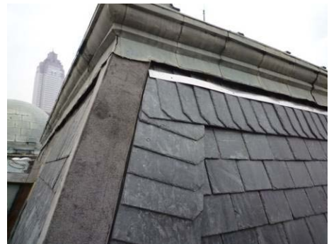
【照片 5-6-168】不鏽鋼板細部 (98.10.14)
