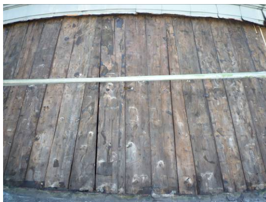
【照片 3-1-66】中央穹頂 2 區屋面板 (98.11.05)
