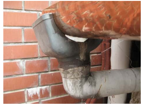
【照片 5-6-140】完成塑膠落水管安裝 (98. 12. 22)
