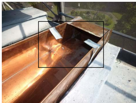
【照片 5-6-233】排水溝舊構件再利用 (98.12.15)
