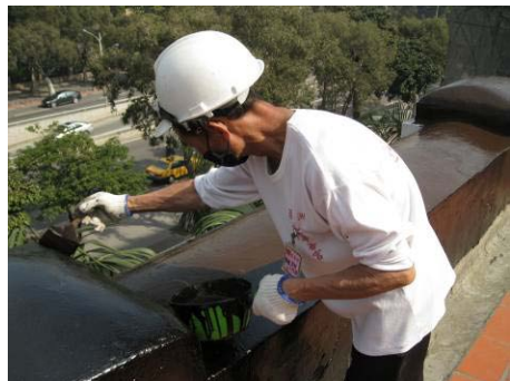
【照片 5-4-79】塗刷面層黑色橡膠瀝青(98.12.24)
