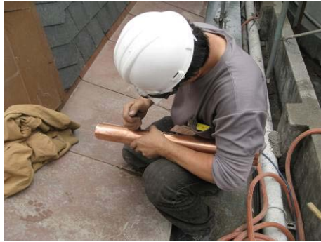
【照片 5-6-269】倒鈎處以彎鉗夾緊固定(98.12.25)
