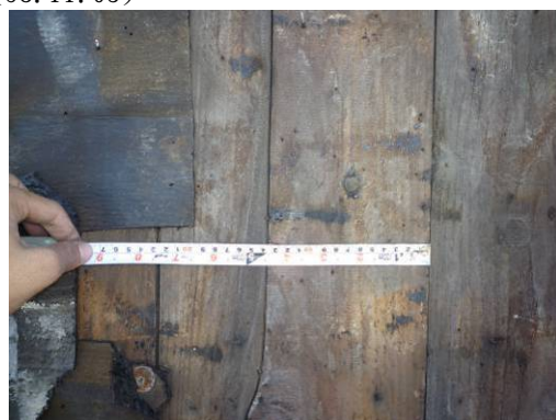
【照片 3-1-139】防水層 3 層:第 1 層油毛氈及表面之方錐形手工鐵釘(98.11.05)
