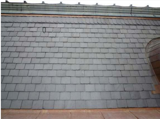
【照片 5-5-120】北翼 12 區抽換石板瓦位置
