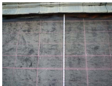
【照片 5-5-93】延續面石板瓦水平放樣線為 16 公分 (98.09.17)
