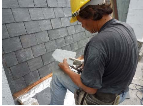
【照片 5-5-46】石板瓦打孔(98.09.28)
