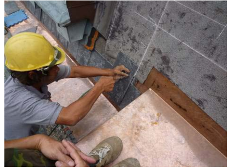
【照片 5-5-99】鋪設屋面瓦(98.10.09)
