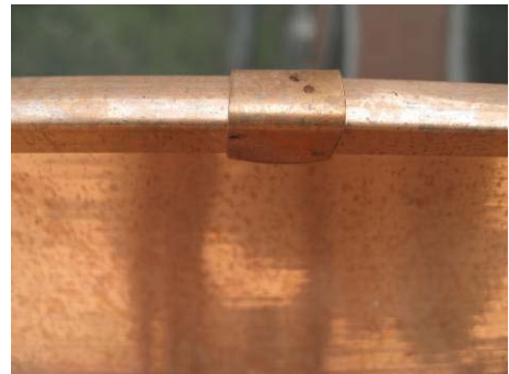
【照片 5-6-134】反摺固定天溝 (98. 12. 22)
