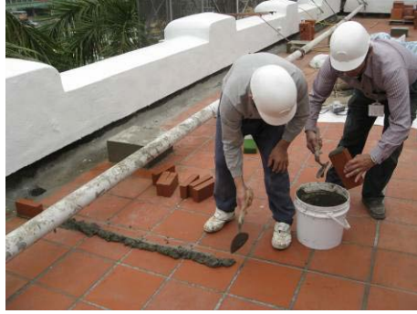
【照片 5-6-237】鋪設 1:3 水泥砂漿 (98. 12. 25)
