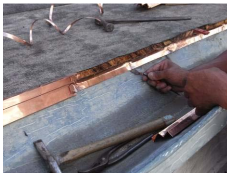
【照片 5-6-59】調整倒鈎角度(98.09.25)
