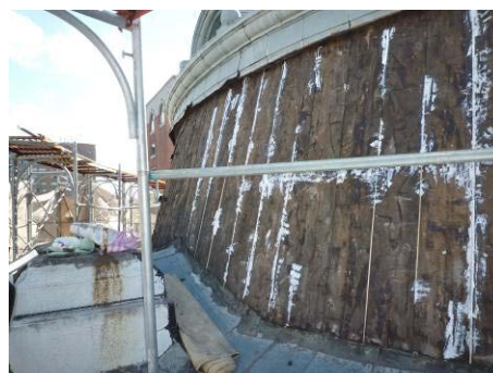
【照片 5-4-30】完成屋面板縫隙填補 (98.11.02)
