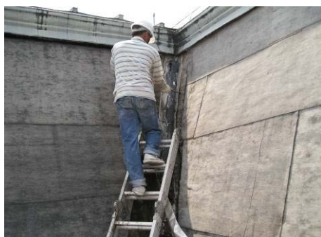
【照片 5-3-23】拆除不鏽鋼谷溝 (98.08.27)
