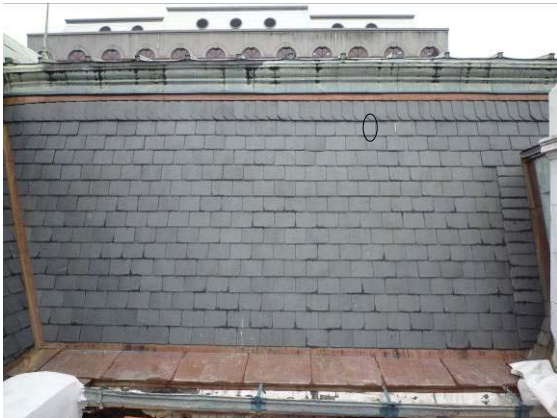
【照片 5-5-130】西翼 4 區抽換石板瓦位置
