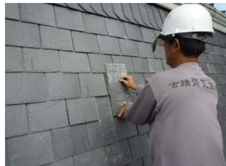
【照片 5-5-147】放樣石板瓦孔洞位置(98.11.27)
