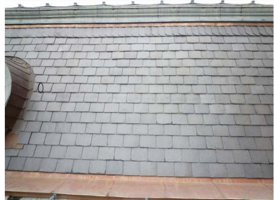
【照片 5-5-121】北翼 11 區抽換石板瓦位置
