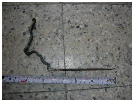
【照片 3-1-117】天溝固定器基座細部(後半部已腐朽)(98.09.30)
