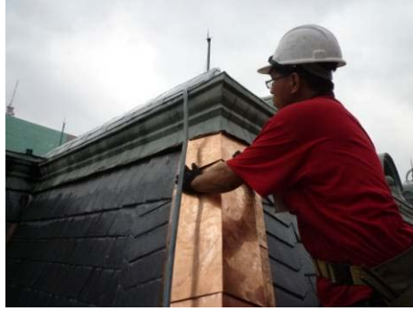
【照片 5-6-205】新舊接合處以平鉗夾緊固定(98.10.22)
