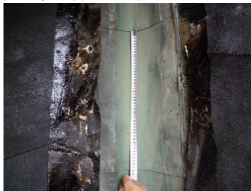
【照片 3-1-115】北翼 1、2 區轉折谷溝之第 1 層原始銅製圓形倒角谷溝(98.08.27)
