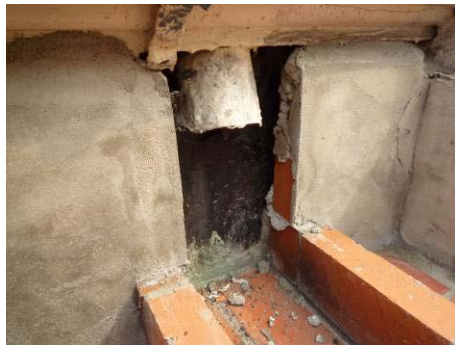
【照片 5-6-247】天溝導管與排水溝交接處細部(99. 03. 06)
