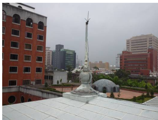
【照片 3-2-49】西翼塔樓後側避雷針(98.12.31)
