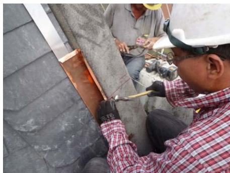
【照片 5-6-195】線板相扣後以吊子植入斜紋釘固定(98.10.22)
