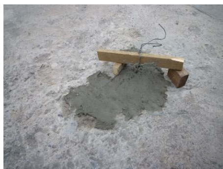
【相片 5-7-28】架設模板，澆灌水泥 砂漿(98.12.03)
