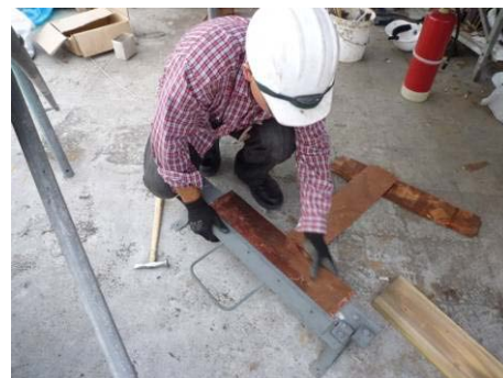
【照片 5-6-184】銅板彎摺成形 (98.10.22)
