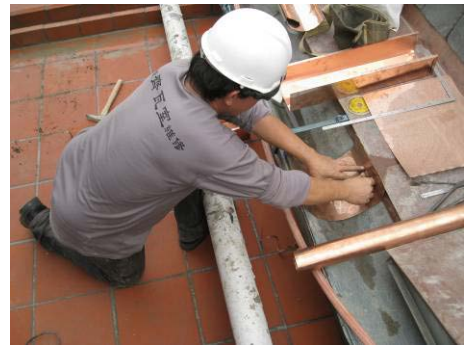
【照片 5-6-274】微調銅板弧度(98.12.25)
