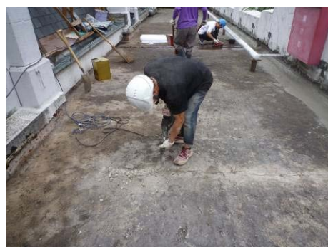
【相片 5-7-4】電鑽鑿孔(98.11.24)
