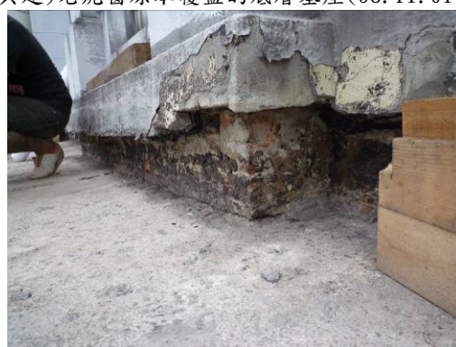
【照片 3-1-186】西翼 7.8.9.10 區平台(第一期興建)老虎窗原本覆蓋的底層基座(98.11.11)
