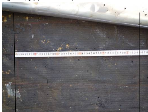
【照片 3-1-123】防水層 4 層：第 2 層油毛氈垂直放樣線間距 55 公分(98.08.19)
