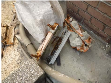
【照片 5-2-39】基座拆除後情形 (99.03.05)
