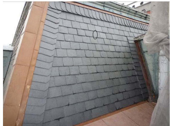
【照片 5-5-133】西翼 11 區抽換石板瓦位置
