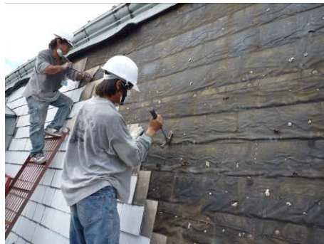
【照片 5-3-9】拆除屋面瓦 (98.08.03)
