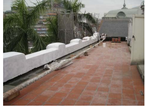
【照片 5-4-82】完成西翼平台女兒牆 RA 防水塗刷(98.12.24)
