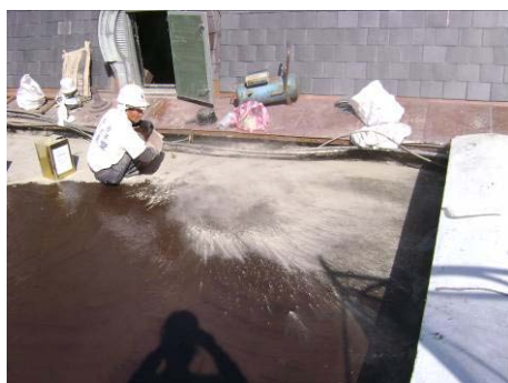
【照片 5-4-55】全面性鋪設:水泥粉平均拋灑至表面完全覆蓋(98.12.06)
