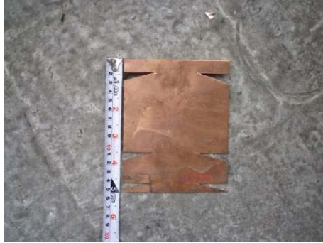
【照片 5-6-29】收邊銅板樣板 (98.09.28)
