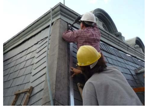
【照片 5-6-190】不鏽鋼板鑽孔以螺絲釘固定(98.10.22)
