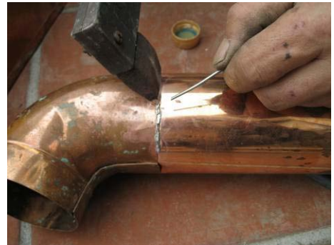
【照片 5-6-288】接合處以錫焊固定 (98.12.26)
