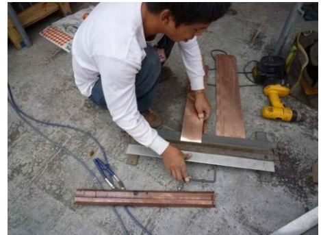
【照片 5-6-32】銅板彎摺成形 (98.10.09)
