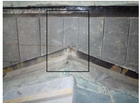
【照片 5-5-57】老虎窗中垂石板瓦收邊細部(98.09.30)
