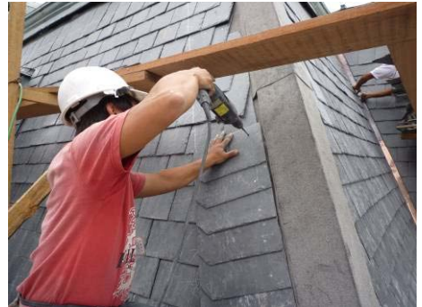
【照片 5-5-65】震動鑽孔機打孔 (98.09.30)
