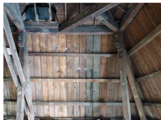
【照片 3-1-22】西翼 5 區屋面板(98.08.20)
