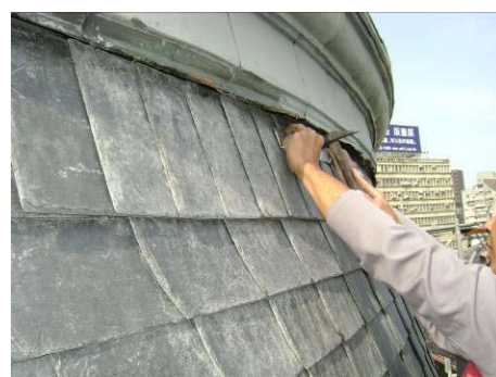
【相片 5-6-362】安裝不鏽鋼板 (98.12.04)
