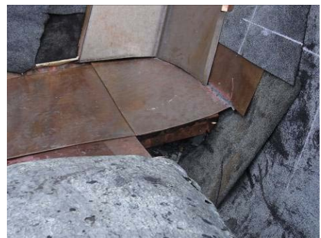
【相片 5-6-84】覆蓋谷溝後情形(98.10.02)
