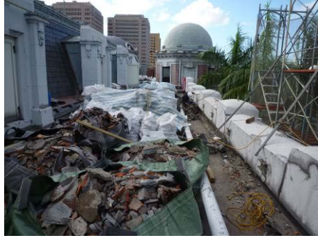
【照片 5-3-47】完成西翼平台鋪面 敲除(98.11.02)
