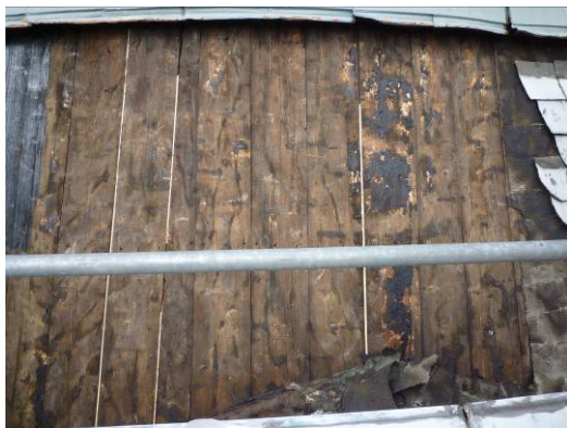
【照片 3-1-71】中央穹頂 7 區屋面板 (98. 11. 05)
