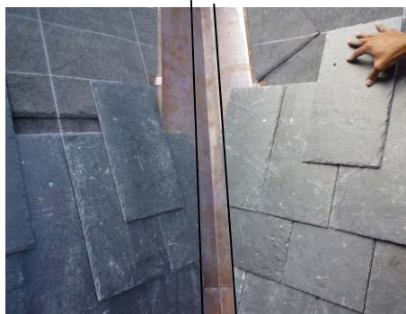
【照片 5-5-110】鋪設石板瓦至谷溝放 樣線(98.10.09)
