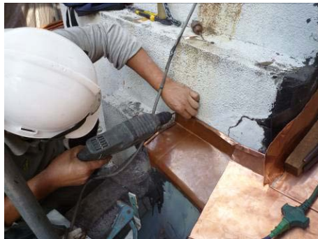
【相片 5-6-353】電鑽鑽孔(98.12.01)
