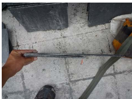
【照片 5-5-34】起手瓦與屋面瓦接合細部(98.09.28)
