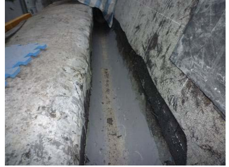
【照片 5-2-38】天溝塗抹防水膠 (98.09.28)
