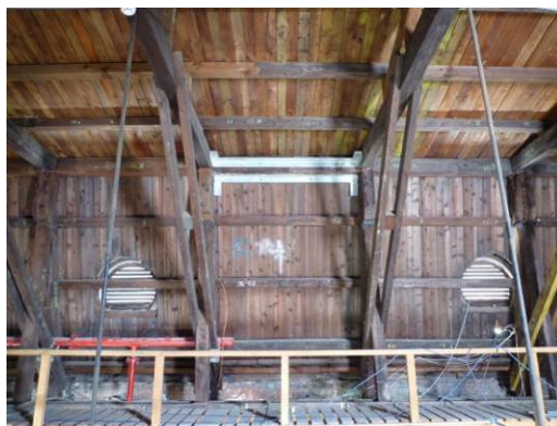
【照片 3-1-32】西翼 14 區屋面板(98.08.20)
