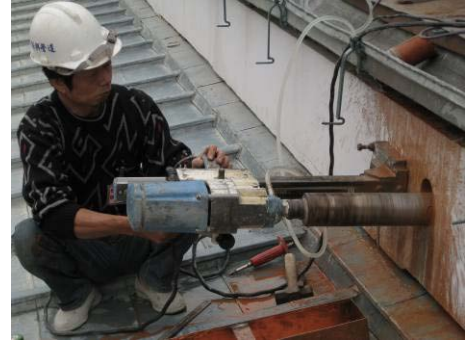
【照片 5-6-262】考量落水管斜率連續 沖孔兩次(98.12.25)
