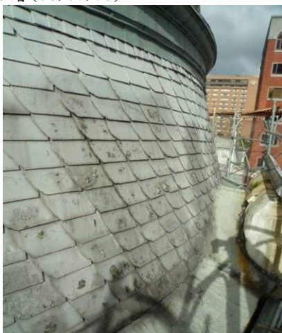
【照片 3-1-105】中央穹頂 7 區屋瓦拆除前為 14 層(98.07.13)
