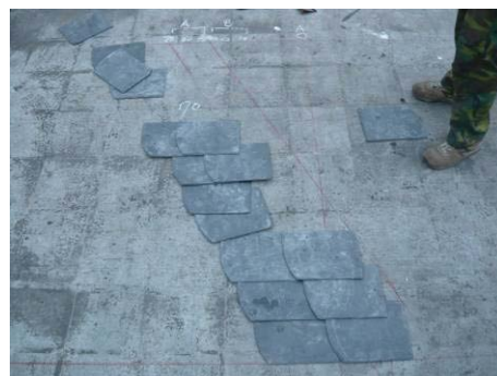
【照片 5-5-163】鋪設石板瓦,檢視石板瓦接合與重疊部位(97.11.07)
