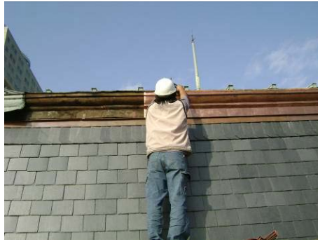
【照片 5-6-157】安裝簷板(98.12.03)
