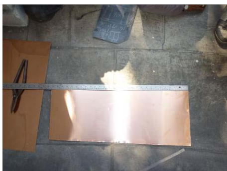
【相片 5-6-329】銅板配合屋面弧度裁切成梯形(98. 11. 27)
