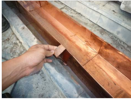
【照片 5-6-229】排水溝固定 (98.12.15)
