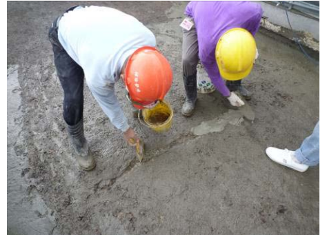
【相片 5-7-8】填補水泥膏(98.11.24)
