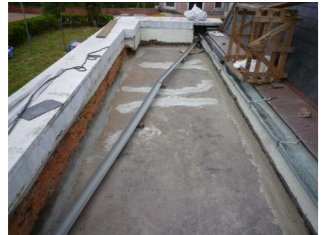
【照片 5-3-50】完成西翼平台鋪面 清理(98.11.11)
