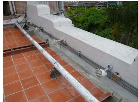
【照片 5-2-26】試開，檢視燈具是否正常運作(99.03.14)
