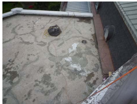
【相片 5-7-14】完成 M 形樓梯平台裂縫修補(98.12.01)
