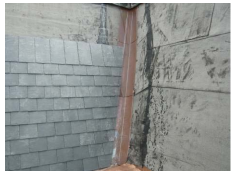
【相片 5-6-108】石板瓦鋪設時與谷溝接合情形(98.10.19)
