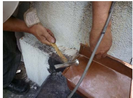
【相片 5-6-354】填塞膨脹螺絲植入斜 紋釘固定(98.12.01)
