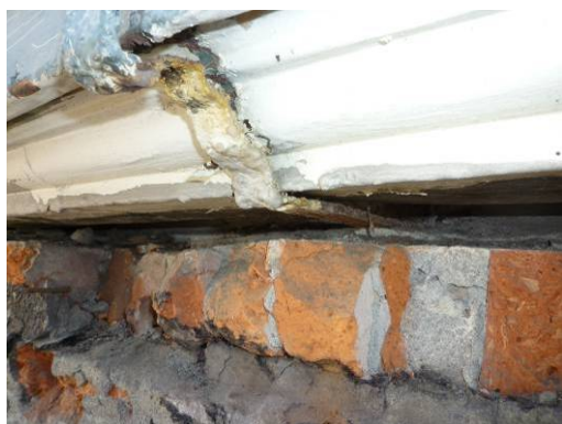
【照片 3-1-191】西翼 4 區平台(第二期興建)天溝固定器基座及後期砌築的紅磚基座(98.11.02)
