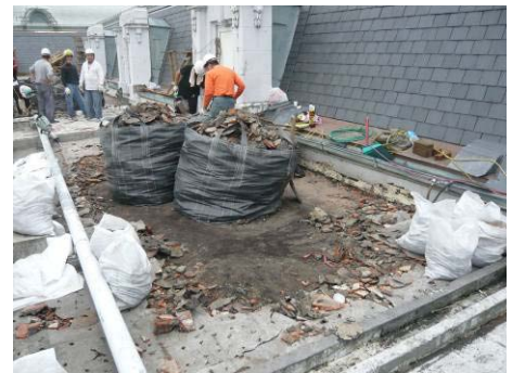
【照片 5-3-52】完成北翼平台鋪面 敲除(98.11.21)
