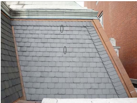
【照片 5-5-124】北翼 9 區抽換石板瓦位置
