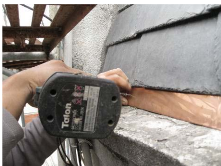
【照片 5-6-381】植入螺絲釘，固定於掛瓦條上(98.12.26)
