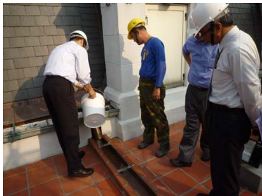
【照片 6-2-5】排水溝試水，檢視洩水情形(99. 03. 30)
