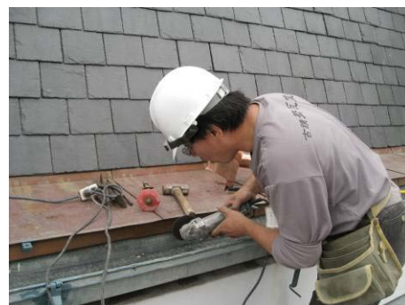
【照片 5-6-254】放樣天溝落水管位置 (98.12.25)
