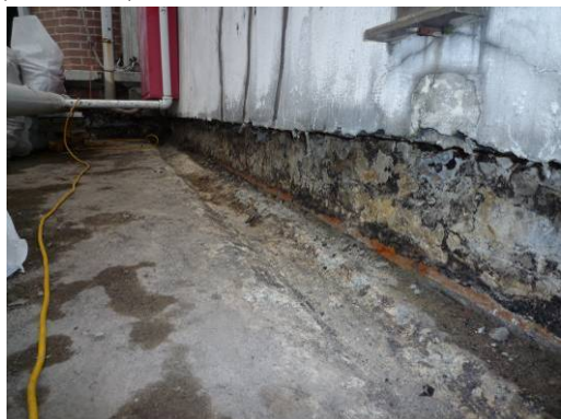
【照片 3-1-161】西翼 1. 2. 3. 4 區平台預留之水路 (98. 11. 01)
