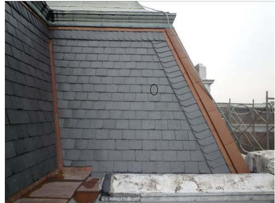
【照片 5-5-137】西翼 17 區抽換石板瓦位置
