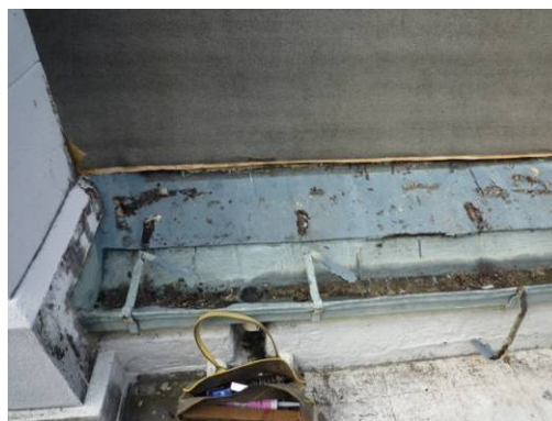
【照片 3-1-109】第 2 層不鏽鋼水切板與天溝(98.08.14)
