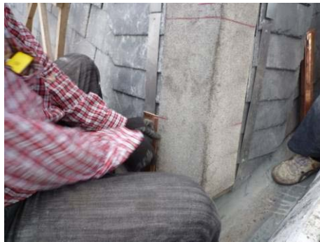
【照片 5-6-193】安裝線板(98.10.22)
