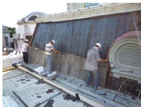
【照片 5-4-14】鋪設第 1 層防水毯 (98.08.25)
