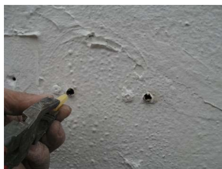
【照片 5-2-12】電鑽鑽孔並植入膨脹螺絲(98.12.26)
