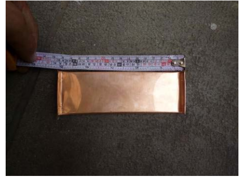
【照片 5-6-222】排水溝橫向補強構件(98. 12. 11)
