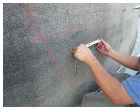
【照片 5-5-173】放樣上下緣石板瓦鋪設間距 (98.11.08)
