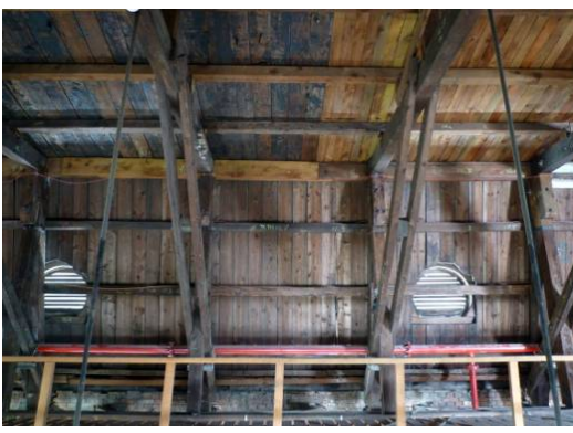
【照片 3-1-33】西翼 15 區屋面板(98.08.20)
