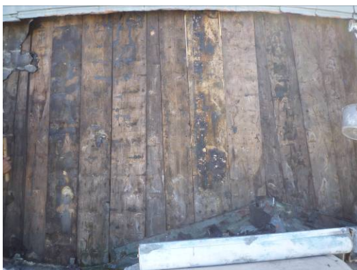
【照片 3-1-65】中央穹頂 1 區屋面板 (98.11.05)
