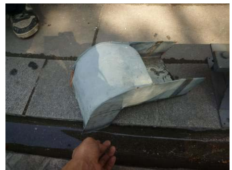
【照片 5-6-228】舊有排水溝細部(98. 12. 12)
