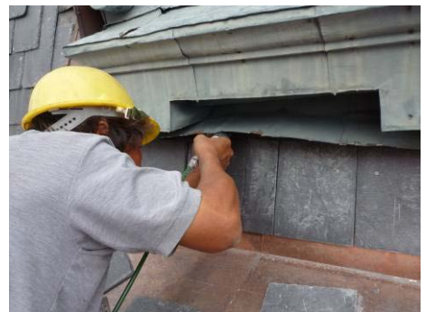
【照片 5-5-97】鋪設起手瓦(98.10.09)
