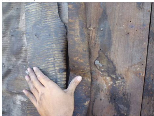
【照片 3-1-140】防水層 3 層:第 3、2、1 層油毛氈(98.11.05)
