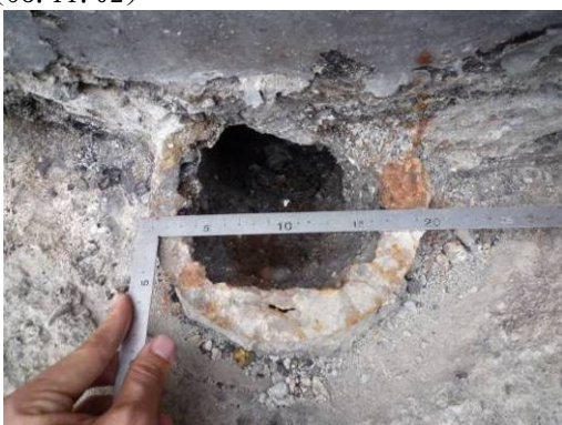
【照片 3-1-199】西翼 8 區平台落水管上之鑄鐵片(98.11.11)
