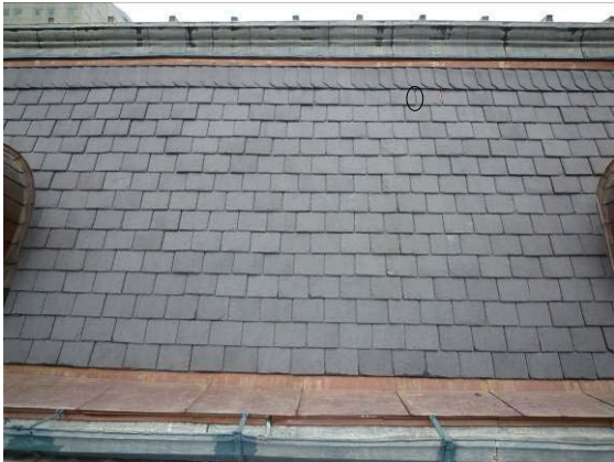
【照片 5-5-136】西翼 15 區抽換石板瓦位置
