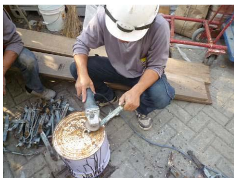
【照片 5-6-307】打磨表面殘漆與防水塗料(98.12.11)
