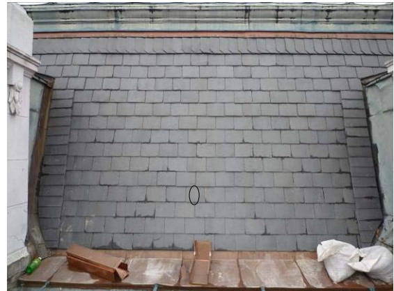
【照片 5-5-131】西翼 2 區抽換石板瓦位置
