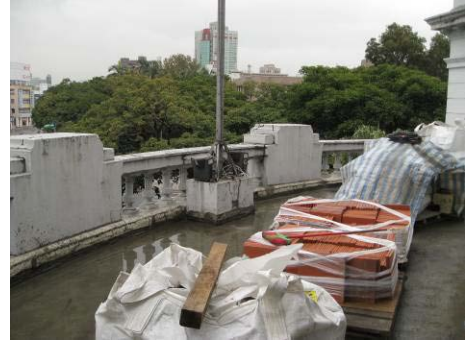
【照片 5-4-74】中央穹頂前側扇形平台試水(98.12.21)
