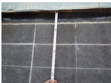
【照片 5-5-28】延續面石板瓦水平線為 15.5 公分 (98.09.21)
