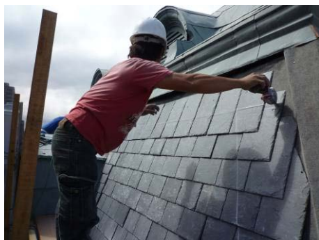
【照片 5-5-68】放樣屋脊瓦鋪設位置 (98.09.30)
