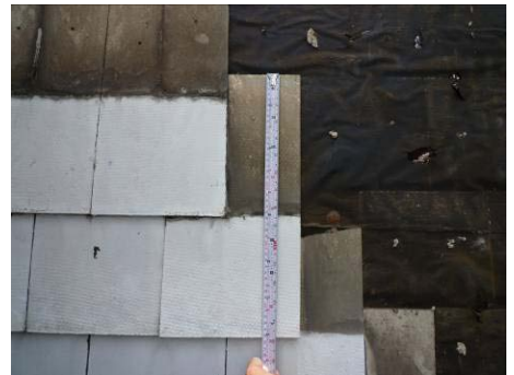
【照片 5-3-10】屋面瓦搭接尺寸 (98.08.03)
