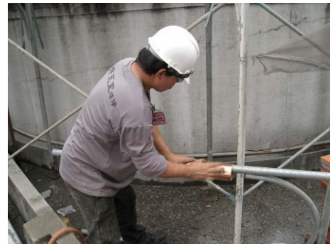
【照片 5-6-268】配合鷹架將銅板加工 為圓管(98.12.25)
