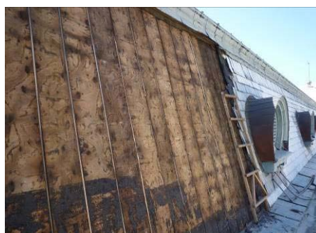
【照片 5-4-5】完成細木料修補 (98.08.28)
