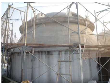
【照片 5-5-198】大碉堡石板瓦鋪設前樣貌(98.12.10)
