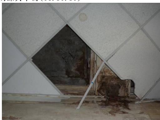
【照片 3-1-153】M 形樓梯平台之混凝土樑(98.10.10)
