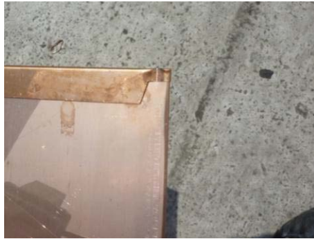
【相片 5-6-95】梯形收邊切口彎摺後細部(98.08.26)
