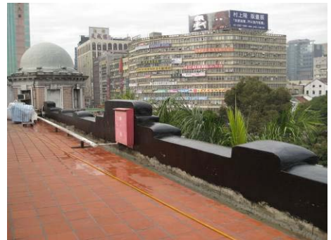
【照片 5-4-80】完成面層黑色橡膠瀝青塗刷 (98.12.24)
