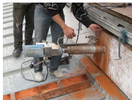
【照片 5-6-260】量測磚牆至天溝深度 (98.12.25)
