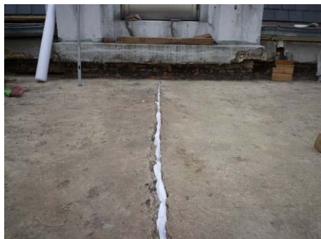
【相片 5-7-21】完成裂縫填塞 (98.11.11)
