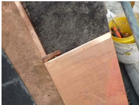
【照片 5-6-201】轉折銅板與線板接合 細部(98.10.22)
