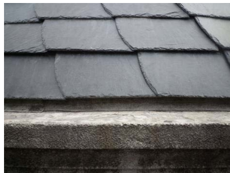
【照片 5-5-210】鋪設屋面瓦後，下緣 預留水切板位置(98. 12. 17)
