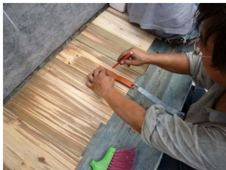
【照片 5-6-41】放樣固定器基座位置 (98.09.23)
