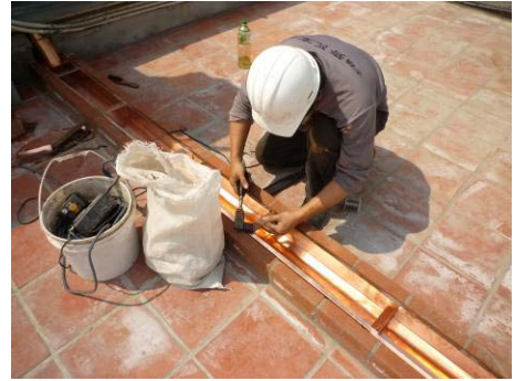
【照片 5-6-246】補強構件錫焊固定 (98. 12. 26)
