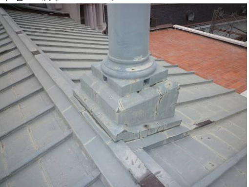
【照片 3-2-62】西翼翼樓煙囪基座 (98. 12. 31)
