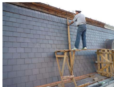
【照片 5-6-152】調整襯板高度(98.11.25)
