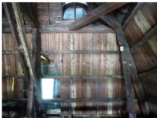
【照片 3-1-36】西翼 18 區屋面板(98.08.20)
