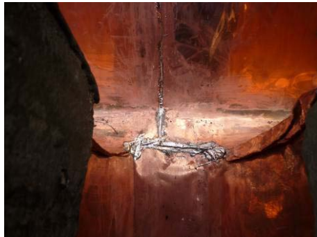
【照片 5-6-123】銅板錫焊完成細部 (98.10.25)
