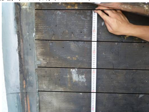
【照片 3-1-122】防水層 4 層：第 2 層油毛氈水平放樣線間距 14 公分(98.08.19)
