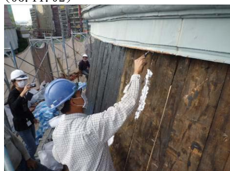
【照片 5-4-28】塗刷修補劑(98.11.02)
