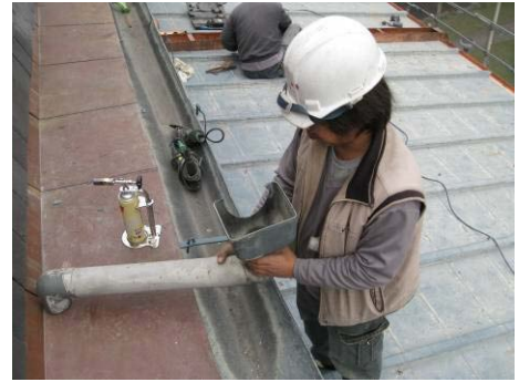
【照片 5-6-138】檢修塑膠落水管 (98. 12. 22)
