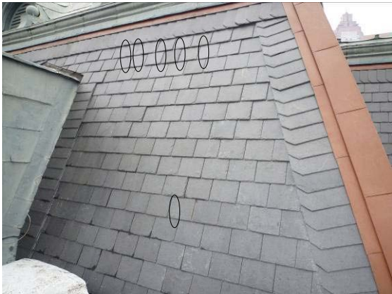
【照片 5-5-138】西翼 19 區抽換石板瓦位置
