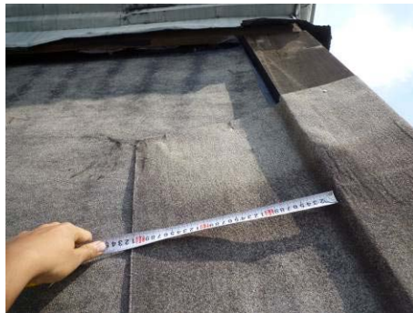
【照片 5-4-23】斜脊施作之防水毯覆蓋兩側防水毯約 30 公分(98.08.25)
