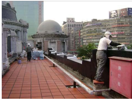
【照片 5-4-85】北翼平台女兒牆塗刷底層白色橡膠瀝青(98.12.24)
