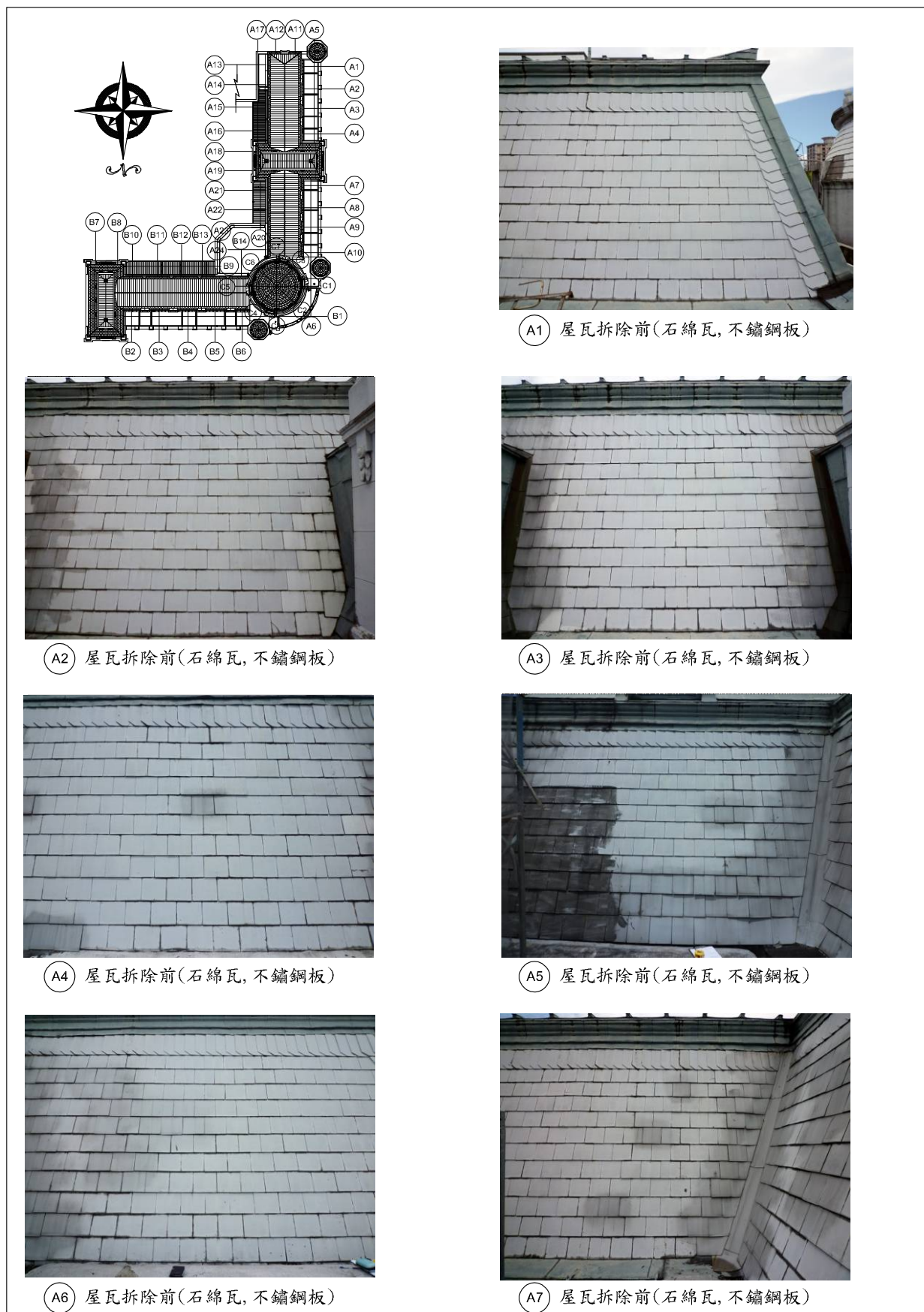
【圖 3-1-10】監察院屋瓦拆除前材料記錄
