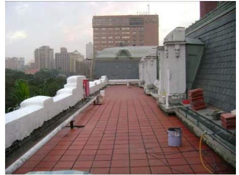
【照片 5-4-86】完成北翼平台女兒牆 RA 防水塗刷(98.12.24)
