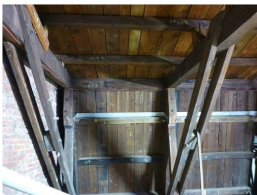
【照片 3-1-49】北翼 6 區屋面板(98.09.17)
