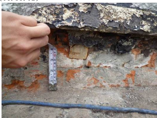
【照片 3-1-191】西翼 4 區平台(第二期興建)天溝固定器基座及後期砌築的紅磚基座(98.11.02)
