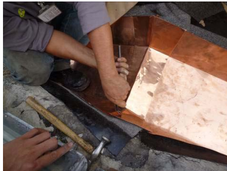
【相片 5-6-351】銅板倒鈎處以彎鉗夾 緊(98.11.27)
