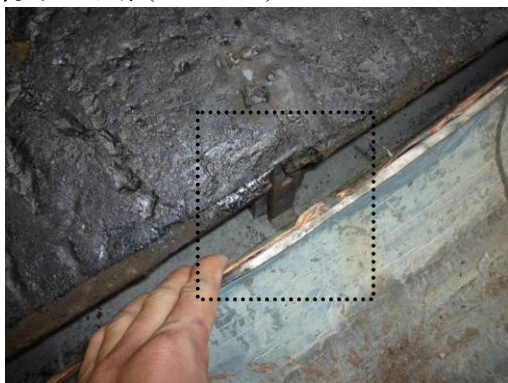
【照片 3-1-112】天溝固定器基座固定形式(98.09.21)
