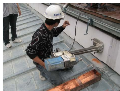
【照片 5-6-258】安裝沖孔儀器 (98.12.25)
