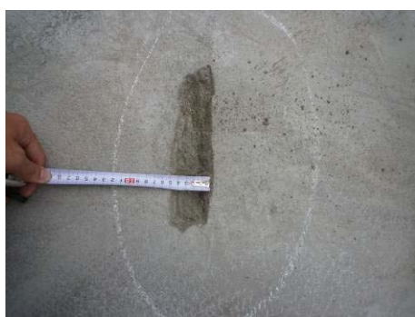
【照片 5-4-43】縫隙寬度約 3 公分(98.11.26)
