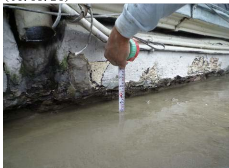
【相片 5-7-35】量測水泥砂漿高度，內側約 9 公分(98.11.24)
