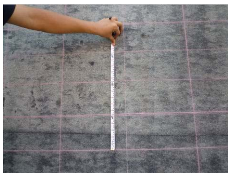
【照片 5-5-92】獨立區域石板瓦水平放樣線為 15.8 公分 (98.09.17)
