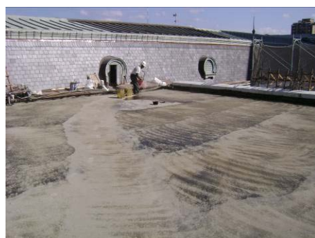
【照片 5-4-56】全面性鋪設:水泥粉拋灑完成,靜置等待固化(98.12.06)
