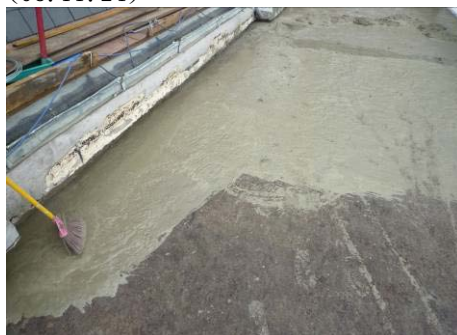
【相片 5-7-33】平台表面塗刷水泥水 (98.11.24)
