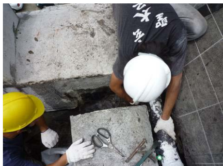
【照片 5-2-31】抬升消防管(98.09.28)
