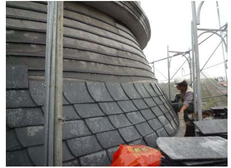
【照片 5-5-207】鋪設屋面瓦 (98. 12. 17)
