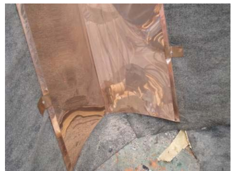
【相片 5-6-100】銅板兩側以吊子相扣並植入斜紋釘固定於屋面板(98.08.27)
