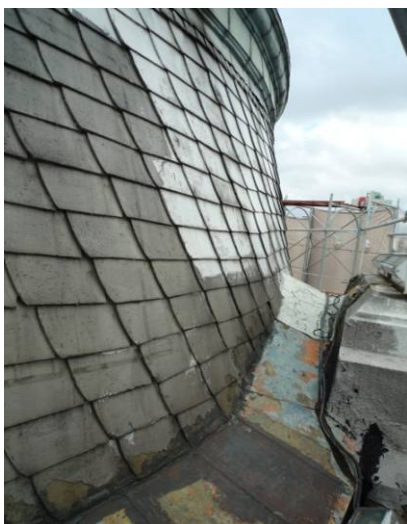
【照片 3-1-103】中央穹頂 5 區屋瓦拆除前為 14、15 層(98.07.13)
