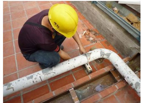
【照片 5-2-42】1 安裝固定(99.03.05)
