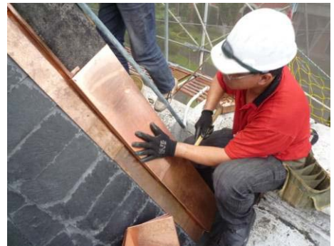
【照片 5-6-200】銅板上下接合後以拍 打木輕拍緊密(98.10.22)
