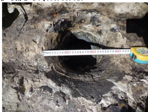
【照片 3-1-198】排水溝孔徑 22 公分(98.11.01)
