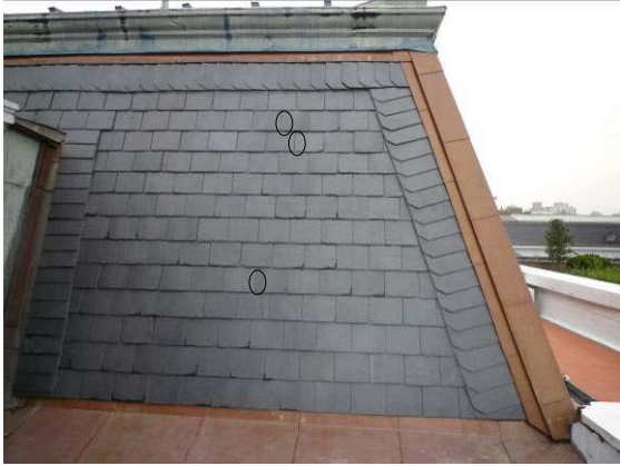
【照片 5-5-134】西翼 12 區抽換石板瓦位置
