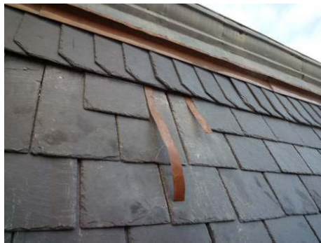
【照片 5-5-158】固定銅板完成 (98. 11. 25)
