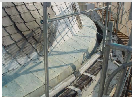
【照片 5-2-2】中央穹頂拆除燈具前 (98.06.08)
