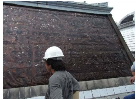
【照片 5-3-18】完成油毛氈拆除 (98.08.04)
