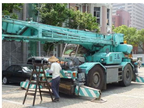
【相片 5-3-65】吊車進場(98.08.15)
