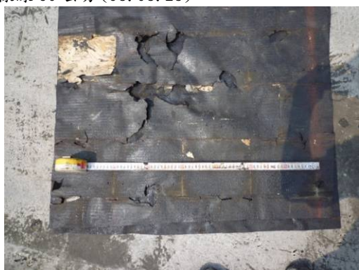
【照片 3-1-128】防水層 3 層:第 3 層油毛氈放樣線(98.08.28)
