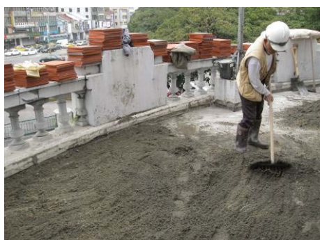
【相片 5-7-55】鋪設 1:3 水泥砂漿(98.12.26)
