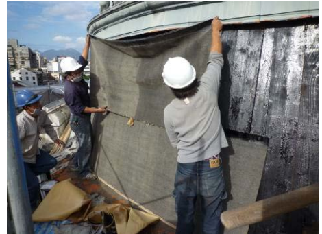
【照片 5-4-36】鋪設上層防水毯(98. 11. 02)
