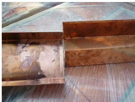
【照片 5-6-219】排水溝上下倒鈎形式 (98. 12. 11)
