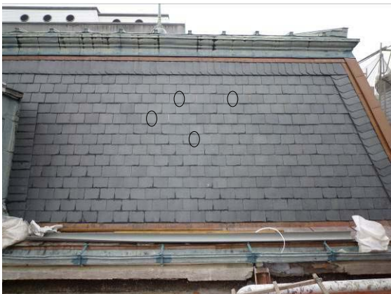
【照片 5-5-132】西翼 1 區抽換石板瓦位置
