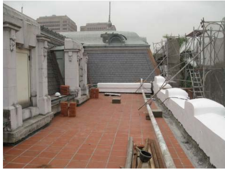
【照片 5-4-83】完成西翼平台女兒牆 RA 防水塗刷(98.12.24)
