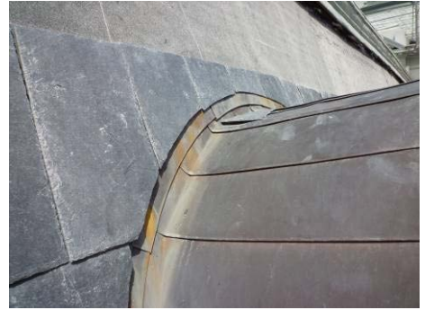
【照片 5-5-107】靠近牛眼窗之石板瓦 鋪設細部(98.10.09)
