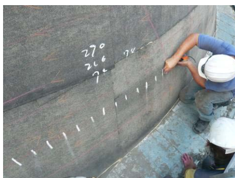
【照片 5-5-174】放樣上下緣石板瓦鋪設間距 (98.11.08)
