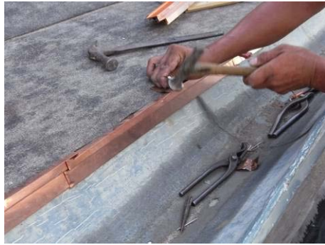
【照片 5-6-61】吊子反扣植入斜紋釘固定(98.09.25)
