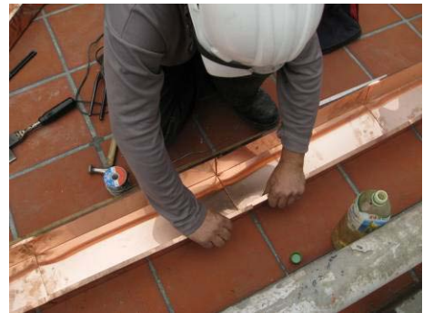
【照片 5-6-242】安裝排水溝 (98. 12. 26)
