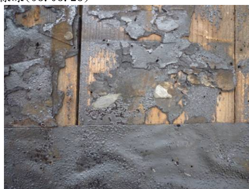
【照片 3-1-131】防水層 3 層:第 1 層油毛氈表面殘留之石板碎片(98.08.28)
