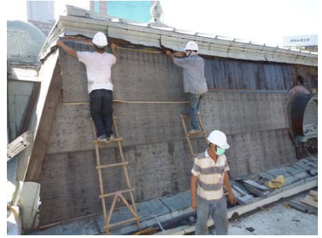
【照片 5-4-18】鋪設第 3 層防水毯 (98.08.25)
