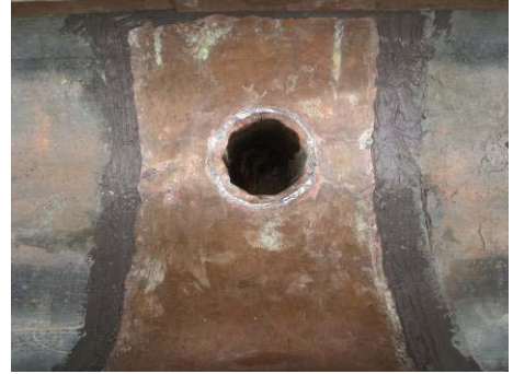
【照片 5-6-286】天溝新舊交接處以矽利康修補(98.12.26)
