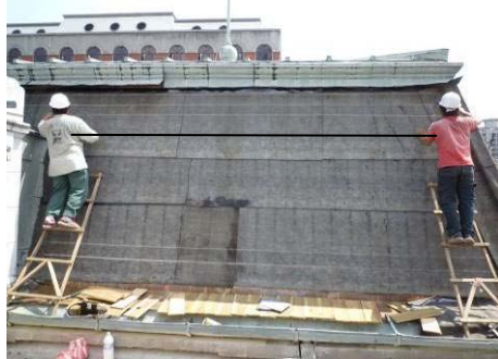
【照片 5-5-16】彈記最上層屋面瓦水平基準線(98.09.21)
