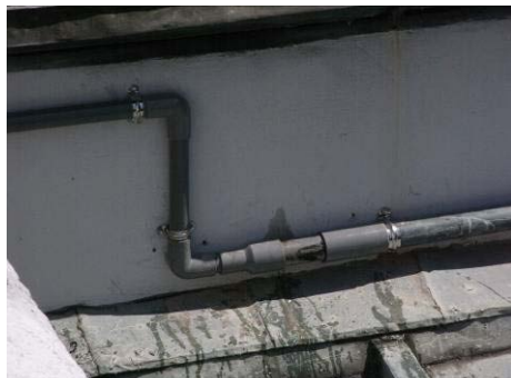
【照片 5-2-29】北翼後側天溝完成給水管遷移情形(98.09.07)
