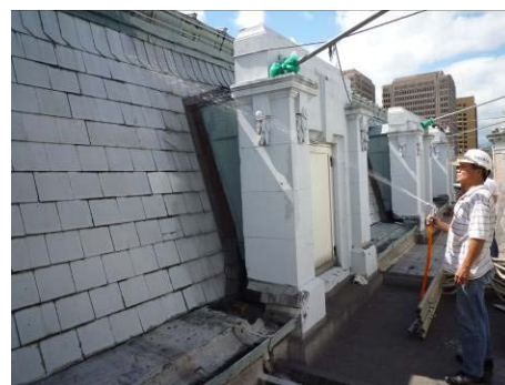
【照片 5-3-2】屋面瓦拆除前灑水(98.08.03)
