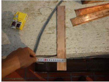
【照片 5-6-245】補強構件兩端反摺 0.5 公分，增加強度(98. 12. 26)
