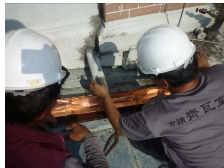
【照片 5-6-302】安裝排水管，矽利康填縫(98.12.15)
