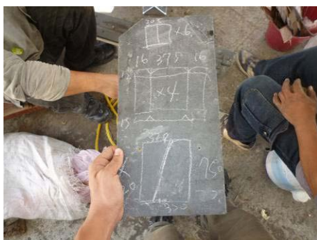
【相片 5-6-327】量測現場尺寸製作樣板(98. 11. 27)
