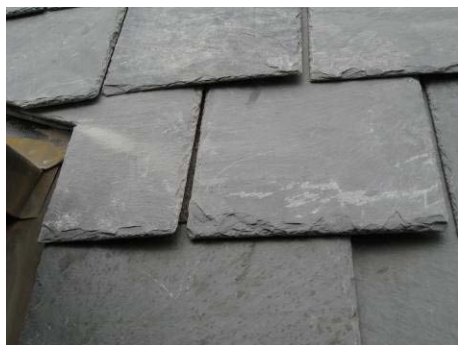
【照片 5-5-52】石板瓦交接處理細部(98.09.30)
