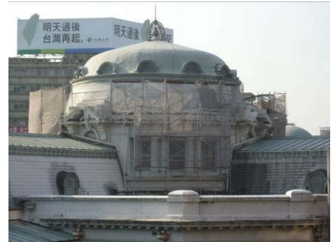
【照片 5-1-16】完成中央穹頂鋼管鷹架搭設(98.05.30)
