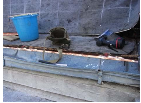
【照片 5-6-54】完成不鏽鋼天溝倒鈎安裝(98.09.25)
