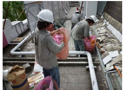
【照片 5-3-12】反套 PE 編織袋與垃圾袋 (98.08.03)
