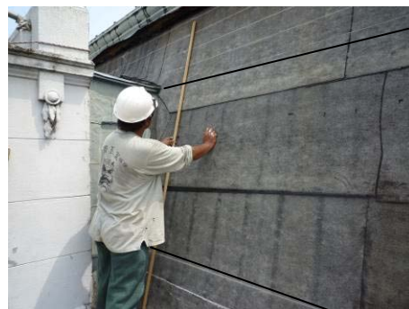
【照片 5-5-19】依基準線區間放樣水平放樣線(98.09.21)
