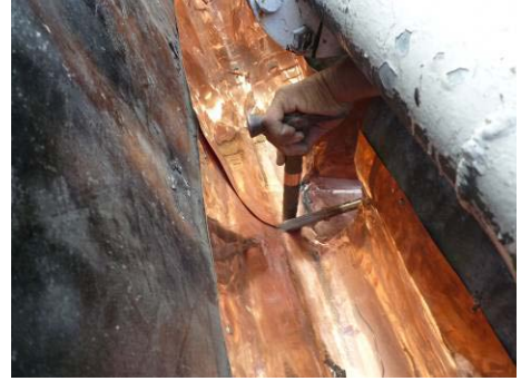
【照片 5-6-122】錫焊填縫(98.10.25)
