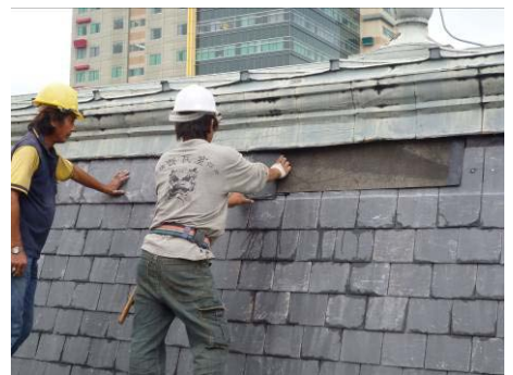
【照片 5-5-113】鋪設屋脊瓦 (98.10.09)
