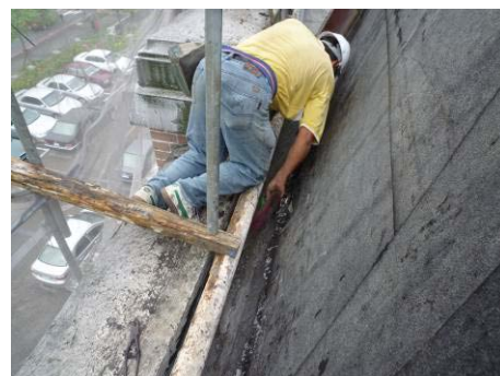
【照片 5-6-110】清理溝底灰塵及細小石塊 (98.10.25)
