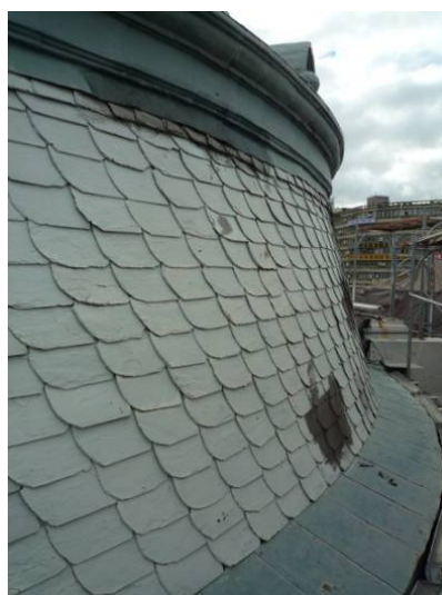
【照片 3-1-102】中央穹頂 4 區屋瓦拆除前為 14、15 層(98.07.13)
