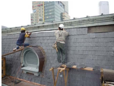
【照片 5-6-167】固定不鏽鋼板 (98.10.14)
