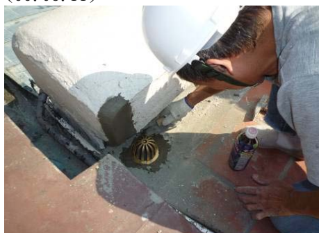
【相片 5-7-73】安裝落水頭(99.03.11)
