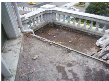
【照片 5-3-57】完成中央穹頂左側平台鋪面敲除(98. 12. 20)
