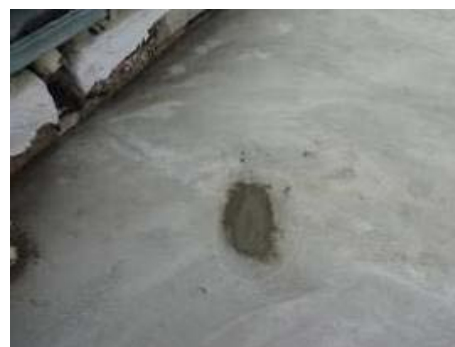
【照片 5-4-46】修補完成的隙縫靜置約 1 天等待乾固(98.11.26)
