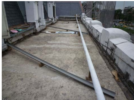
【相片 5-7-11】完成西翼平台裂縫修補 (98.11.11)
