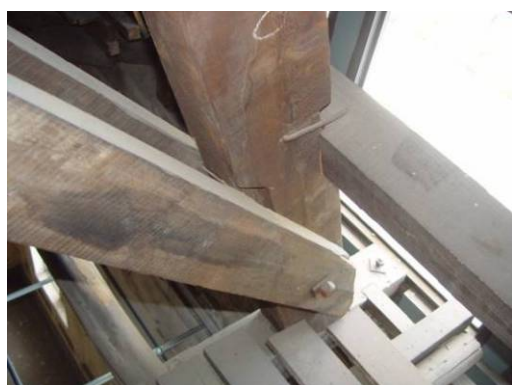
【照片 3-1-5】構件接合螺栓及螞蝗釘(98.09.19)
