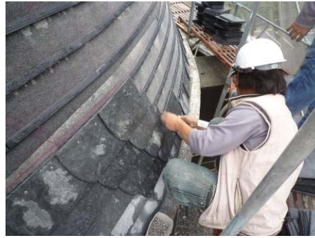
【照片 5-5-206】鋪設屋面瓦 (98. 12. 17)
