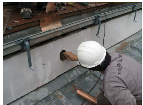
【照片 5-6-282】試安裝，檢視相對位置(98. 12. 26)
