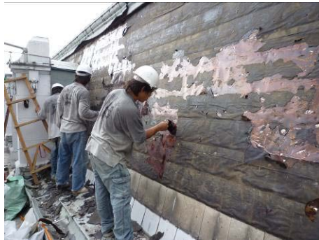
【照片 5-3-17】拆除油毛氈 (98.08.04)
