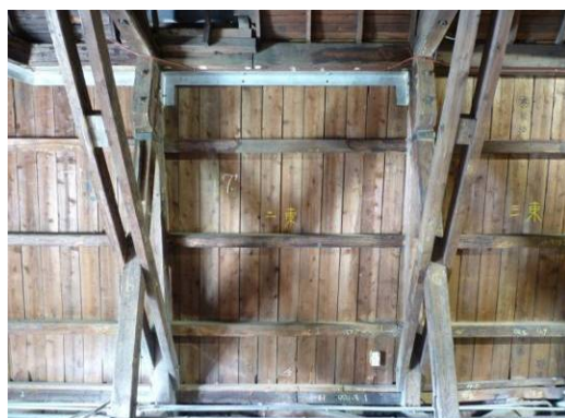
【照片 3-1-62】北翼 15 區屋面板(98.09.17)
