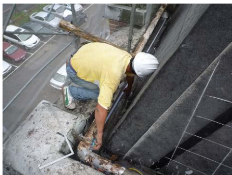
【照片 5-6-111】量測天溝尺寸 (98.10.25)
