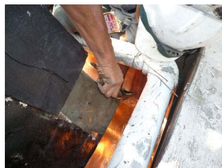
【照片 5-6-120】夾緊銅板轉折處倒鈎 (98.10.25)
