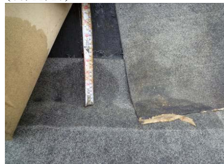
【相片 5-6-324】防水毯延伸至屋面 12 公分(98.11.24)
