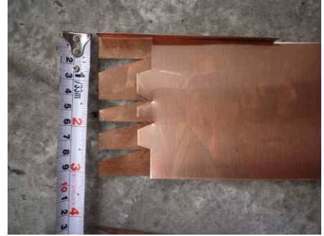
【照片 5-6-30】收邊切口細部 (98.10.09)
