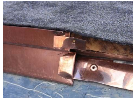
【照片 5-6-58】收邊銅板與天溝固定後細部(98.09.25)
