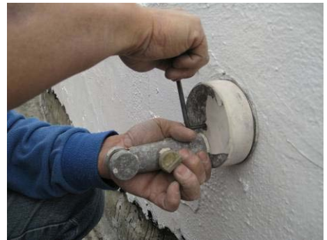
【照片 5-2-16】安裝基座(98.12.26)
