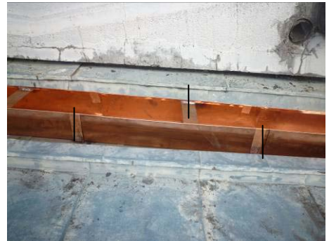
【照片 5-6-232】固定用銅板與橫向補 強構件以交丁方式安裝(98.12.15)
