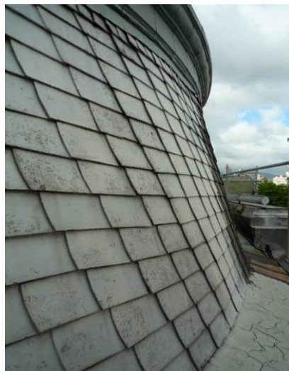
【照片 3-1-104】中央穹頂 6 區屋瓦拆除前為 14 層(98.07.13)
