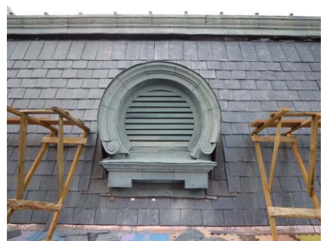
【照片 5-5-111】完成屋面瓦鋪設 (98.10.09)
