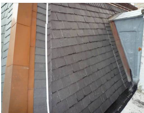
【照片 3-2-59】北翼塔樓前後側避雷針導線 包覆塑膠管(98. 12. 31)
