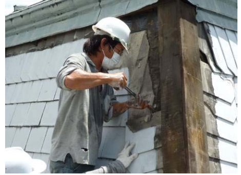
【照片 5-3-8】拆除斜脊瓦 (98.08.03)
