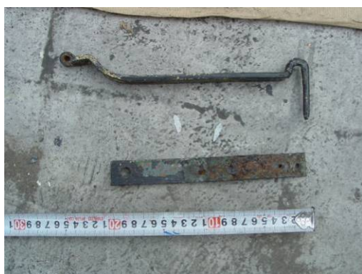
【照片 3-1-116】天溝固定器細部(98.09.30)
