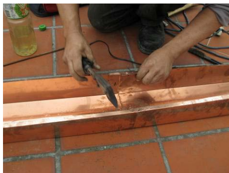
【照片 5-6-243】交接處以錫焊補強 (98. 12. 26)
