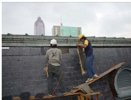
【照片 5-5-112】鋪設自黏式防水毯 (98.10.09)
