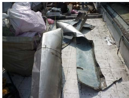
【照片 5-3-30】不鏽鋼水切板 (98.08.14)
