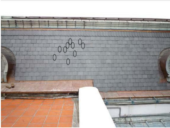
【照片 5-5-118】北翼 13 區抽換石板瓦位置
