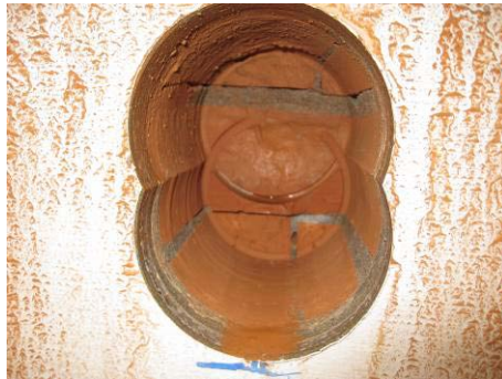
【照片 5-6-263】水平沖孔完成 (98.12.25)
