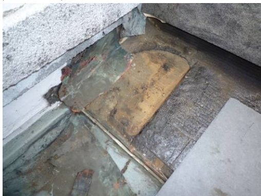
【照片 3-1-114】第 1 層原始銅製水切板拆除後底層之防水層與屋面板(98.09.21)
