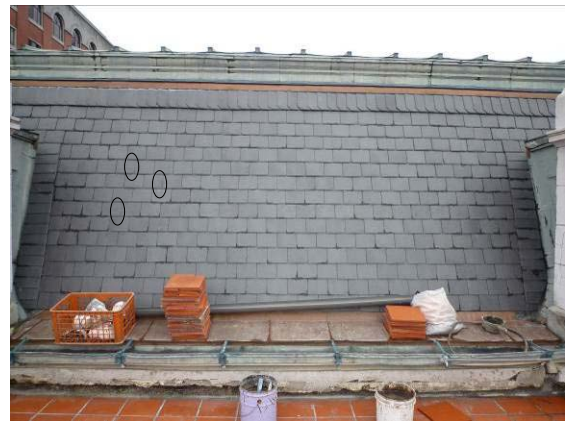
【照片 5-5-115】北翼 5 區抽換石板瓦位置
