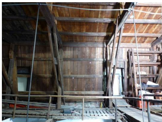
【照片 3-1-27】西翼 9 區屋面板(98.08.20)
