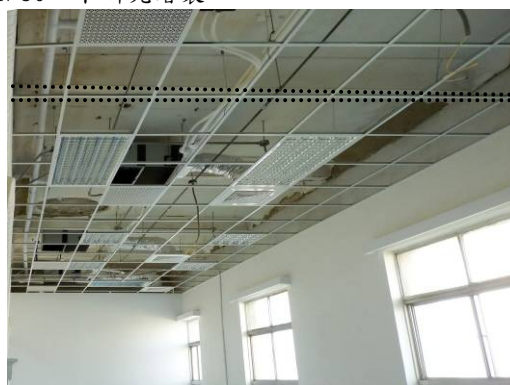
【照片 3-1-150】室內輕鋼架與工字形鋼樑比對之相對斜率(98.11.01)
