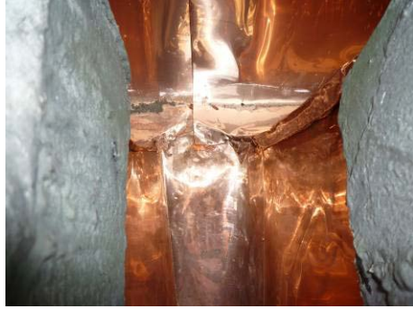
【照片 5-6-121】銅板接合處細部 (98.10.25)
