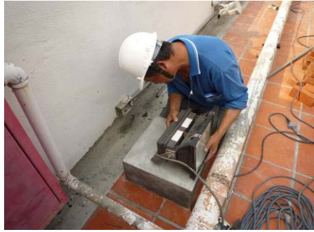
【照片 5-2-21】安裝照明燈(99.03.12)
