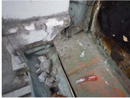
【照片 5-6-37】敲除老虎窗水泥裝飾 (98.09.23)
