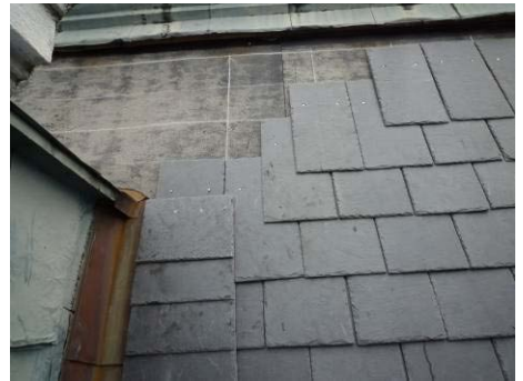
【照片 5-5-49】完成收邊石板瓦鋪設(98.09.28)
