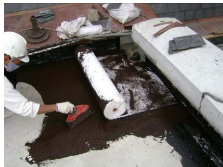
【照片 5-4-50】全面性鋪設:塗刷底層橡膠瀝青(98.12.05)
