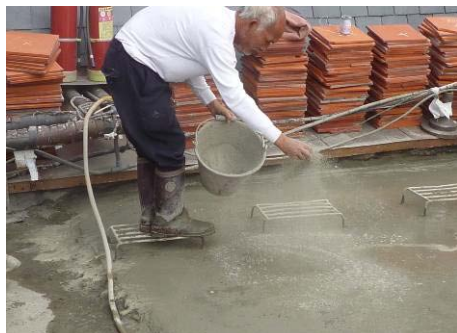
【相片 5-7-45】水泥粉平均拋灑至砂漿表面濕潤但不積水(98.12.23)
