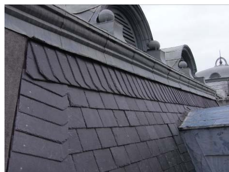
【照片 5-5-73】完成屋脊瓦鋪設(98.09.30)
