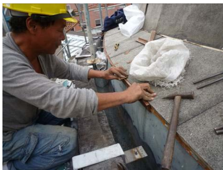
【相片 5-6-339】收邊銅板以吊子加釘固定於杉木板上(98. 11. 24)
