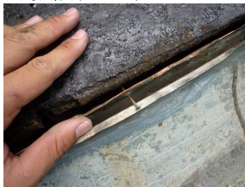
【照片 3-1-113】第 2 層不鏽鋼天溝與第 1 層原始銅製天溝(98.09.21)
