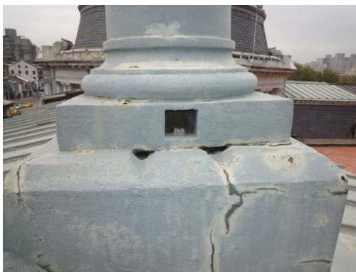
【照片 3-2-63】西翼翼樓煙囪以螺栓固定於 基座上(98. 12. 31)
