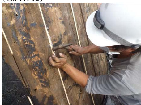
【照片 5-4-27】木料塗抹樹脂後以銅釘固定(98.11.02)
