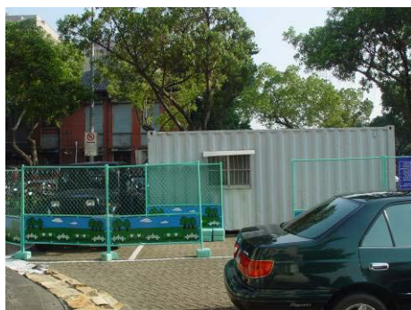
【照片 5-1-1】工務所進場(98.05.30)
