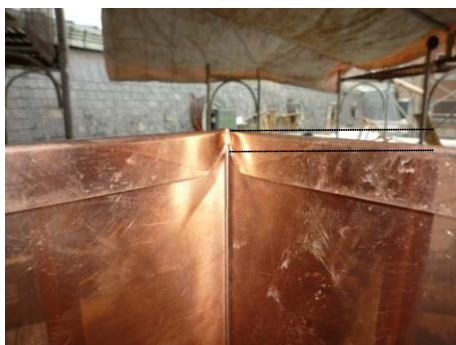
【照片 5-6-187】三角形收邊切口反摺 後細部(倒鉤反摺 1.5 公分，切口為 1.2 公分)(98.10.22)
