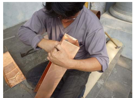
【照片 5-6-220】調整倒鈎縫隙 (98. 12. 11)
