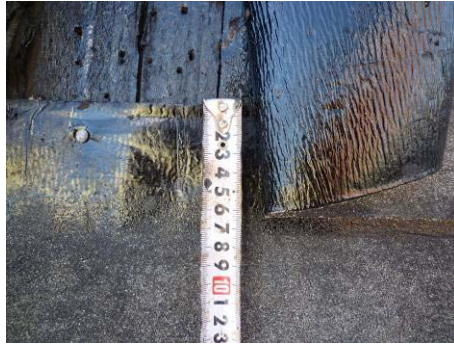
【照片 5-4-17】防水毯上下層搭接 6.5 公分(98.08.25)
