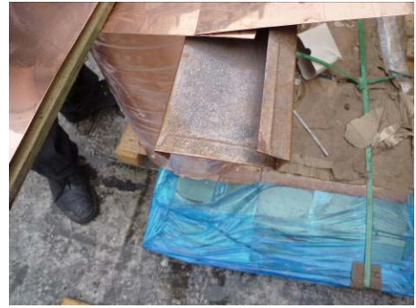
【照片 5-6-166】線板倒鈎細部 (98.10.14)
