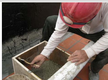
【相片 5-7-64】模板周邊塗刷汽油 (98. 12. 24)
