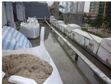
【照片 5-4-58】西翼 7、8、9、10 區平台試水(98. 11. 30)
