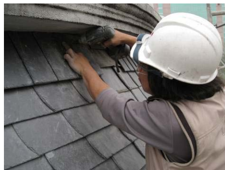
【照片 5-5-212】鋪設屋脊瓦 (98. 12. 20)
