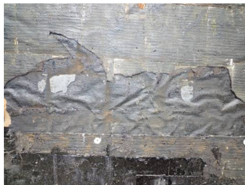
【照片 3-1-127】防水層 2 層:第 1 層油毛氈表面殘留之石板碎片(98.08.25)
