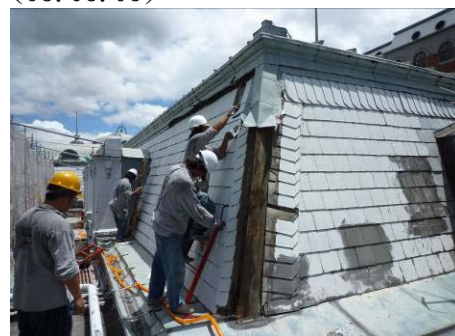
【照片 5-3-4】拆除斜脊瓦(98.08.03)
