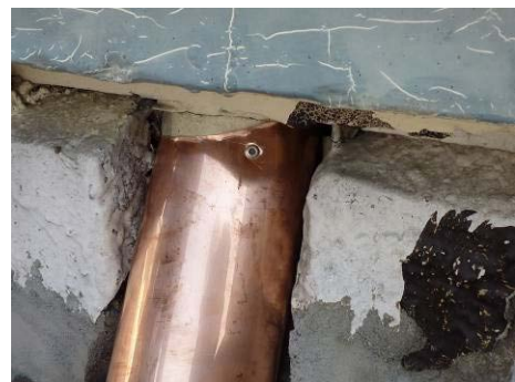
【照片 5-6-252】導管與天溝接合細部 (99. 03. 06)
