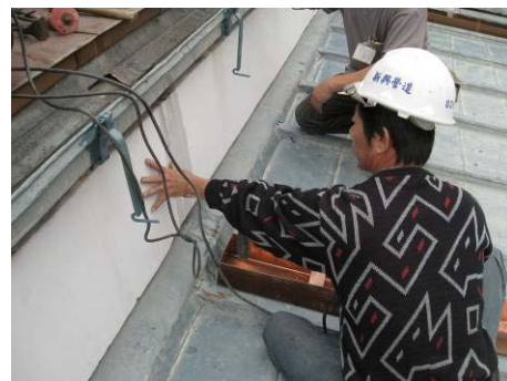
【照片 5-6-256】檢視天溝開口位置 (98.12.25)
