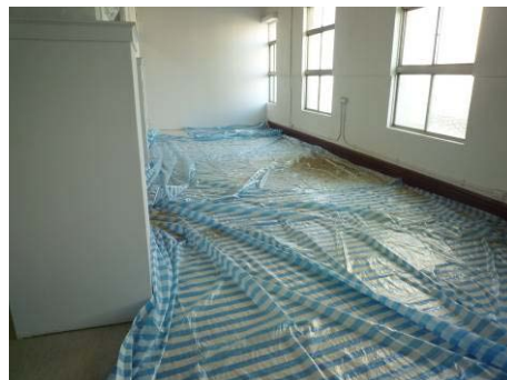
【照片 5-3-32】室內相對位置鋪設帆布保護(98.10.30)
