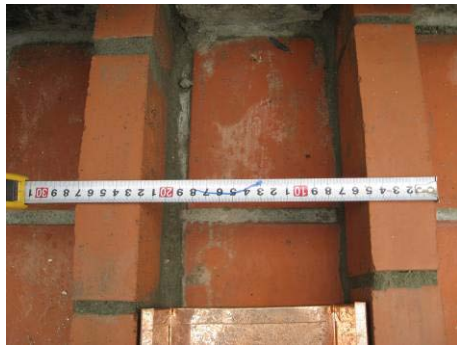
【照片 5-6-241】量測保護基座寬度 (98. 12. 26)
