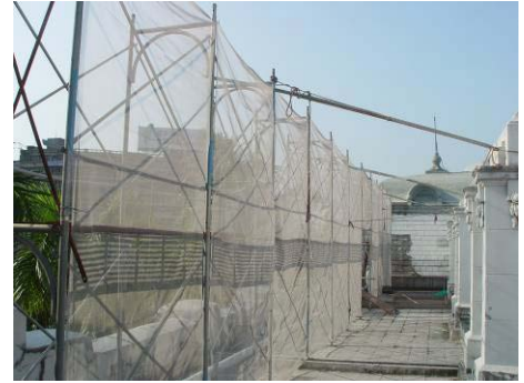
【照片 5-1-14】完成西翼鋼管鷹架搭設(98.05.30)
