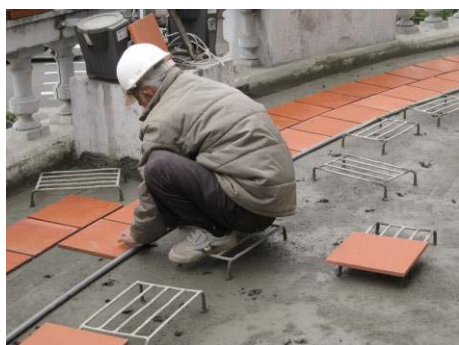
【相片 5-7-59】依弧度鋪設板磚(98.12.26)
