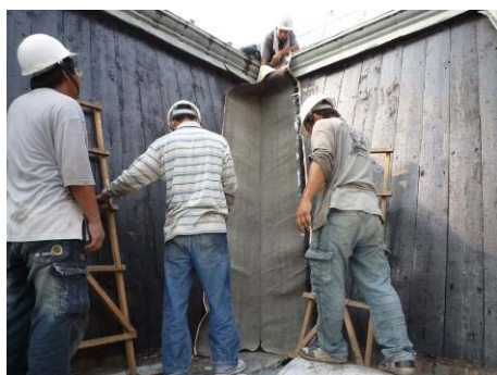
【照片 5-4-11】屋面轉折處谷溝鋪設 自黏式防水毯(98.08.27)
