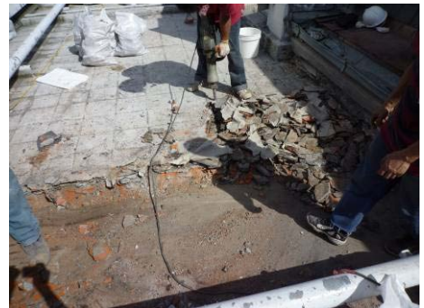
【照片 5-3-44】第 13 層混凝土樓板 (98.10.31)
