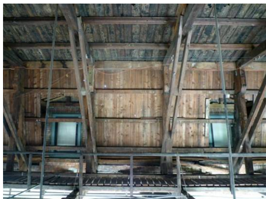
【照片 3-1-19】西翼 3 區屋面板(98.08.20)
