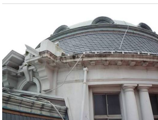
【照片 3-2-41】中央穹頂避雷針導線 (98. 12. 31)
