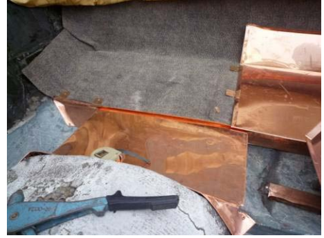
【相片 5-6-70】安裝轉折處水切板 (98.10.17)
