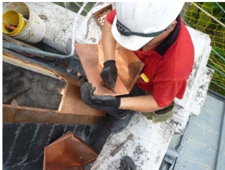
【照片 5-6-199】調整倒鉤縫隙 (98.10.22)
