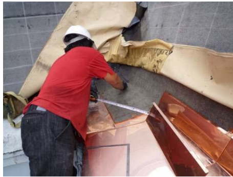
【相片 5-6-71】量測現場尺寸(由整塊 銅板彎摺施作)(98.10.17)
