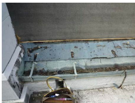
【照片 5-3-25】拆除天溝固定器 (98.08.14)
