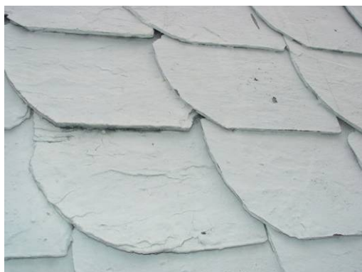
【照片 3-1-93】中央穹頂屋瓦交疊情形 (98.06.02)
