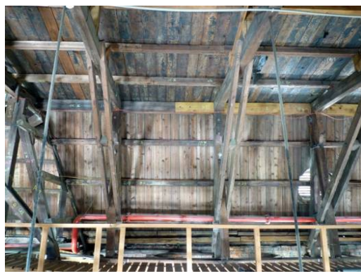
【照片 3-1-34】西翼 16 區屋面板(98.08.20)
