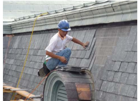
【照片 5-5-109】鋪設屋面瓦 (98.10.09)
