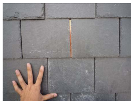
【照片 5-5-153】完成石板瓦抽換 (98.11.27)
