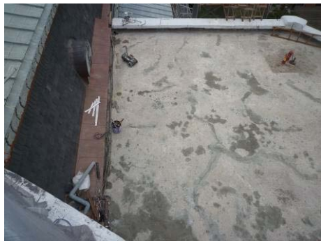
【相片 5-7-13】完成 M 形樓梯平台裂縫修補(98.12.01)
