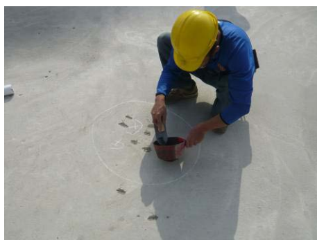
【照片 5-4-45】調配 1:3 水泥砂漿修補(98.11.26)
