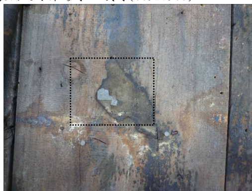
【照片 3-1-141】防水層 3 層:第 1 層油毛氈表面殘留之石板碎片(98.11.05)
