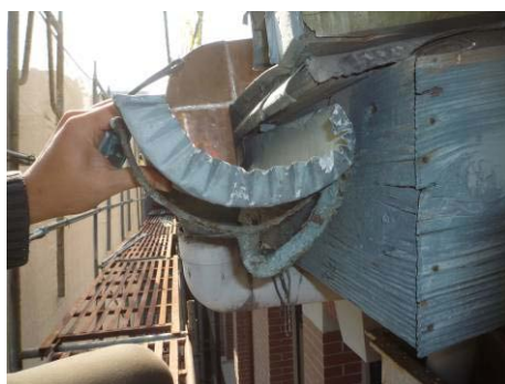
【相片 5-3-59】單坡斜屋頂天溝形式(98. 12. 22)
