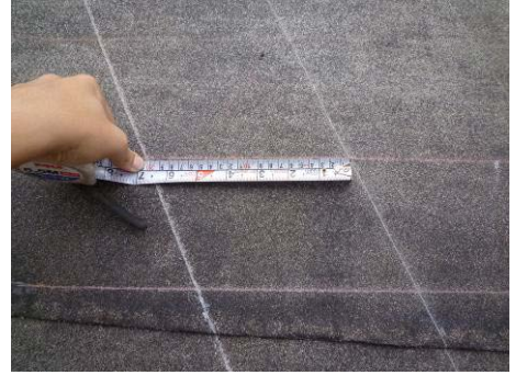
【照片 5-5-179】下緣石板瓦鋪設間距為 21.6 公分(98.11.08)
