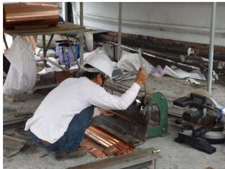
【照片 5-6-33】銅板彎摺成形 (98.10.09)
