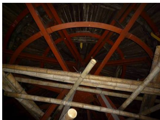
【照片 3-1-1】中央穹頂鋼構造(98.10.22)
