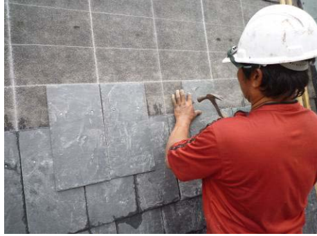
【照片 5-5-38】石板瓦依放樣線鋪設 (98.09.28)
