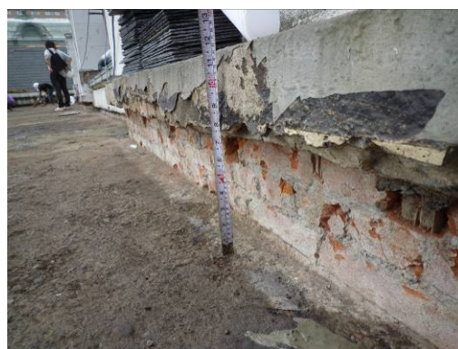
【照片 3-1-192】北翼 5 區平台(第一期興建)老虎窗底層基座(98.11.02)
