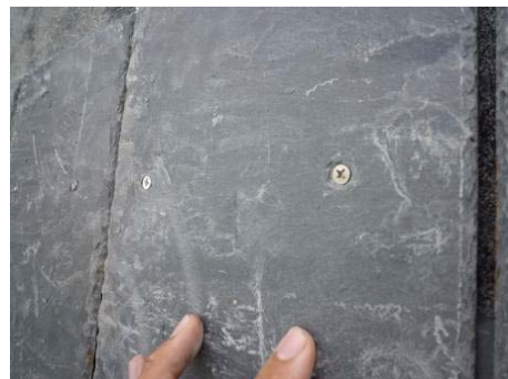
【照片 5-5-33】螺絲釘緊密石板瓦(98.09.28)
