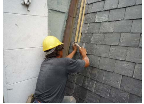
【照片 5-5-47】鋪設收邊石板瓦(98.09.28)
