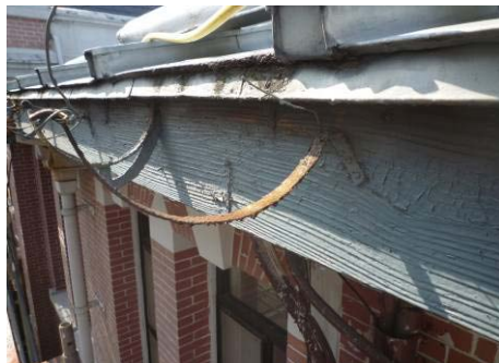
【相片 5-3-61】拆除塑膠製天溝(98. 12. 22)
