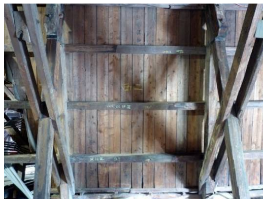
【照片 3-1-44】北翼 1 區屋面板(98.09.17)
