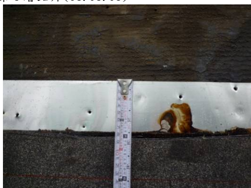
【照片 3-1-120】防水層 4 層：第 3 層鋁片上下搭接約 7.5 公分(98.08.04)
