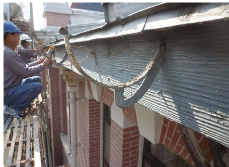
【相片 5-3-62】舊構件以砂輪機切除(98. 12. 22)
