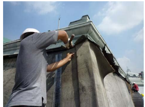
【照片 5-4-24】防水毯反摺延伸至上緣簷板內側(98.08.25)
