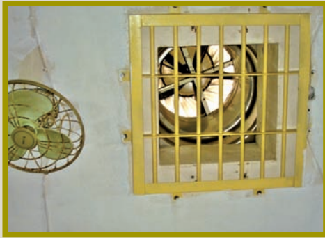
人犯就是破壞頂上的通風口，再以疊羅漢方式逐一逃到監所頂樓。
