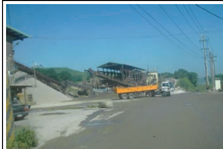
第三家砂石廠(大甲溪旁，靠清水鎮舊庄村側)運作情形
