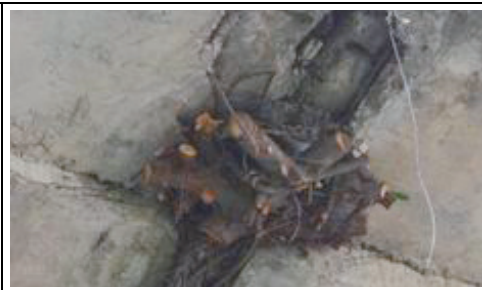
照片 8-2 植物漫生、阻塞排水孔
