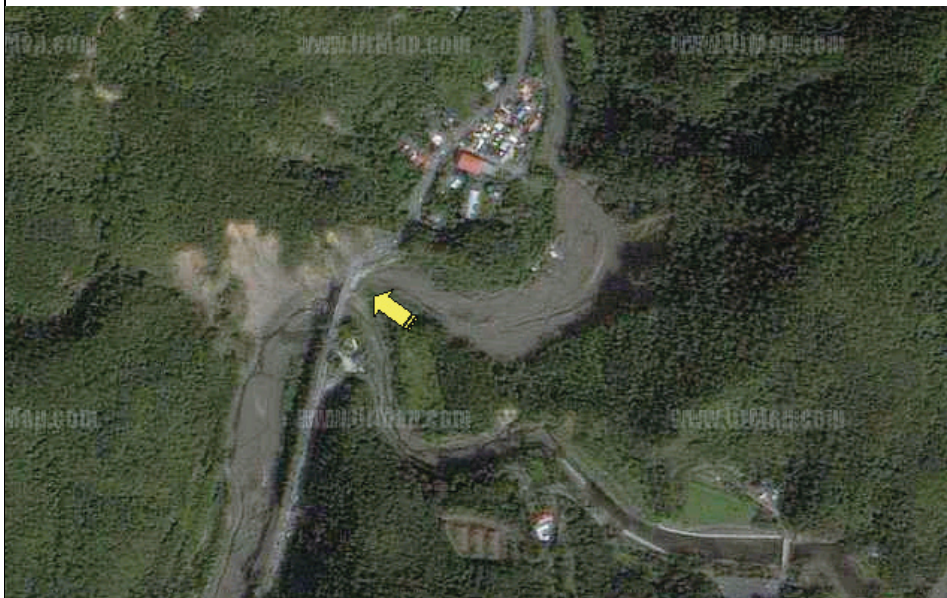
圖 4-13-2 雙流橋衛星影像圖 (網址： http://maps.google.com.tw/maps?hl=zh-TW&tab=w1 )
