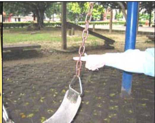
照片 3-7-2 鞦韆扶手處鏈條孔徑過大
