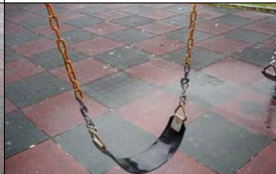
照片 3-11-4 鞦韆扶手處鏈條孔徑過大且鏽蝕
