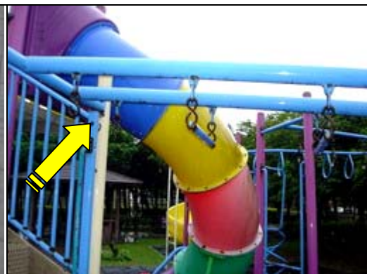
照片 3-10-2 綜合遊具之吊桿脫落
