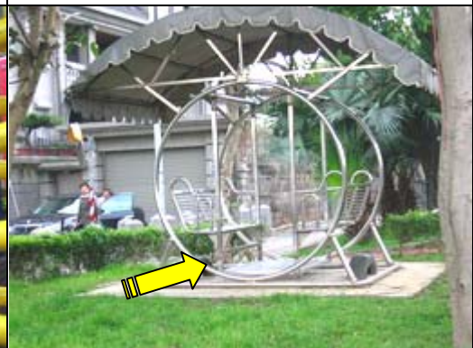
照片 4-2-4 搖椅踏板與地面間距僅約 10 cm，鉤環扣潤滑不足且未鋪設安全地墊
