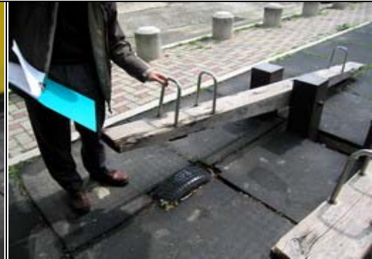
照片 4-1-6 翹翹板扶手鬆動、掉落
