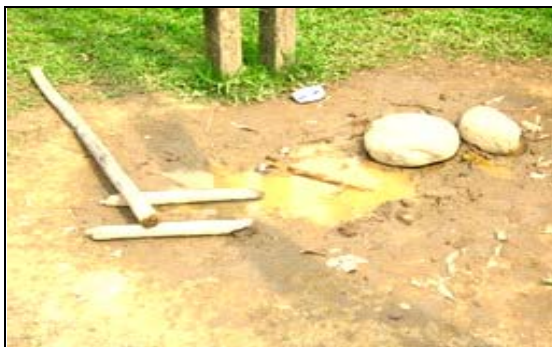
照片 2-13-1 吊環下方積水、有大石頭
