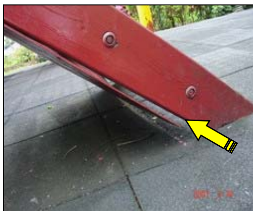
照片 1-9-1 綜合遊具階梯護板脫落
