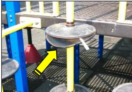
照片 2-5-7 綜合遊具踏盤面層破損
