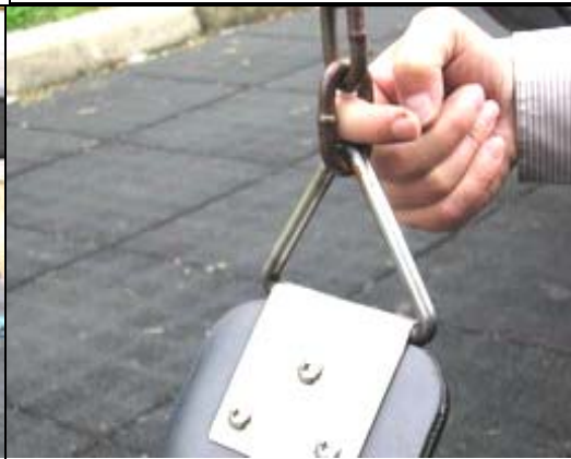
照片 3-4-7 鞦韆扶手處鏈條孔徑過大
