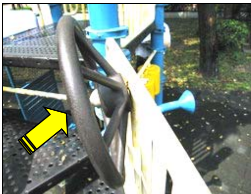
照片 2-2-1 綜合遊具平臺護欄方向盤鬆脫下垂
