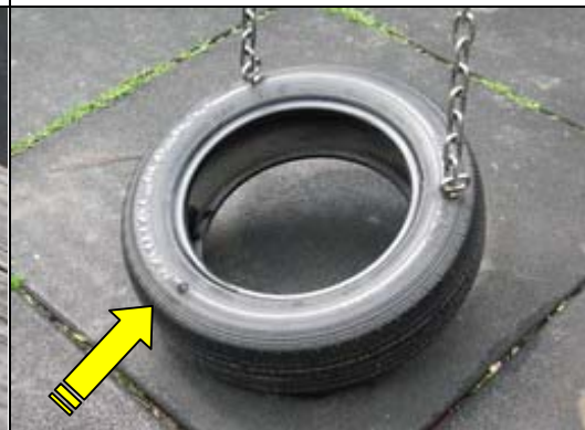
照片 4-1-8 鞦韆座椅固定栓掉落
