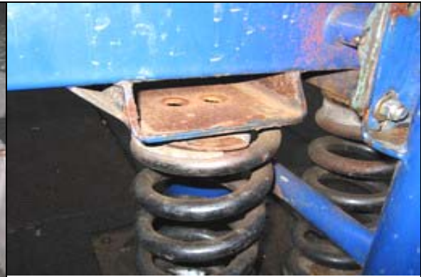
照片 2-7-10 翹翹板基座螺絲脫落，搖晃鬆弛
