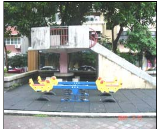
照片 1-5-6 翹翹板與滑梯間安全緩衝空間不足
