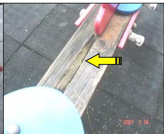
照片 1-9-2 翹翹板桿面木材腐蝕
