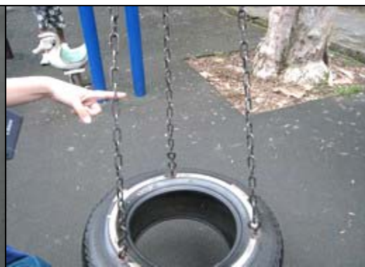
照片 3-5-6 鞦韆扶手處鏈條孔徑過大
