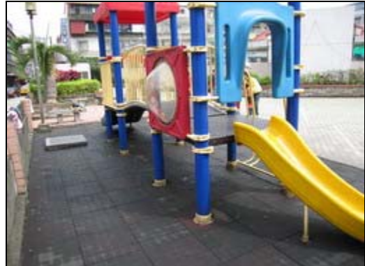
照片 2-3-1 綜合遊具周邊安全地墊濕滑易滑倒
