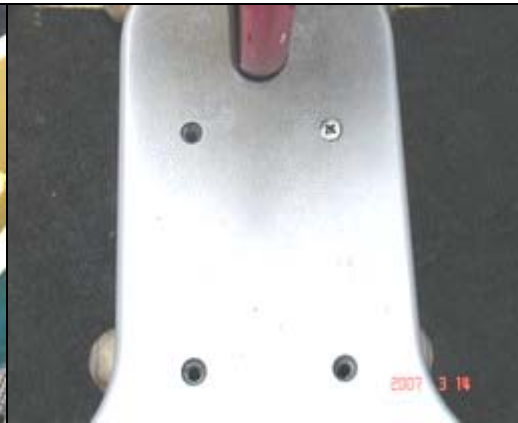
照片 1-10-7 翹翹板螺絲缺落遺失
