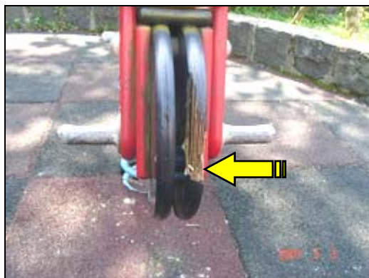
照片 1-10-8 搖搖馬前側木板破損
