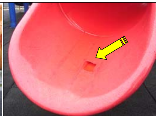
照片 3-12-6 綜合遊具滑梯滑槽底端破損
