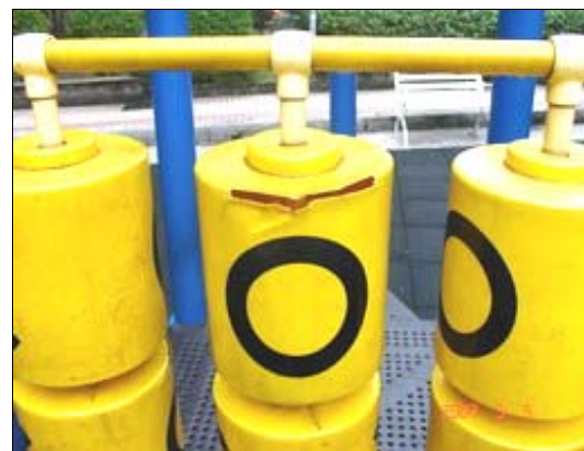
照片1-4-7 綜合遊具平臺護欄元件破損
