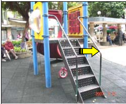
照片 1-2-7 綜合遊具之階梯扶手鬆動
