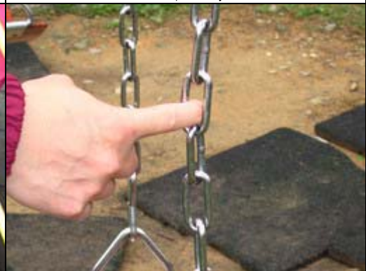
照片 3-8-10 鞦韆扶手處鏈條孔徑過大
