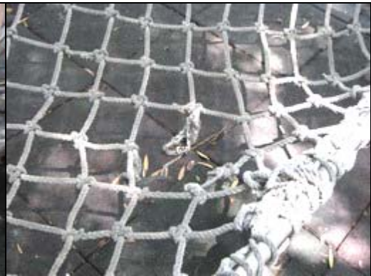
照片 3-1-16 攀爬網網繩斷損
