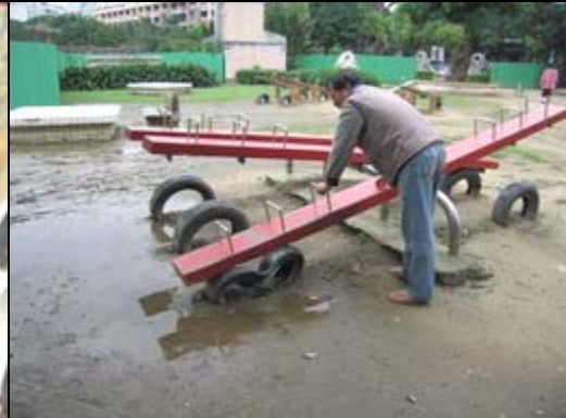
照片 2-4-3 翹翹板緩衝輪胎損壞
