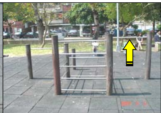
照片 1-10-2 單槓水平桿鬆動未牢固
