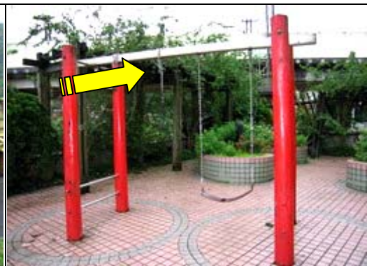
照片 2-17-2 鞦韆損壞未拆除亦未警示
