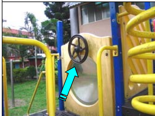
照片 4-2-3 綜合遊具平臺護欄桿件鬆動，方向盤鬆脫
