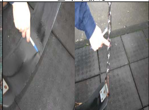
照片 2-7-7 鞦韆座椅有裂痕、扶手處鏈條孔徑過大
