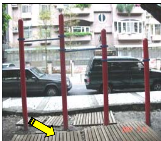
照片1-5-7 單槓下方地面未鋪設安全地墊
