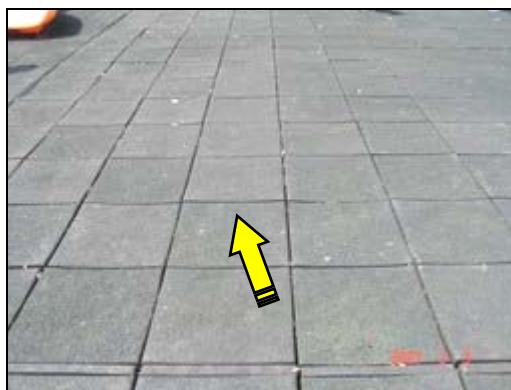
照片 1-10-1 安全地墊欠平整
