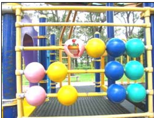
照片 4-2-5 綜合遊具平臺護欄元件破損
