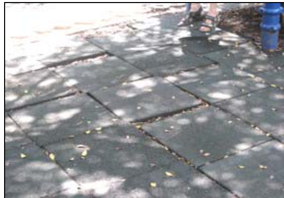
照片 3-1-14 安全地墊不平整，縫隙過大
