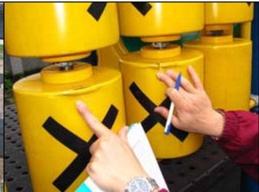
照片 3-8-8 綜合遊具平臺護欄的元件破裂
