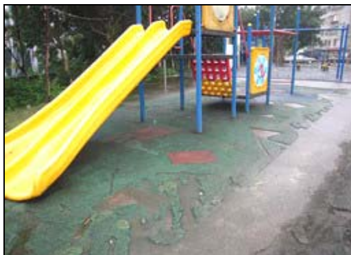
照片 2-7-4 綜合遊具區安全地墊缺損
