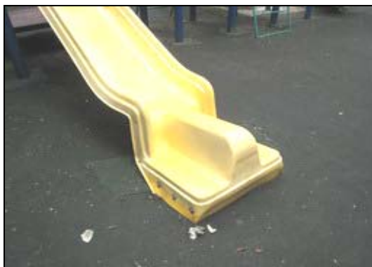
照片 3-5-5 滑梯滑槽底端設計不當
