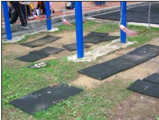
照片 3-8-7 鞦韆下方安全地墊零散
