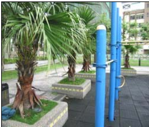
照片 2-1-8 單槓與旁邊植物缺乏足夠之安全緩衝距離
