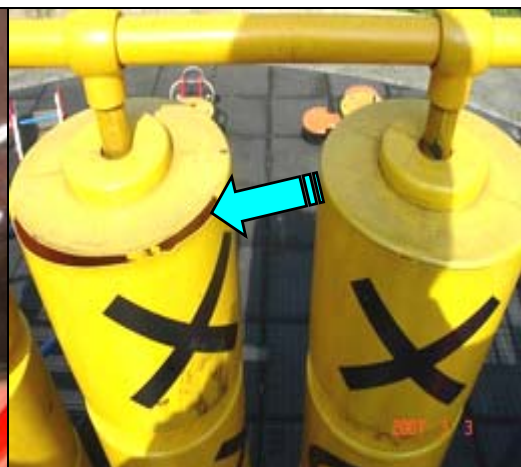
照片 1-7-7 綜合遊具平臺護欄元件破損
