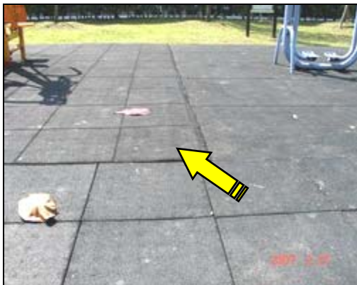
照片 1-4-1 安全地墊欠平整
