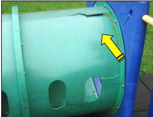
照片 2-7-2 隧道外殼破損
