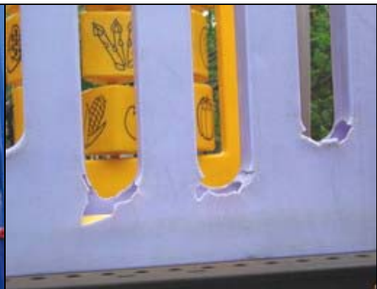
照片 2-3-4 綜合遊具平臺護欄破損
