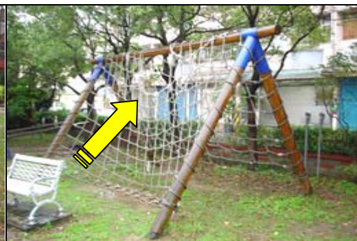
照片 3-11-6 攀爬網網繩斷損
