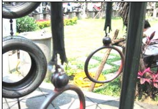
照片 2-5-11 綜合遊具吊環鏈條的護套脫損
