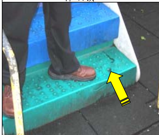
照片 2-15-7 綜合遊具階梯破損
