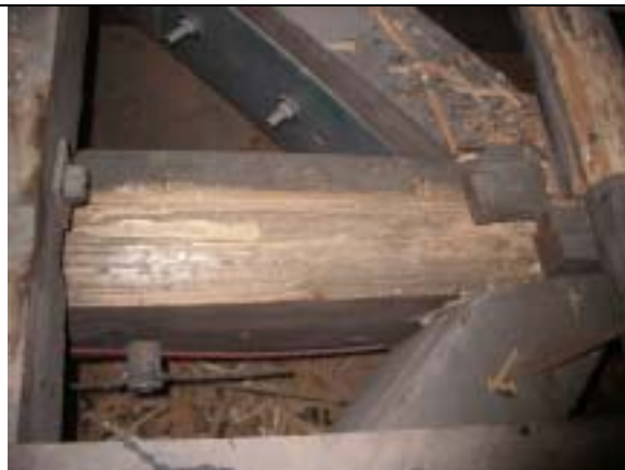
【圖版 5-61】鑿除腐朽部分木材
