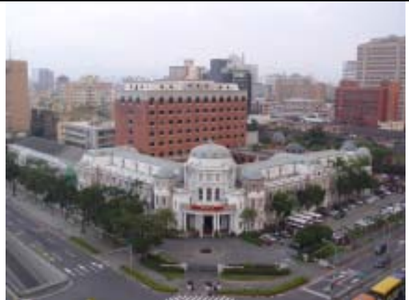
【圖版 5-22】假設工程拆除完成後院區整體環境照
