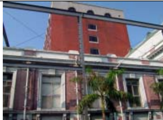
【圖版 5-14】鋼棚架結構體吊裝
