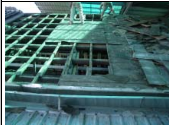
【圖版 5-271】野地板拆除
