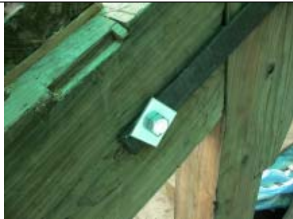
【圖版 5-47】新仿作鐵板及螺栓
