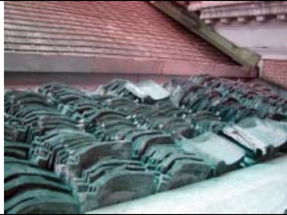
【圖版 5-243】日式黑瓦拆除後再利用
