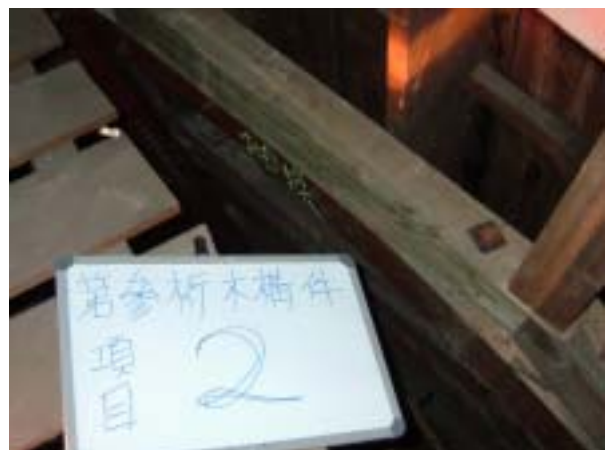
【圖版 5-93】木結構抽換後 參區，D架 7R，D 級抽換
