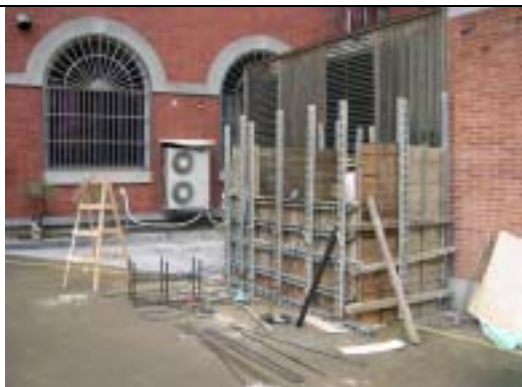
【圖版 5-7】組立基礎灌漿模板
