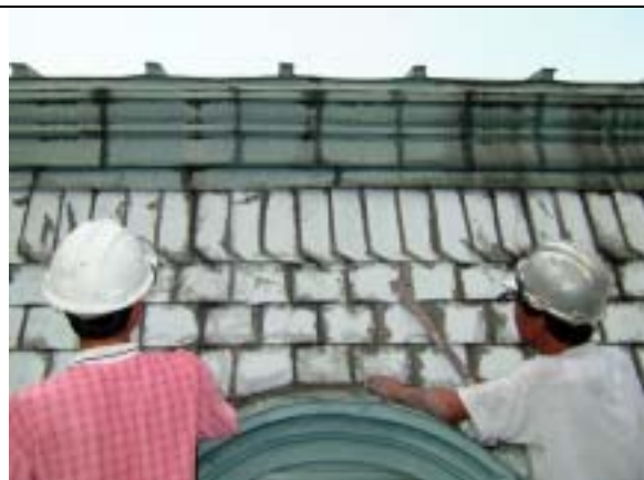
【圖版 5-209】用工具撬起石棉瓦片
