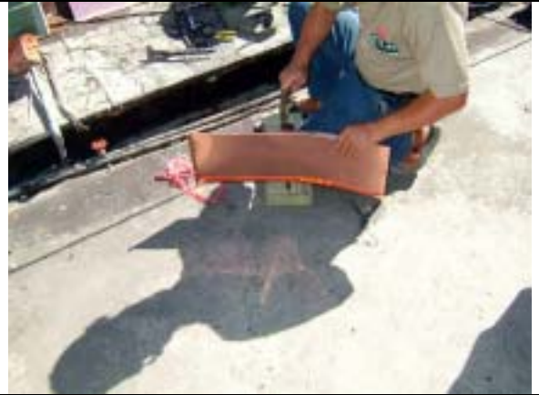
【圖版 5-146】逐漸彎折銅材至適用形狀
