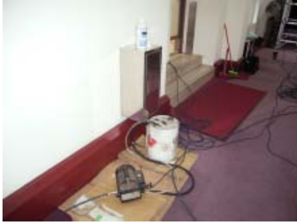
圖版 4-12. 灌注加壓設備
