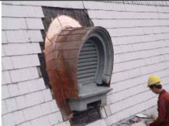
【圖版 5-195】牛眼窗完成現況（壹區庭園側）
