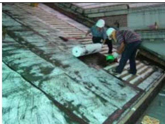
【圖版 5-287】RA 防水纖維膠與纖維棉同時施工
