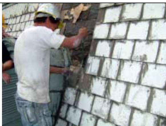
【圖版 5-124】反覆拆除瓦片動作
