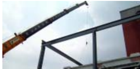
【圖版 5-2】大型吊車
