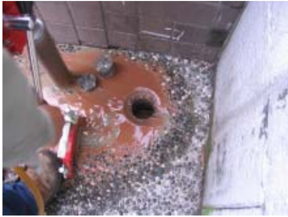
3.鑽孔完成（台環企業提供）
