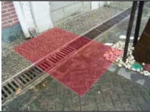
【圖版 5-3】放樣鋼棚架基礎位置
