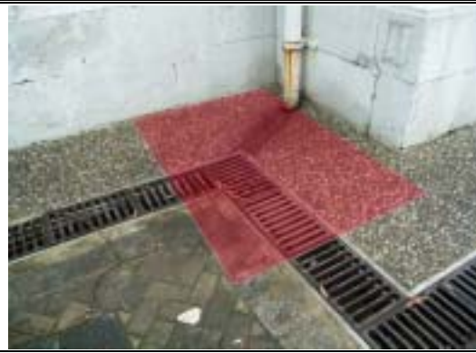
【圖版 5-4】放樣鋼棚架基礎位置
