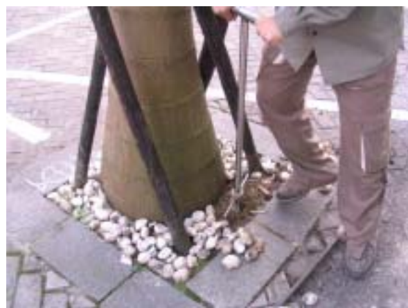
2.以專用鑽孔工具鑽孔（台環企業提供）
