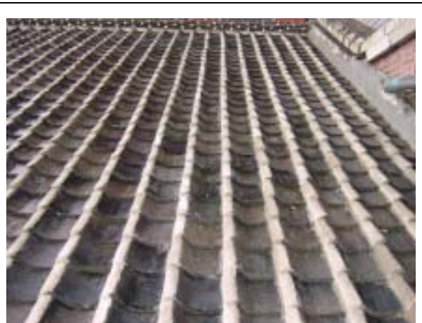
【圖版 5-314】工程完工後現況
