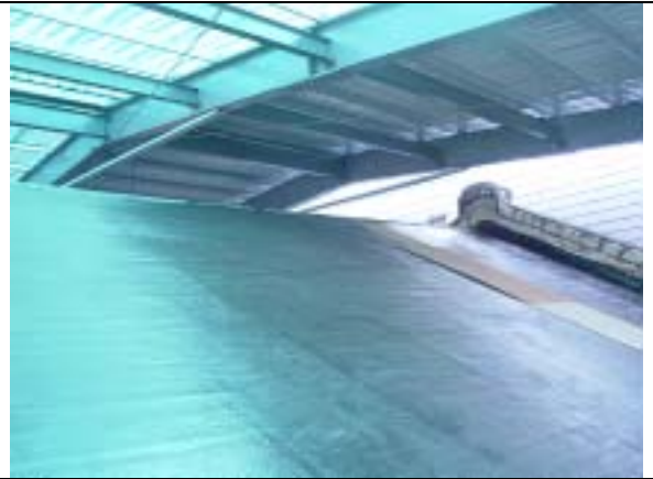
【圖版 5-109】防水工程完成後現況（第肆區，臨忠孝東路側）
