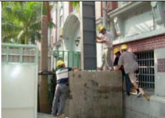
【圖版 5-13】固定鋼結構於預作之基礎上
