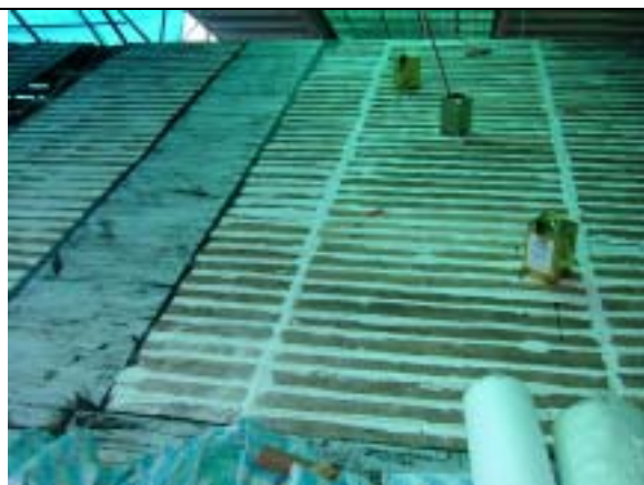
【圖版 5-285】填縫作業（防止柏油漏下）
