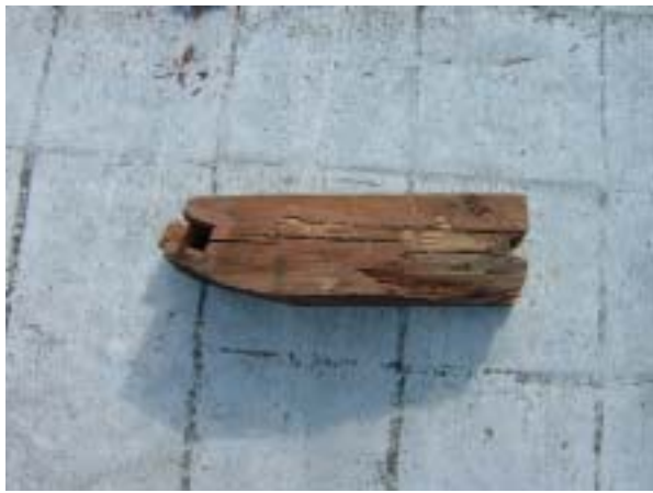
【圖版 5-102】木結構抽換前 東側衛塔，F 架構件 8，D 級抽換（原列為 B 級整修）
