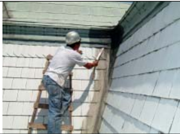
【圖版 5-127】用工具撬起石棉瓦片
