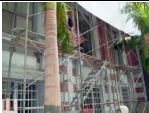
【圖版 5-17】施工組裝設置
