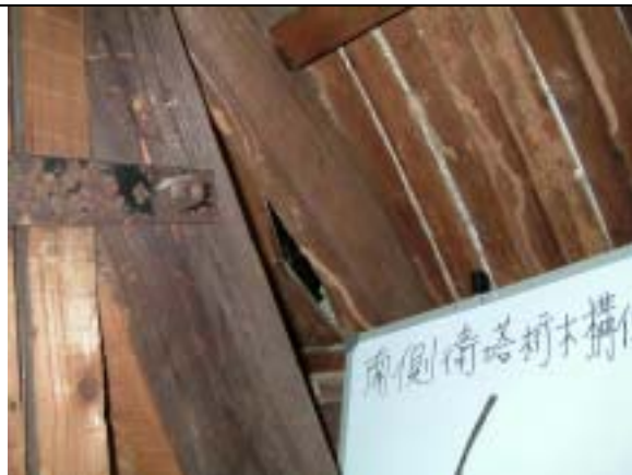
【圖版 5-43】木構件調查作業 南側衛塔木構件（天下營造提供）
