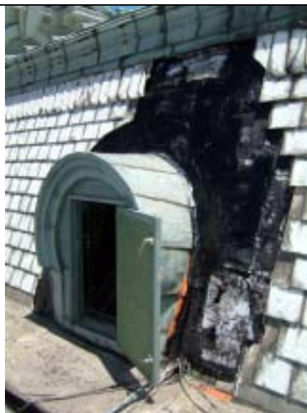
【圖版 5-105】防水層施作
