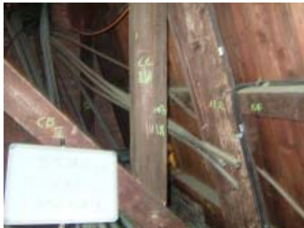
【圖版 5-79】木結構 EPOXY 修補前 臺區，B 架 14，C 級修復
