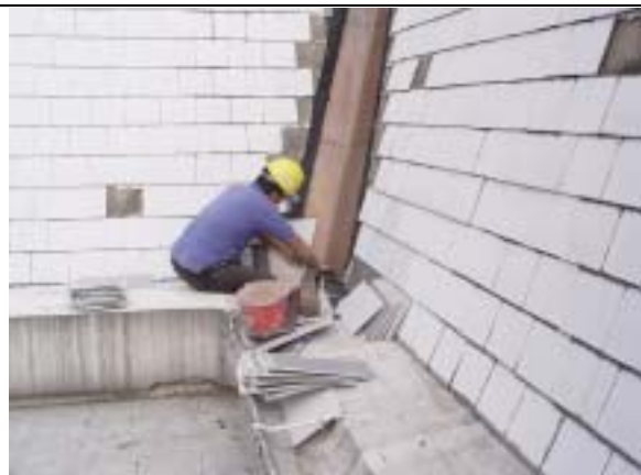
【圖版 5-221】試量。(由下往上施工)
