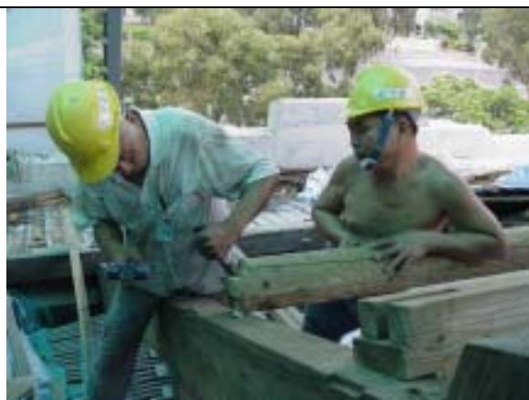
【圖版 5-273】拆除腐朽構件
