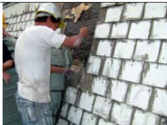
【圖版 5-212】反覆拆除瓦片動作
