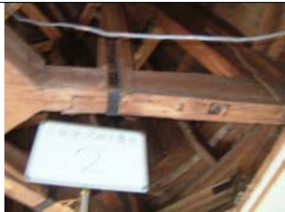
【圖版 5-44】木構件調查作業 北側衛塔（天下營造提供）
