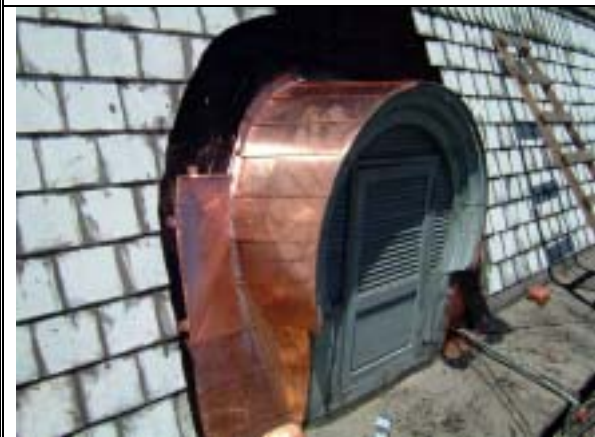
【圖版 5-165】部分完成的樣貌
