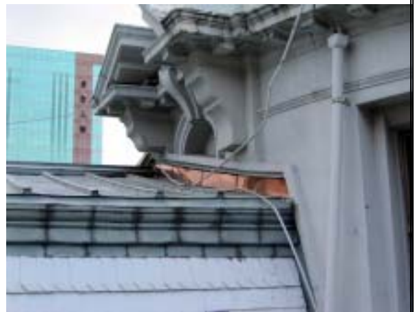
【圖版 5-194】使用銅皮補強裂縫後外觀樣貌
