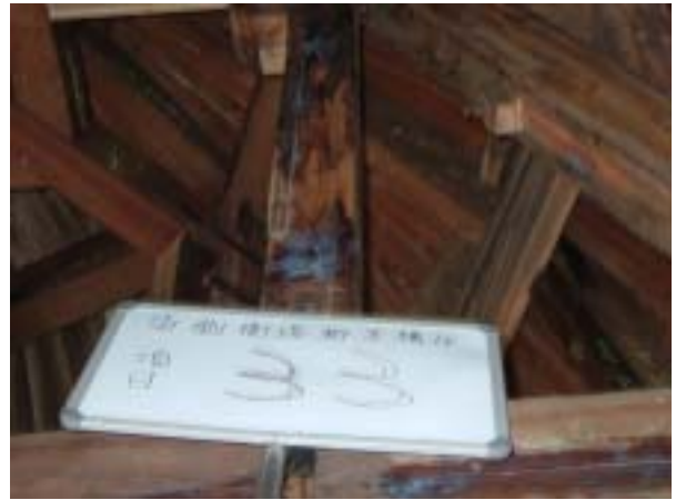
【圖版 5-103】木結構抽換後 東側衛塔，F 架構件 8，D 級抽換（原列為 B 級整修）
