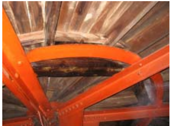
4. 舊木構件噴塗處理完成(台環公司提供)
