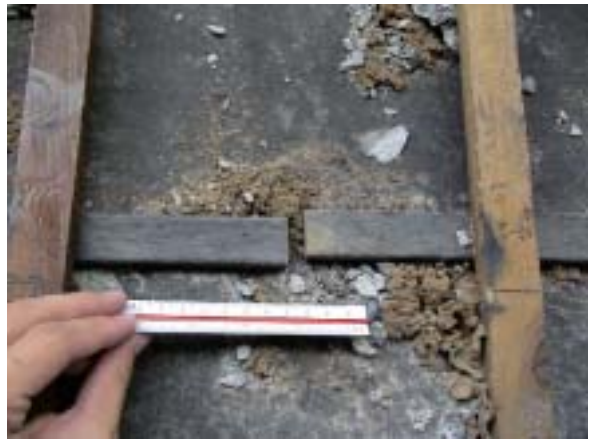
【圖版 5-258】量測舊有掛瓦條間距（以利修正施工圖說）
