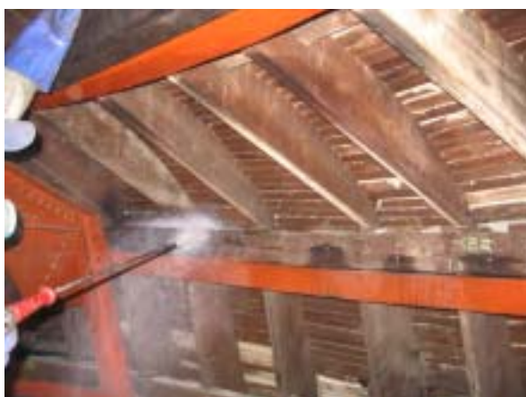
5. 舊木構件噴塗處理(台環公司提供)
