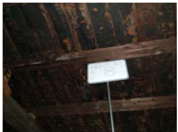
【圖版 5-87】木結構修補後 貳區，C 間 S2，B 級修復
