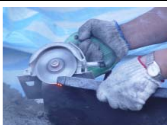
【圖版 5-244】舊瓦清洗處理
