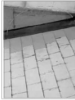
照片 1-12 現況說明：新舊屋頂交接處屋頂排水溝，部分已施作屋頂。 修復說明： 1. 清除原有屋頂排水溝，防止屋架劣化。 2. 完成屋頂排水溝安裝及組件，屋頂已施作屋頂。
