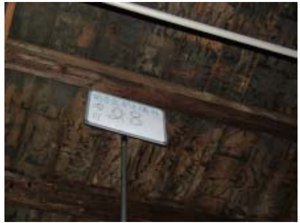
【圖版 5-85】木結構修補後 臺區，G 間 W1，B 級修復
