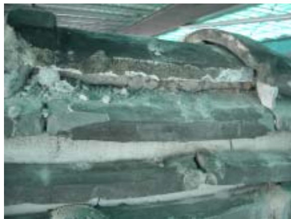
【圖版 5-251】拆卸屋脊（脊瓦）
