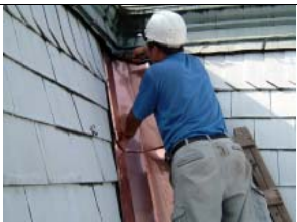
【圖版 5-178】新舊接合處處理概況
