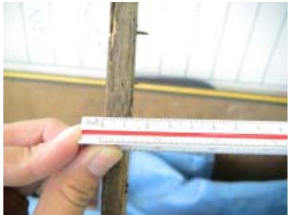
【圖版 5-262】量測舊有掛瓦條尺寸
