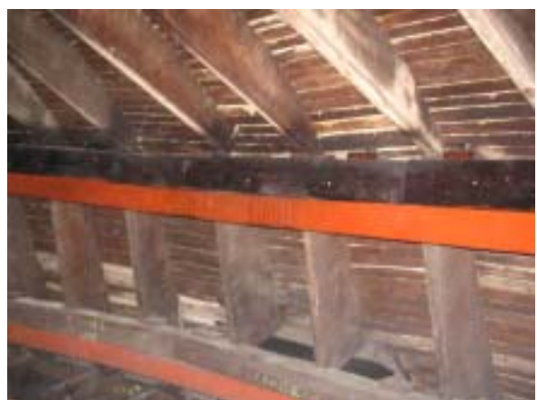
6. 舊木構件噴塗處理完成(台環公司提供)
