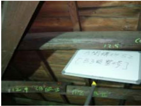
【圖版 5-94】木結構修補前 肆區，A 間構件 S2，B3 級整修
