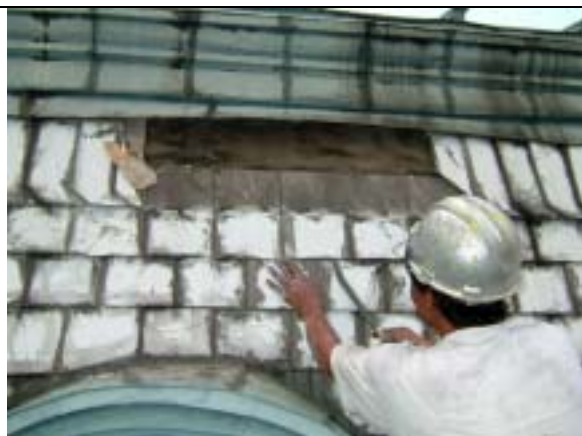
【圖版 5-122】取下石棉瓦片
