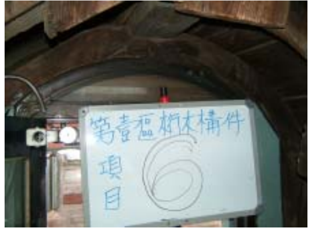
【圖版 5-82】木結構 EPOXY 修補後 臺區，C 架牛眼窗，C 級修復
