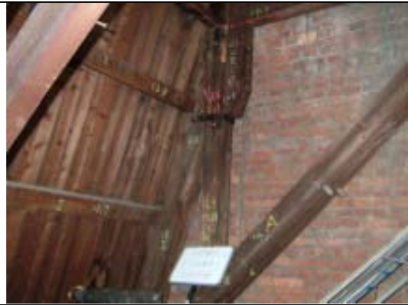
【圖版 5-40】木構件調查作業 貳區 A 架構件 14-C 級整修（天下營造提供）
