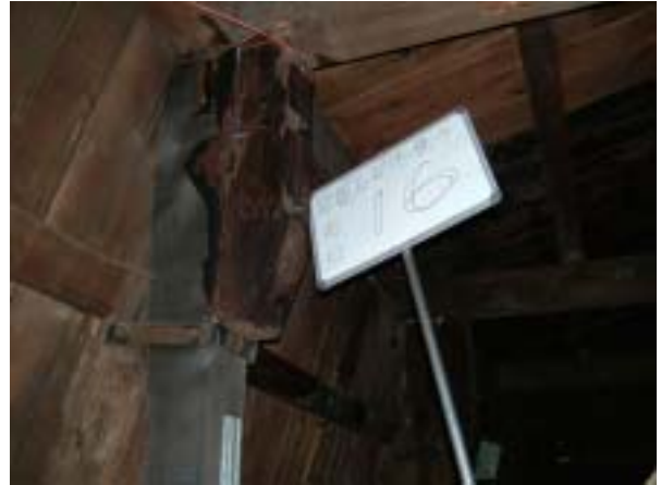
【圖版 5-89】木結構修補後 貳區，E架 10，C 級修復
