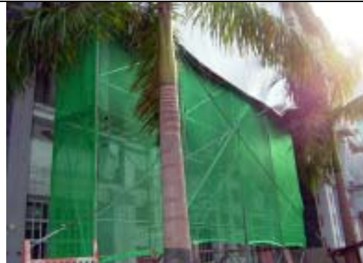
【圖版 5-18】裝設安全防護網
