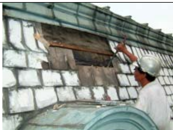
【圖版 5-211】反覆拆除瓦片動作
