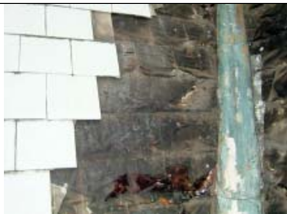
【圖版 5-129】拆除後所露出的銅皮底層
