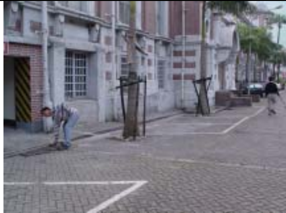
【圖版 5-21】假設工程拆除後清理現況
