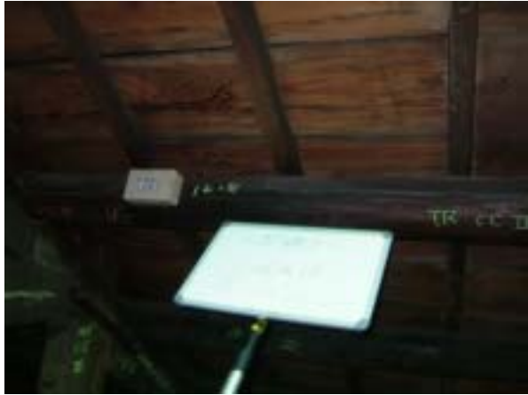
【圖版 5-100】木結構抽換前 肆區，S 間構件 N2，D 級抽換
