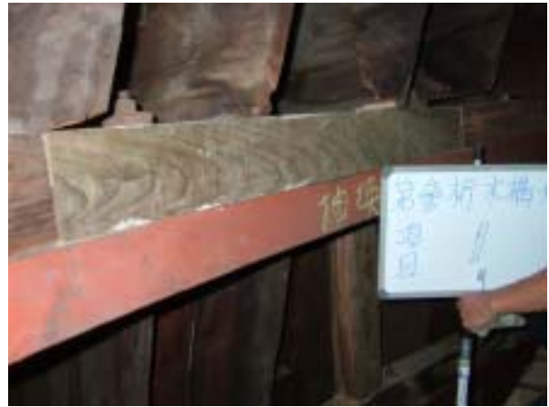
【圖版 5-91】木結構抽換後 參區，D架 6C，D 級抽換
