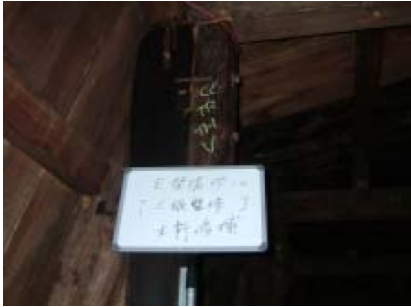
【圖版 5-88】木結構修補前 貳區，E架 10，C 級修復
