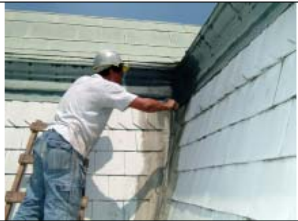
【圖版 5-128】用工具撬起石棉瓦片
