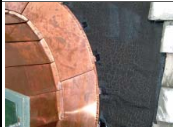
【圖版 5-171】搭接完成後的邊緣概況
