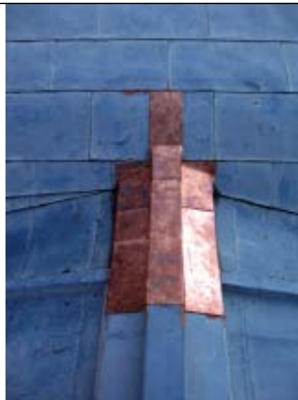
【圖版 5-190】屋脊轉折處之作法概況
