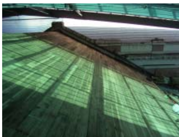
【圖版 5-284】野地板完工
