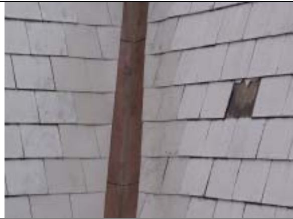
【圖版 5-240】鍍鋅鋼板更換工程－馬薩斜屋頂位置完成
