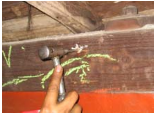
6.木構件灌注處理(台璟公司提供)
