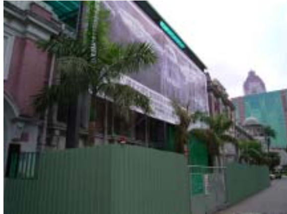
【圖版 5-19】假設工程完工後現況
