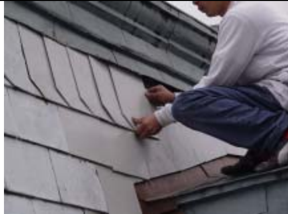
【圖版 5-233】簷下鍍鋅鋼板施工
