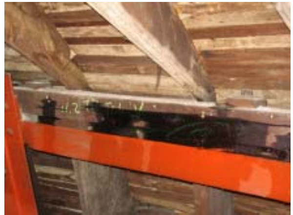
8.木構件灌注處理完成(台璟公司提供)
