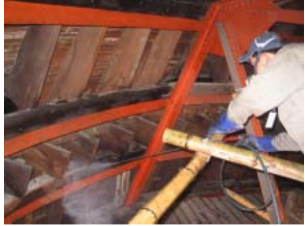
8.舊木構件噴塗處理(台環公司提供)
