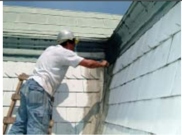
【圖版 5-216】用工具撬起石棉瓦片
