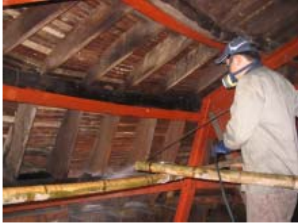
7.舊木構件噴塗處理(台環公司提供)
