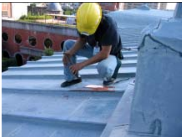
【圖版 5-180】使用工具扳起舊銅皮邊緣
