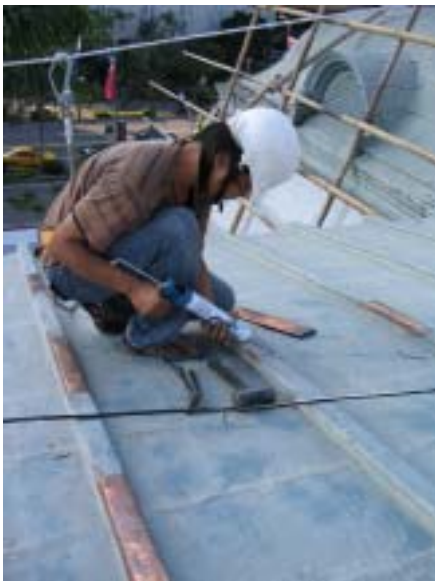
【圖版 5-183】在銅皮上方先行塗上防水膠
