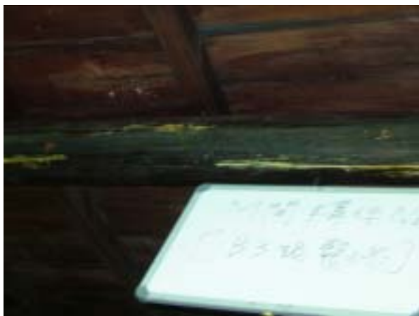
【圖版 5-96】木結構修補前 肆區，M 間構件 N2，B3 級整修
