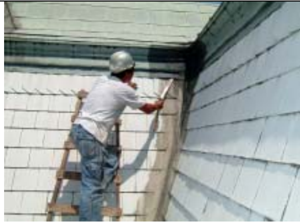
【圖版 5-215】用工具撬起石棉瓦片
