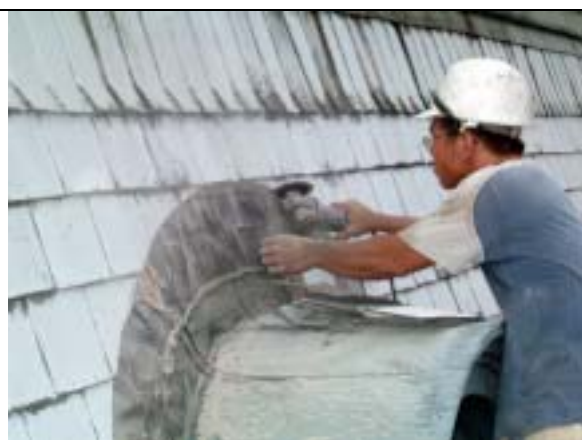
【圖版 5-123】小型輪鋸切出施工範圍
