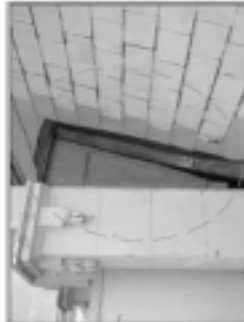
照片1-08 現況說明：配合原樓層立樑及鋼架桁架中樑，重新安裝吊頂式吸音磚。 修復說明： 1. 拆除原有吸音磚及吊頂式吸音磚，防止霉變。 2. 重新安裝吸音磚及吊頂式吸音磚，保證吊頂式吸音磚。
