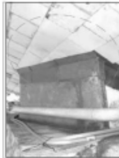
照片1-07 現況說明：配合原樓層立樑及鋼架桁架中樑，重新安裝吊頂式吸音磚。 修復說明： 1. 拆除原有吸音磚及吊頂式吸音磚，防止霉變。 2. 重新安裝吸音磚及吊頂式吸音磚，保證吊頂式吸音磚。
