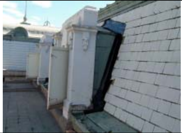
【圖版 5-107】防水工程完成後現況（第壹區，臨中山南路側）
