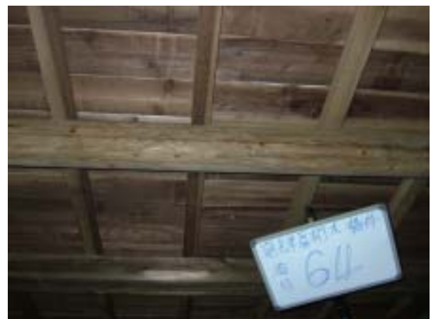
【圖版 5-99】木結構抽換後 肆區，S 間構件 S2，D 級抽換
