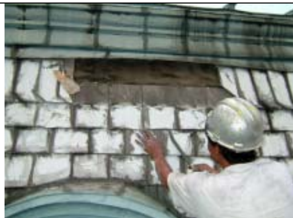
【圖版 5-210】取下石棉瓦片
