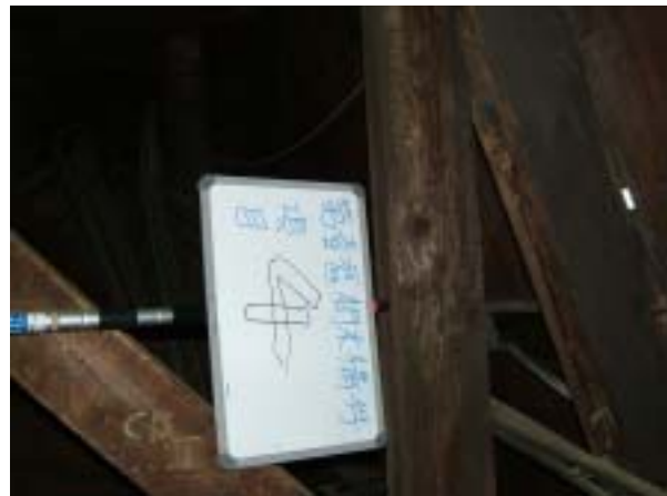
【圖版 5-80】木結構 EPOXY 修補後 臺區，B 架 14，C 級修復
