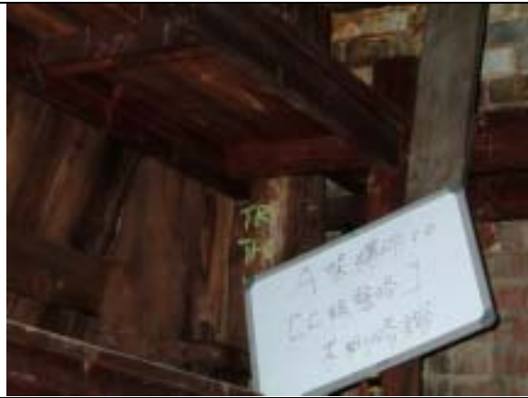
【圖版 5-39】木構件調查作業， 壹區 A 架構件 10（天下營造提供）
