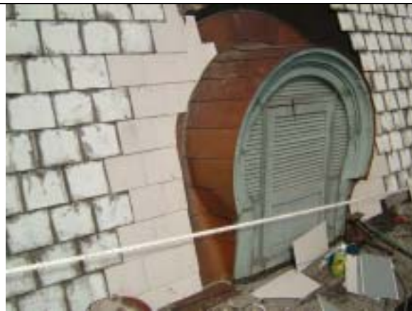
【圖版 5-235】牛眼窗鍍鋅鋼板施作
