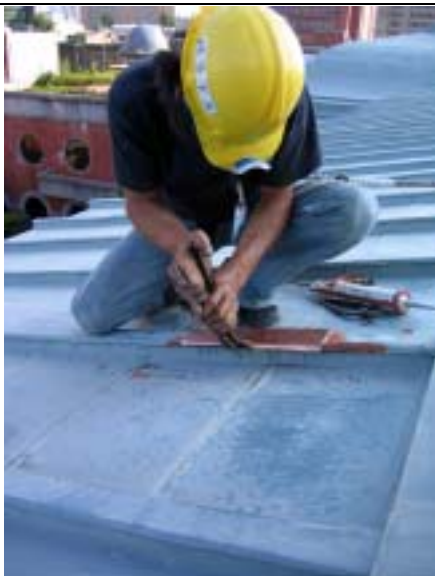
【圖版 5-185】使新舊材邊緣完全彎折咬合
