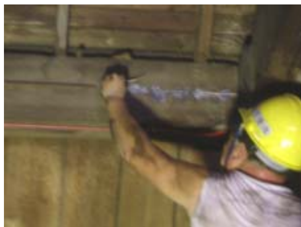
【圖版 5-58】將木材突出處整平
