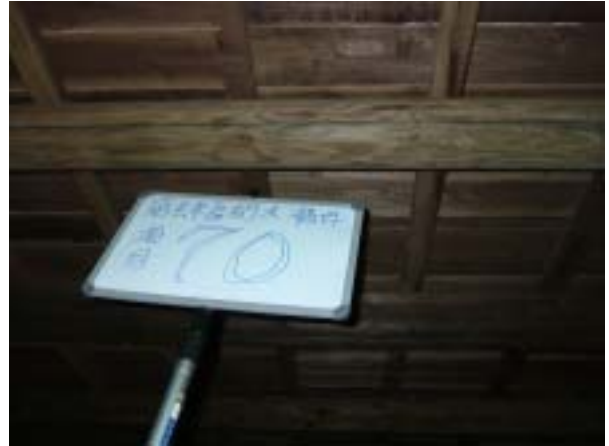
【圖版 5-101】木結構抽換後 肆區，S 間構件 N2，D 級抽換
