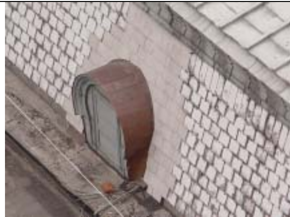
【圖版 5-241】鍍鋅鋼板更換工程－牛眼窗位置完成
