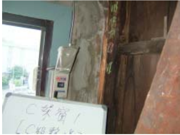
【圖版 5-81】木結構 EPOXY 修補前 臺區，C 架牛眼窗，C 級修復
