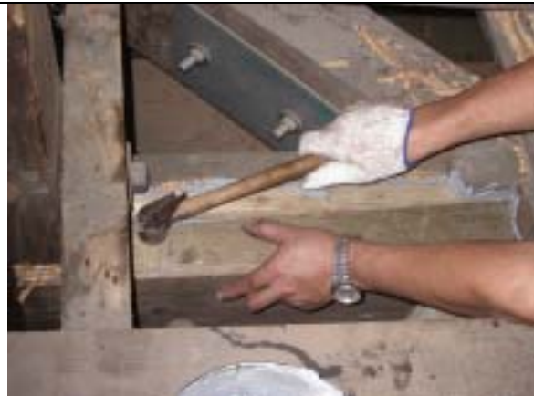
【圖版 5-65】將木材突出處整平
