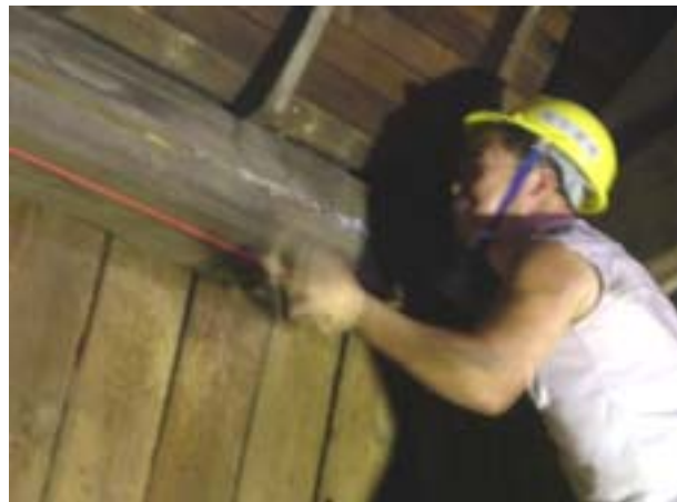
【圖版 5-60】表面清除後完成修補
