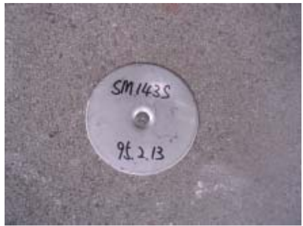
6.地下型餌站裝設完成（台環企業提供）
