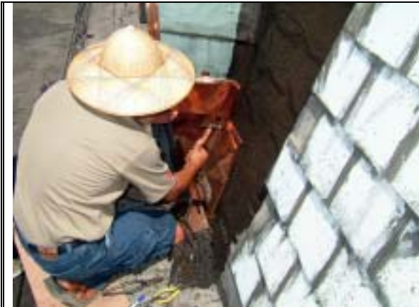
【圖版 5-169】調整銅皮間的密合程度
