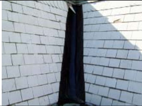
【圖版 5-106】防水工程完成後現況（第貳區，臨忠孝東路側）
