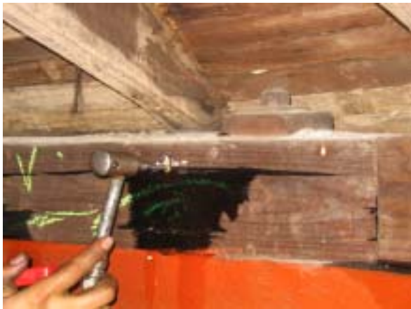
7.木構件灌注處理(台璟公司提供)
