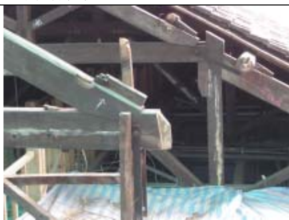
【圖版 5-273】拆除腐朽構件
