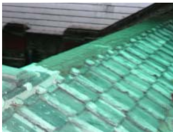
【圖版 5-308】屋脊施工
