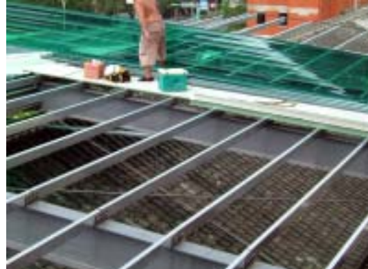
【圖版 5-16】鋼棚架屋面浪板施作
