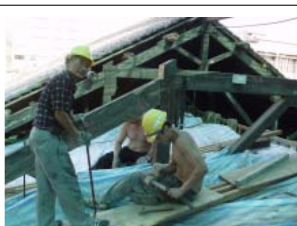
【圖版 5-274】修復作業丈量尺寸
