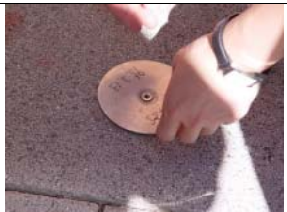
地下型－鐵蓋（2006年07月31日）
