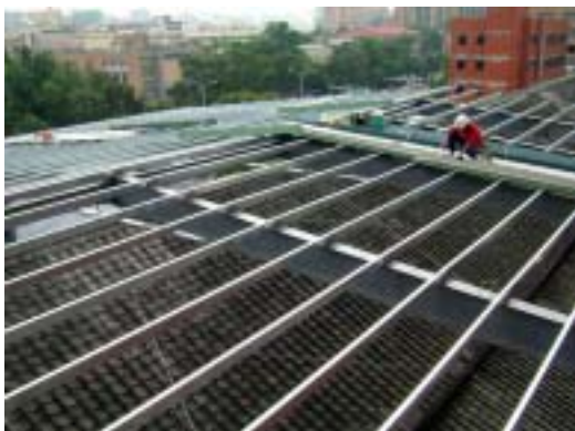
【圖版 5-15】鋼棚架支架組裝
