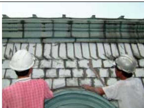
【圖版 5-121】用工具撬起石棉瓦片
