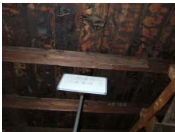
【圖版 5-86】木結構修補前 貳區，C 間 S2，B 級修復
