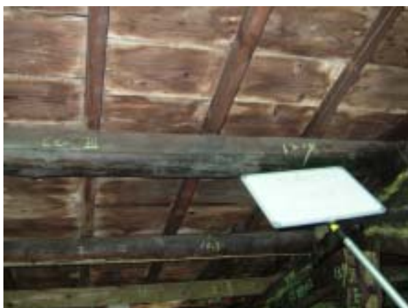
【圖版 5-98】木結構抽換前 肆區，S 間構件 S2，D 級抽換
