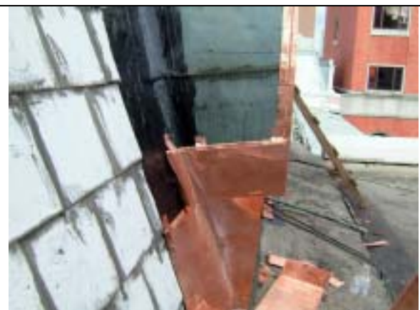
【圖版 5-158】部分搭接完成樣貌
