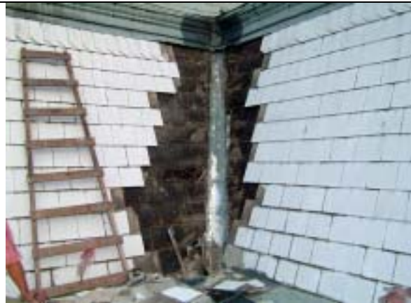
【圖版 5-217】拆除石棉瓦片
