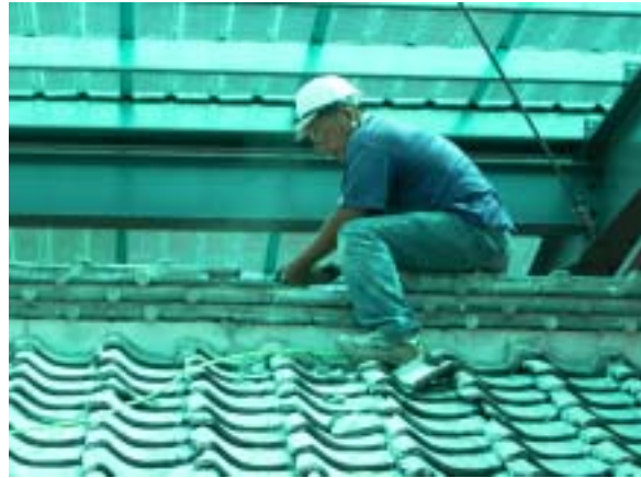
【圖版 5-249】拆卸屋脊（脊瓦）
