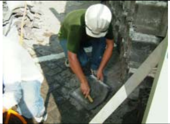
【圖版 5-268】使用鐵刷輕刮表面清除殘留
