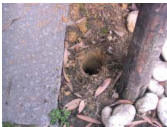
3.鑽孔完成（台環企業提供）
