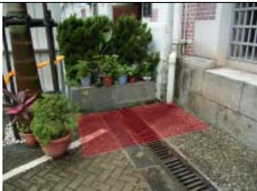
【圖版 5-5】放樣鋼棚架基礎位置
