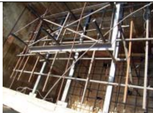
【圖版 5-8】鋼棚架基礎鋼筋配置
