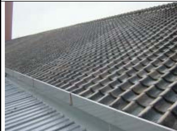
【圖版 5-313】工程完工後現況
