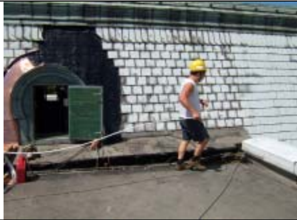
【圖版 5-133】 搭設安全線扶手
