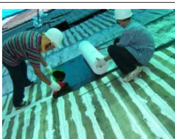
【圖版 5-288】RA 防水纖維膠與纖維棉同時施工
