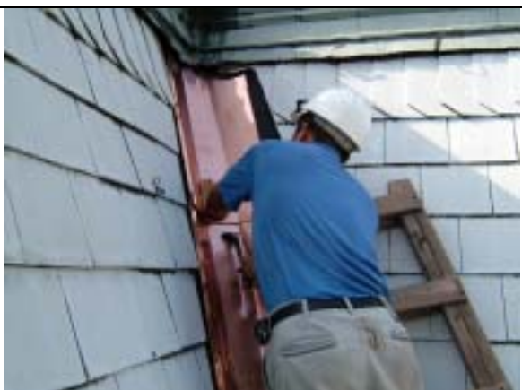
【圖版 5-176】彎折銅皮接合處以防止鬆動
