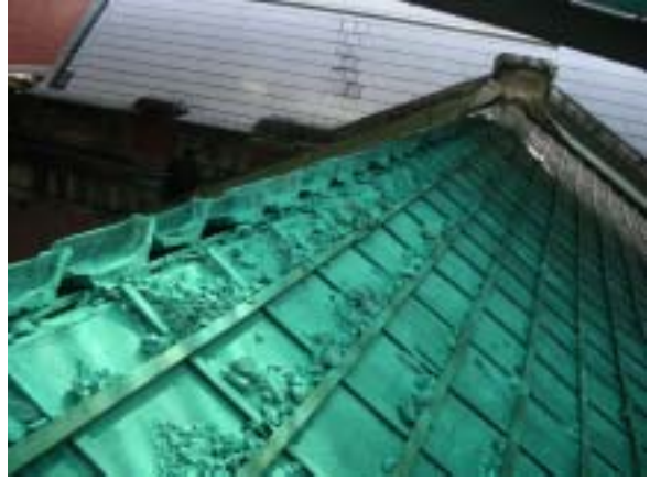
【圖版 5-256】黑瓦拆除清理後狀況
