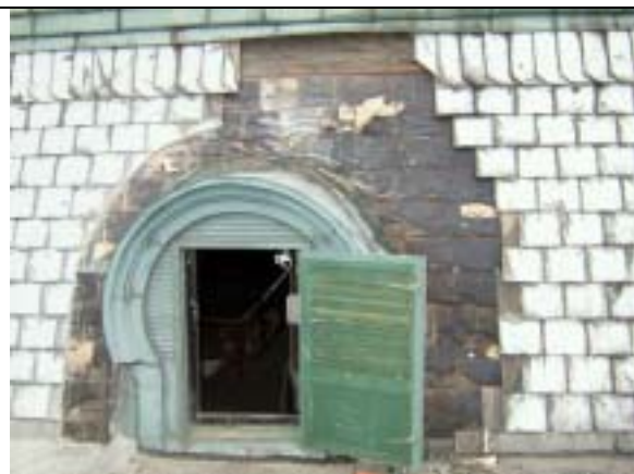
【圖版 5-214】拆除完成
