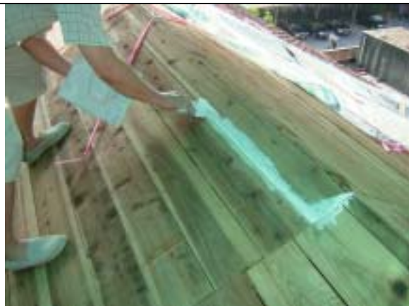
【圖版 5-285】填縫作業（防止柏油漏下）
