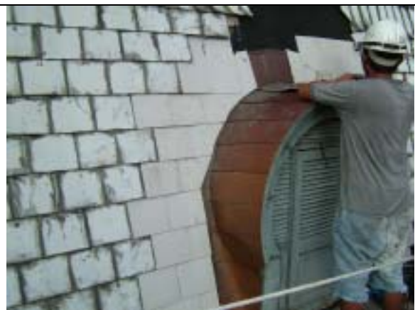
【圖版 5-238】牛眼窗鍍鋅鋼板施作
