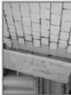
照片 1-01 現況說明：原牆面鑿除，補設鋼絲網及抹灰。 修復說明： 1. 拆除原有牆面，並清理現場。 2. 補設鋼絲網及抹灰，並塗刷防水塗料。
