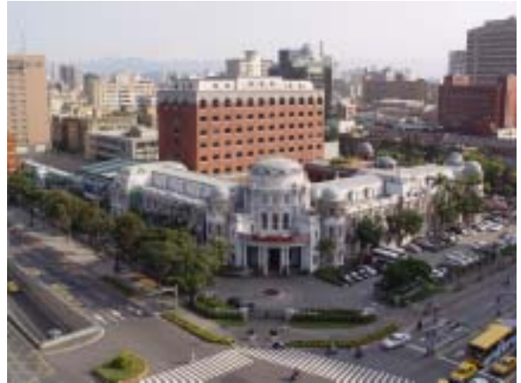
【圖版 5-20】假設工程搭設完成後院區整體環境照
