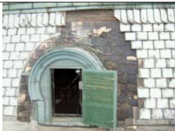
【圖版 5-125】拆除完成
