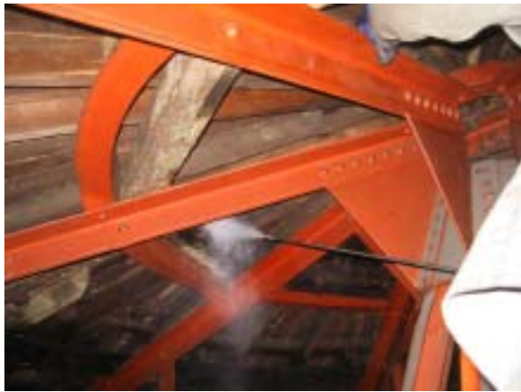
1. 舊木構件噴塗處理(台環公司提供)
