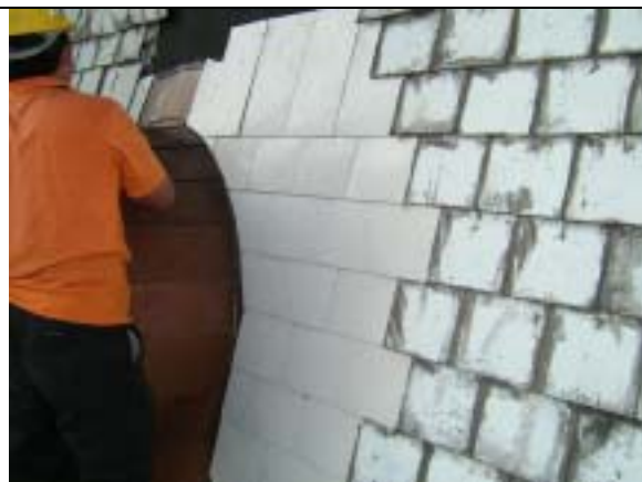
【圖版 5-237】牛眼窗鍍鋅鋼板局部狀況
