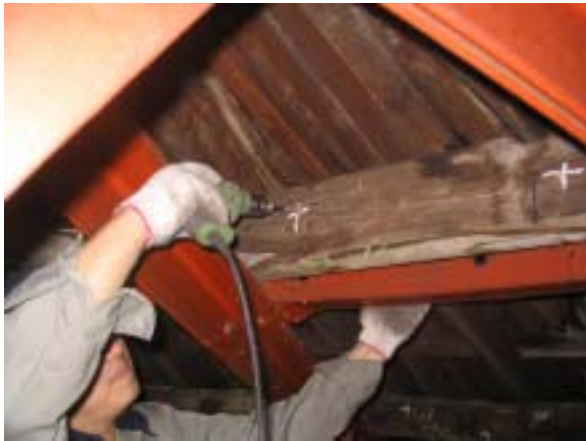
3.木構件鑽孔(台璟公司提供)
