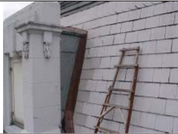
【圖版 5-239】鍍鋅鋼板更換工程－老虎窗位置完成
