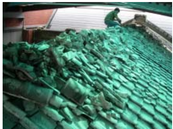
【圖版 5-252】拆卸現場
