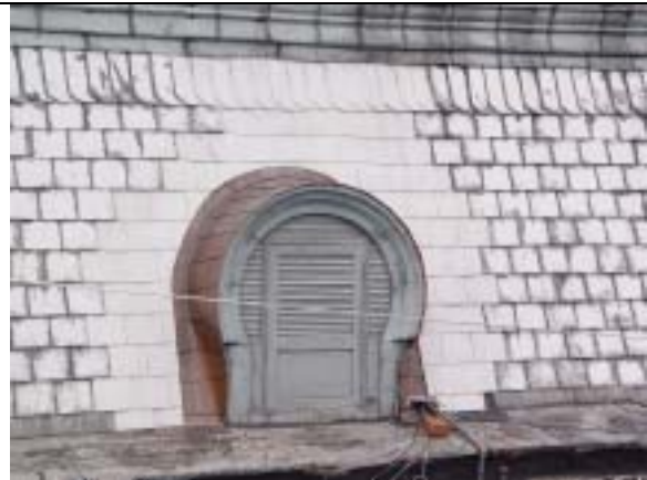
【圖版 5-242】鍍鋅鋼板更換工程－老虎窗位置完成
