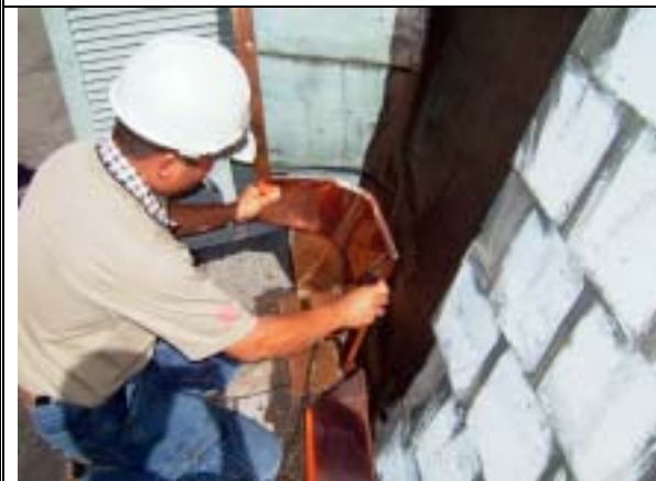
【圖版 5-167】調整形狀來緊貼舊銅皮表面
