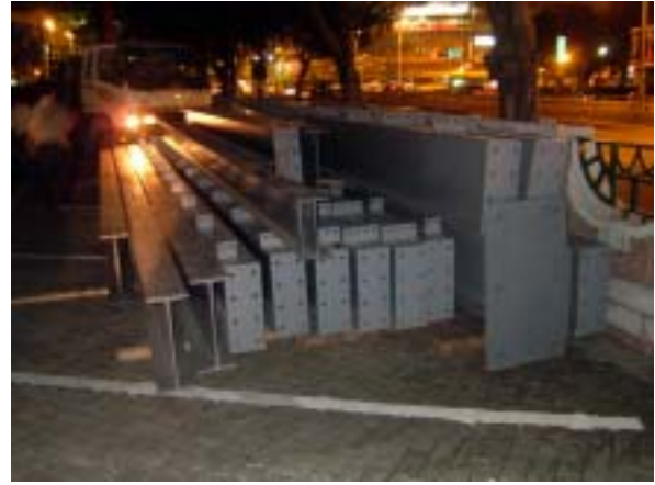
【圖版 5-1】鋼料進場
