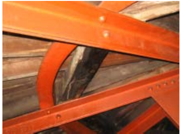
2. 舊木構件噴塗處理完成(台環公司提供)
