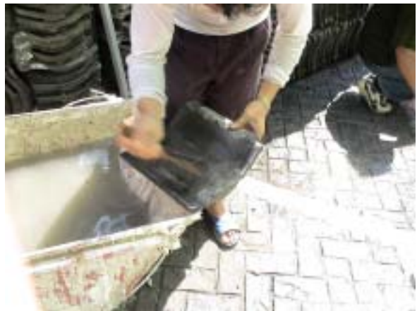
【圖版 5-264】先手工拆除
