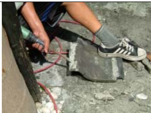
【圖版 5-265】使用工具鑽除殘留物
