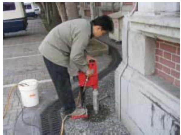
2.以專用鑽孔工具鑽孔（台環企業提供）
