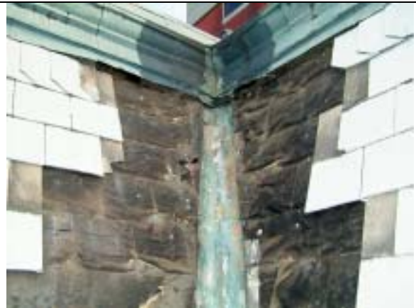
【圖版 5-218】拆除後所露出的銅皮底層
