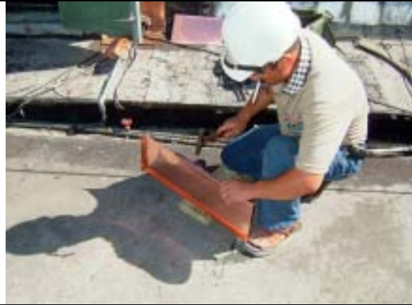
【圖版 5-145】敲擊銅材彎折邊以彎折銅材
