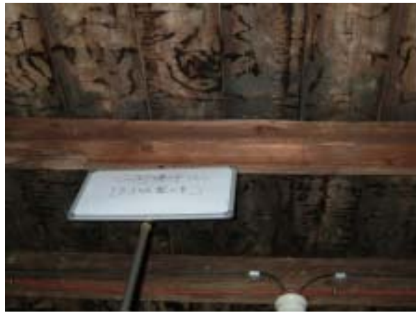
【圖版 5-84】木結構修補前 臺區，G 間 W1，B 級修復
