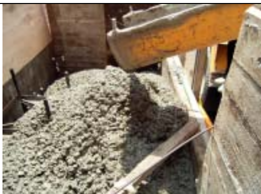
【圖版 5-9】鋼棚架基礎灌漿
