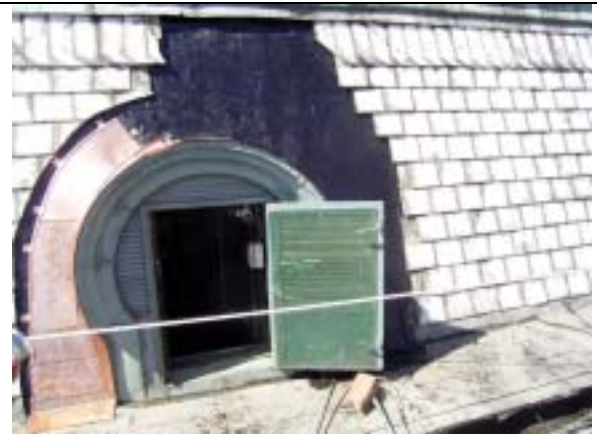
【圖版 5-170】部分完成的樣貌
