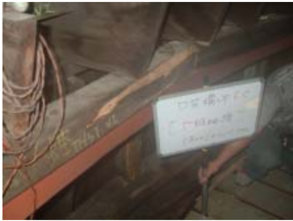
【圖版 5-90】木結構抽換前 參區，D架 6C，D 級抽換
