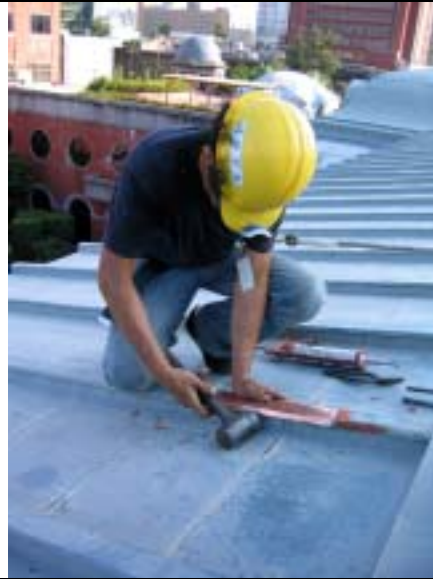
【圖版 5-188】敲擊銅瓦棒邊緣以利彎折
