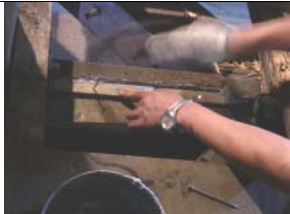
【圖版 5-66】表面清除後完成修補
