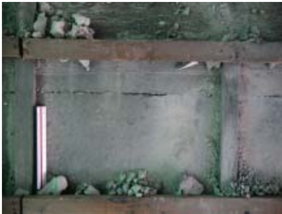
【圖版 5-257】量測舊有掛瓦條間距（以利修正施工圖說）
