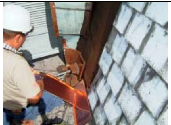
【圖版 5-166】彎折銅皮邊緣以利接合
