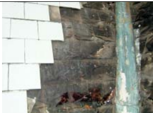
【圖版 5-219】拆除後所露出的銅皮底層
