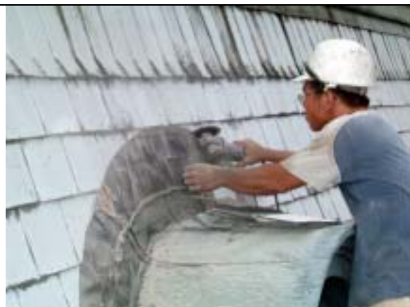
【圖版 5-213】用小型輪鋸切出施工範圍
