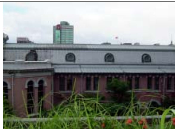
【圖版 5-220】石棉瓦拆除整體現況（第貳區）
