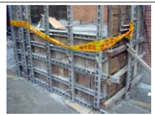
【圖版 5-10】等待灌漿凝結固化
