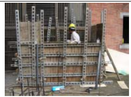
【圖版 5-6】組立基礎灌漿模板
