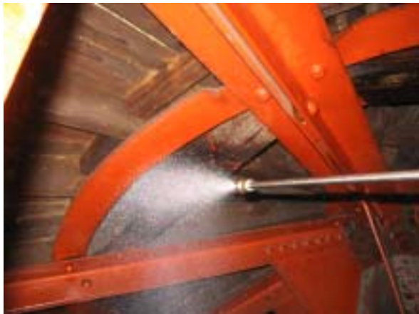
3. 舊木構件噴塗處理(台環公司提供)
