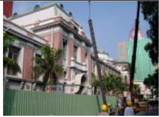
【圖版 5-12】進行吊裝鋼棚架結構體
