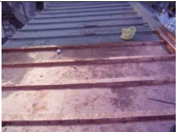
【圖版 5-197】二區屋頂銅板瓦
