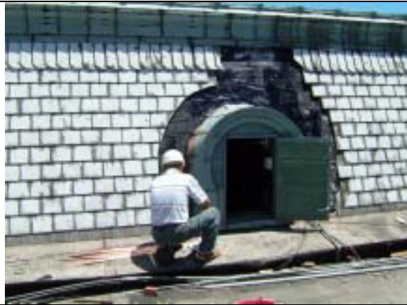
【圖版 5-108】防水工程完成後現況（第貳區，內側）
