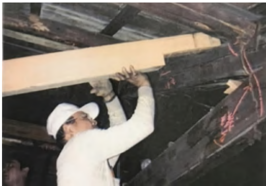
圖 2-31 緊急架木支撐(資料來源：《國定古蹟監察院白蟻防治計畫相關工程工作報告書》)
