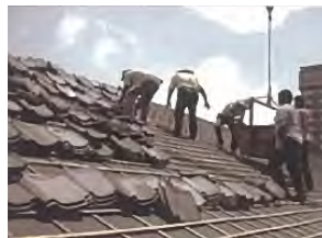
替屋頂換新裝
