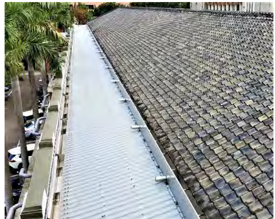
圖 2-32 監察業務處等區域上方屋頂浪板修繕情形。
