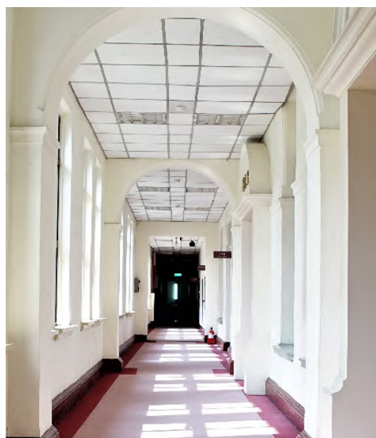
沿著 M 型樓梯往上，左側是西翼二樓走廊， 亦為同仁日常辦公處所。
