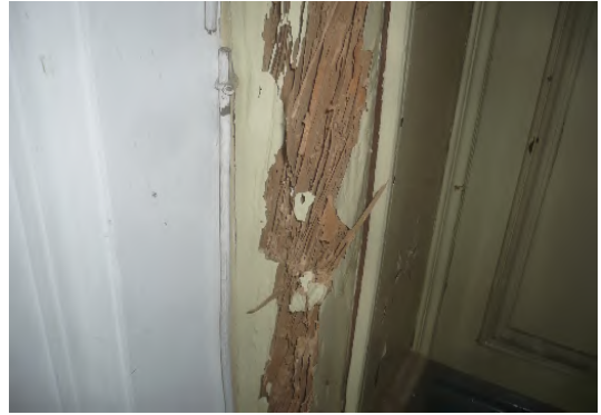
圖 2-29 白蟻侵蝕後的門框(資料來源：《國定古蹟監察院白蟻防治計畫相關工程工作報告書》)
