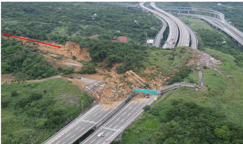
圖 5-37 99/04 北二高走山實況（資料來源：交通部高速公路局）
