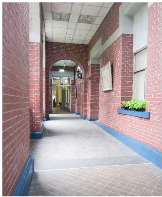
圖 2-35 一樓陳情受理中心旁走廊無障礙坡道
