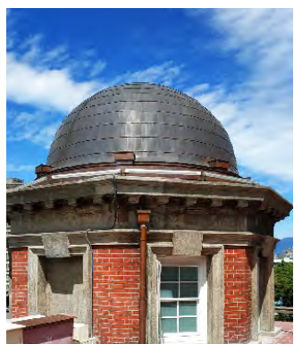
⑧ 衛塔屋頂
