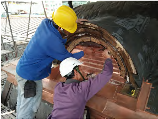
圖 2-28 牛眼窗百葉的銅板包覆施工與工藝技術展現
