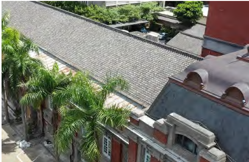
圖 2-23 完工後的北翼黑瓦屋頂（鄰近忠孝東路）
