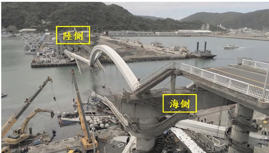
圖 5-36 108/10 南方澳大橋塌毀實況（資料來源：《國家運輸安全調查委員會 109/11/25 事故調查報告》）
