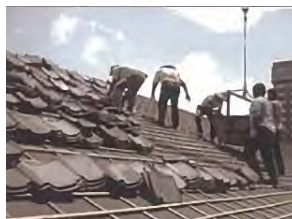
替屋頂換新裝
