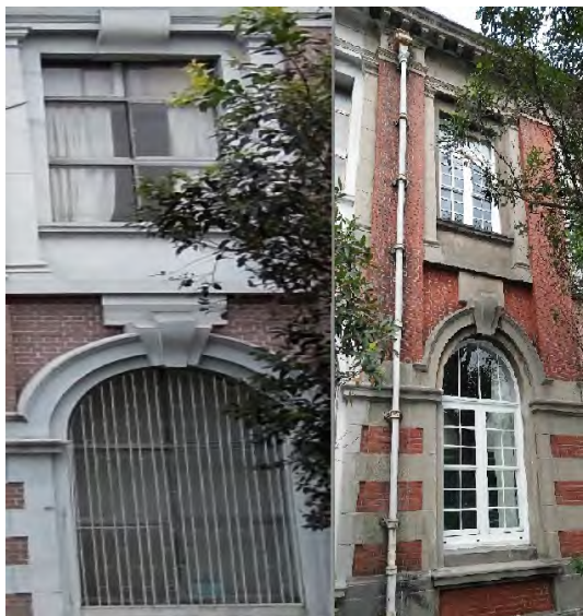
圖 2-26 修復前（左）、修復後（右）樣式及外觀
