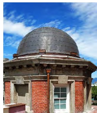
⑧ 衛塔屋頂
