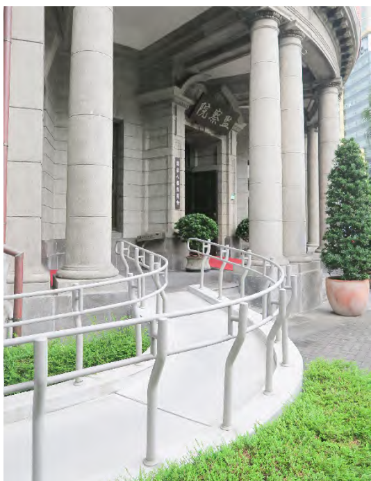
圖 2-38 大門口無障礙斜坡道
