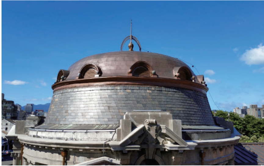
中央穹頂上之碟形圓頂，周緣有 12 個牛眼百葉窗。圓頂鋪設銅皮，以手工一塊塊拼接而成。
