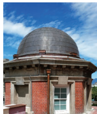
⑧ 衛塔屋頂
